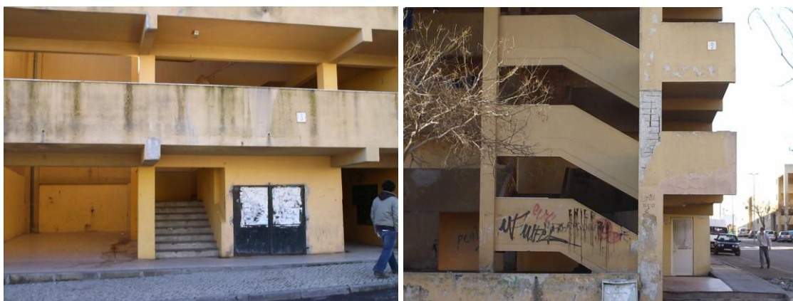
Caixas de escada
