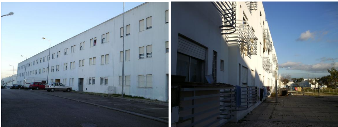
Imagem do edificado
