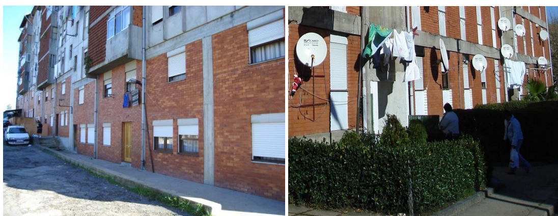
Pisos térreos de edifícios da 1ª fase
