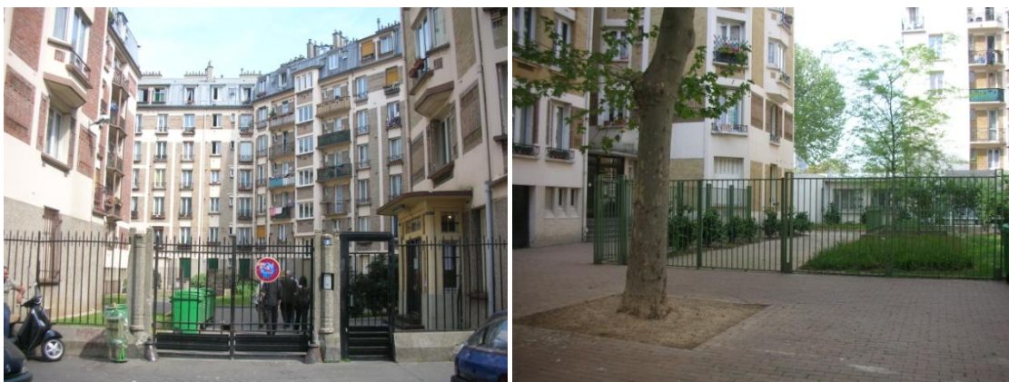
Figura 2. 27 - Porte de Clignancourt (Paris) – Intervenção para privatização dos espaços semipúblicos, vedando-os com grades metálicas, uma vez que eram áreas potenciadores de problemas, in arquivo pessoal
