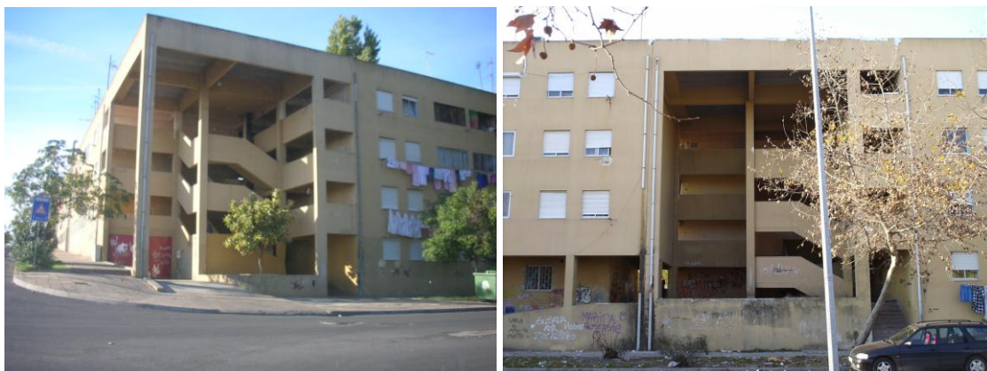
Caixas de escada
