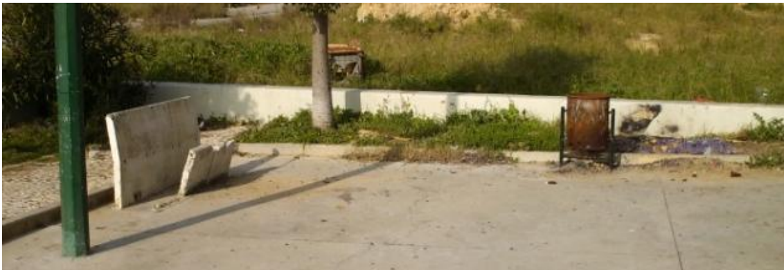
Figura 4. 63 - Mobiliário urbano danificado em área oculta no Bairro Amarelo, in “A concepção do espaço público em bairros de realojamento como pressuposto estruturador dos processos de inserção social” , FCT, 2009
