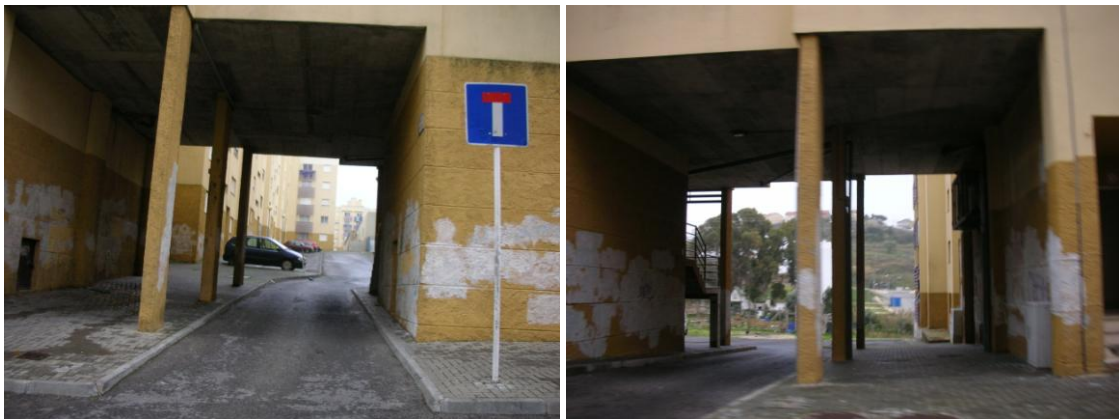
Túneis de acesso ao interior dos quarteirões
