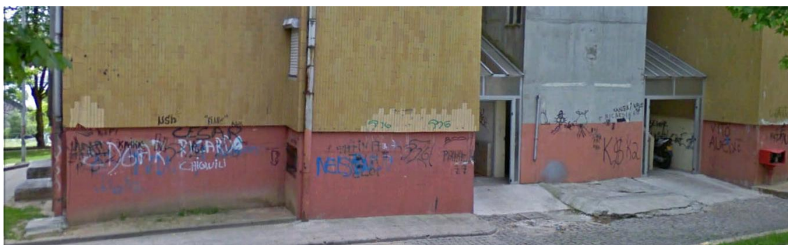
Figura 4. 73 - Entradas numa das torres do Bairro do Aleixo, in Google Earth - Google Street View
