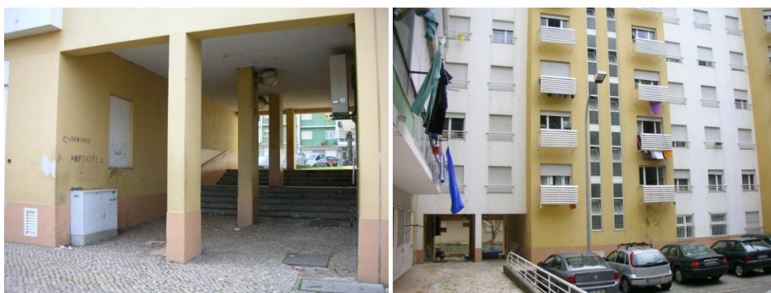
Túnel que estabelece a comunicação pedonal entre as duas ruas
