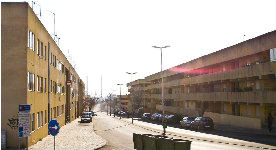
Figura 4. 10 - Avenida da Bela Vista no Bairro da Bela Vista, in arquivo do projecto de investigação: “ A concepção do espaço público em bairros de realojamento como pressuposto estruturador dos processos de inserção social ”, FCT, 2009
