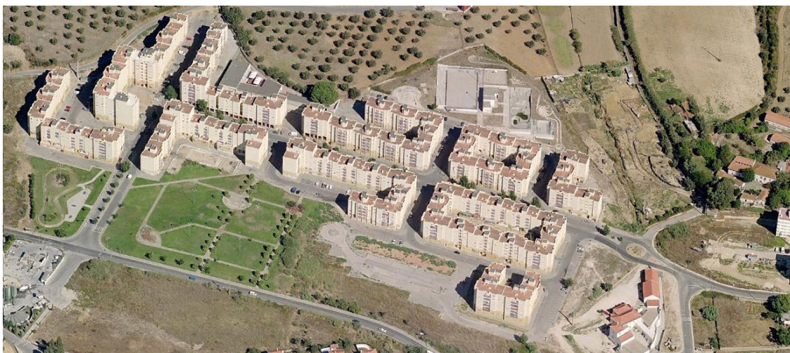
Vista aérea do bairro, Sul – Norte
