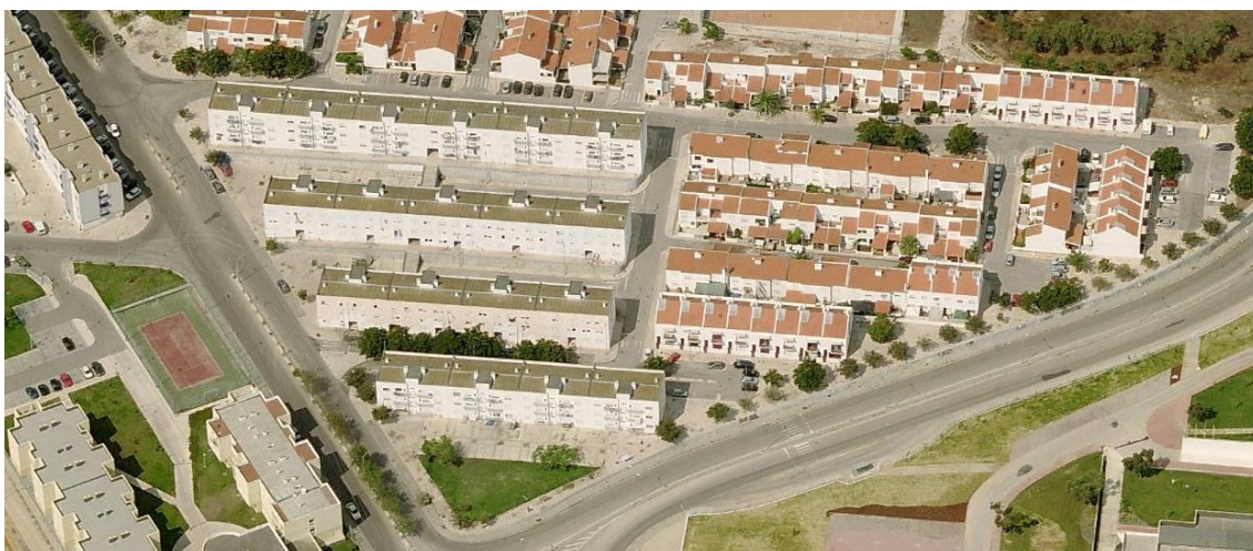
Vista aérea Sul – Norte
