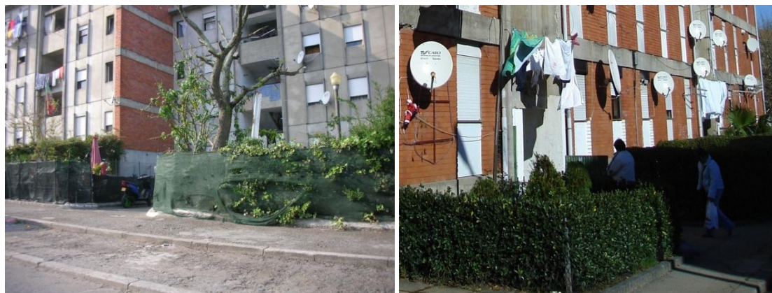
Figura 4. 84 - Edifício da 2ª fase do Bairro do Lagarteiro, in arquivo pessoal (esq.)
