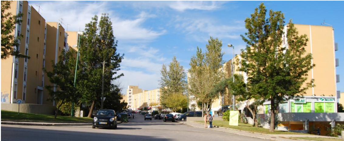
Figura 4. 32 - Entrada do Bairro Amarelo, in arquivo pessoal
