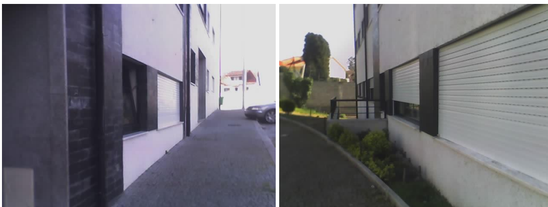
Vãos de fogos do piso térreo
