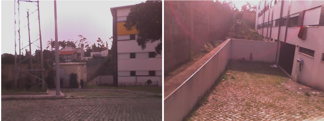
Acesso à garagem
