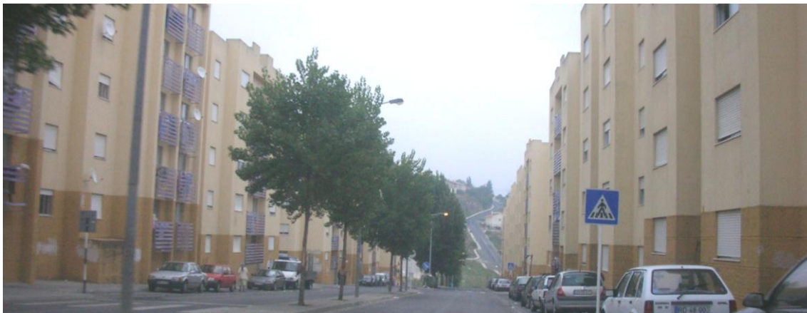
Avenida José Afonso, Oeste – Este
