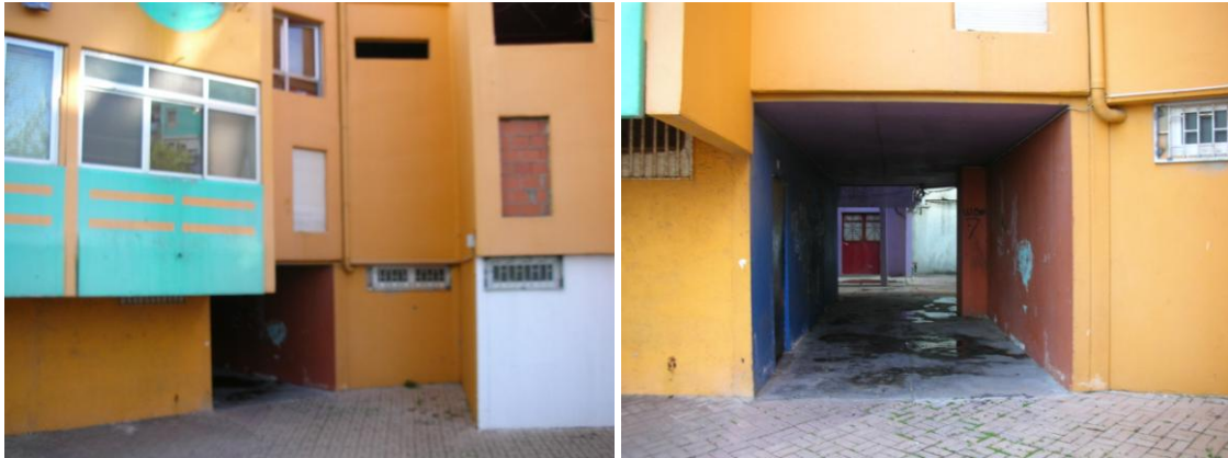
Túnel de acesso à rua interior
