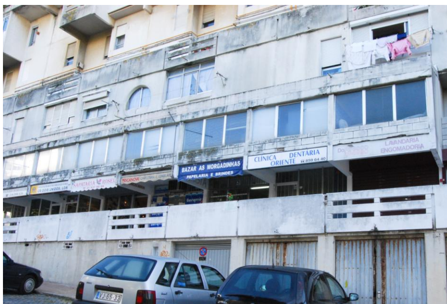
Figura 4. 45 - Comércio em galeria no Bairro do Condado, in arquivo pessoal
