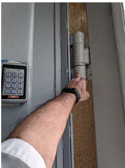
Figura 43. Detalhe da porta de entrada a estação
