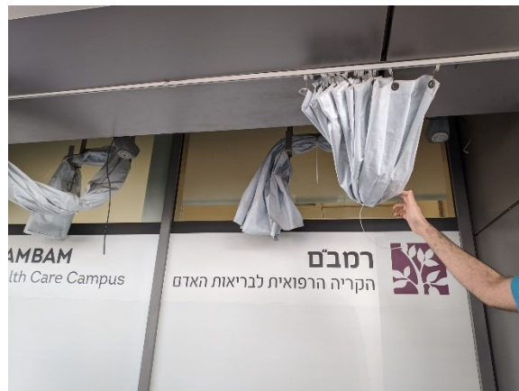
Figura 10. Detalhe dos chuveiros e cortinados junto à entrada da urgência
