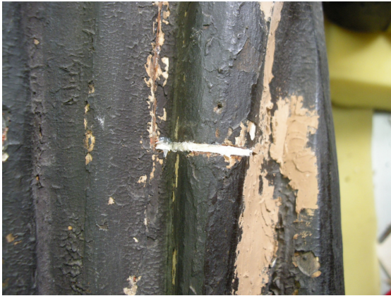
Fig.140 – Pormenor do preenchimento das fissuras com madeira balsa e PVA
