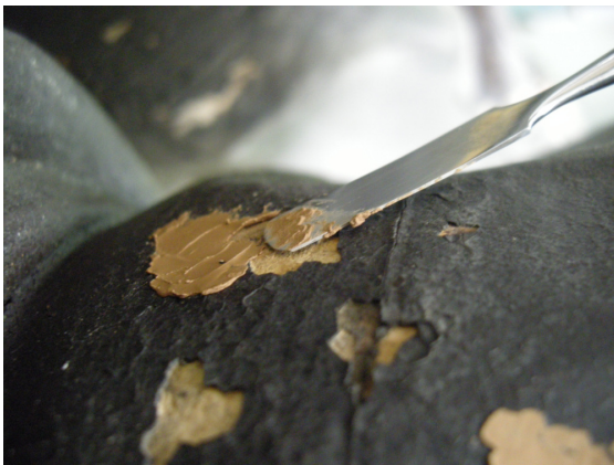
Fig.234 – Pormenor da aplicação de Modostuc© castanheira, recorrendo-se ao uso da espátula
