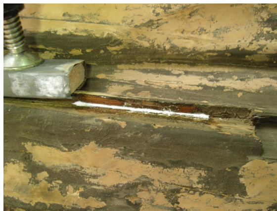
Fig.142 – Pormenor do preenchimento das fissuras com madeira balsa e PVA
