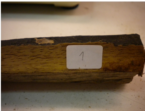
Fig.63 – Pormenor do elemento que se destacou onde foi retirada amostra do corte tangencial
