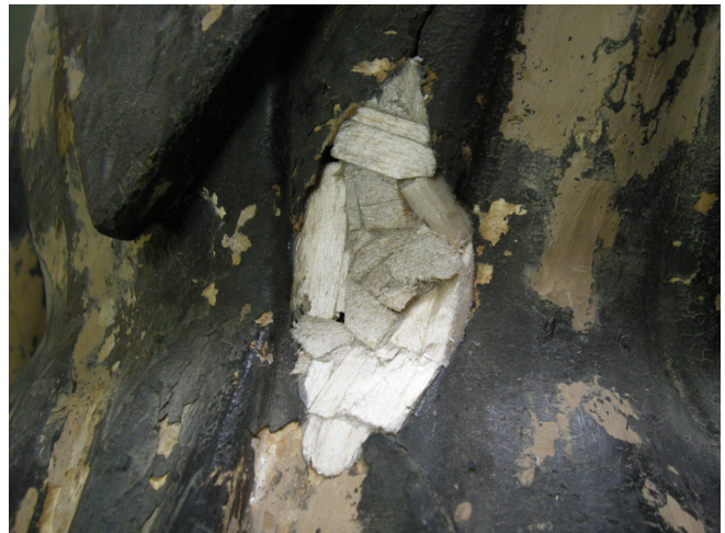
Fig.137 – Pormenor do aspecto final de uma lacuna preenchida com o sistema de parquetagem
