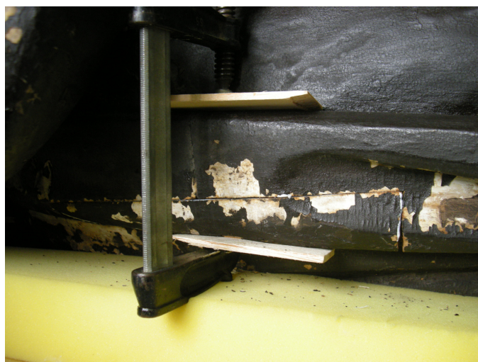
Fig.122 – Pormenor do uso de grampos durante a colagem
