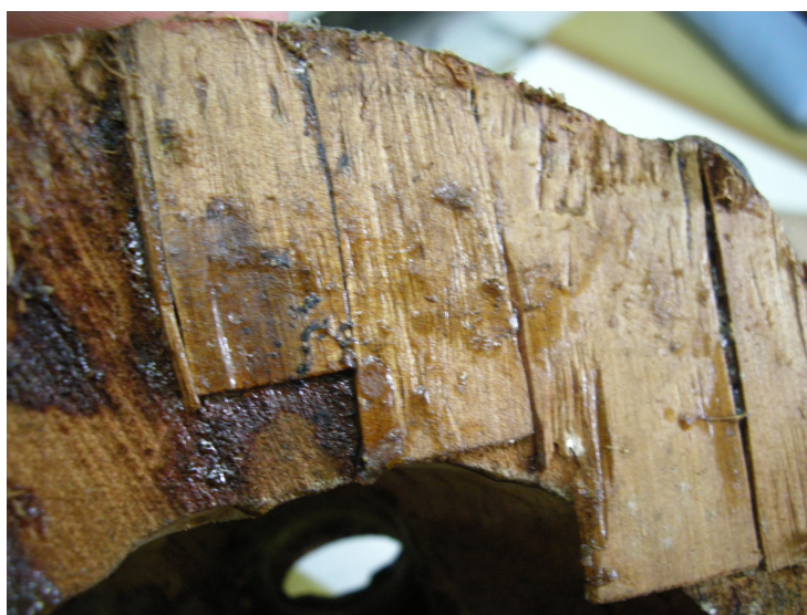
Fig.164 – Pormenor de uma zona onde se removeu o adesivo original
