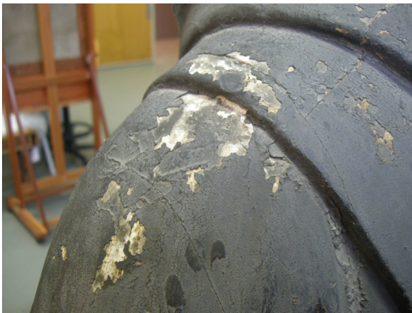
Fig.27 – Pormenor do destacamento da policromia no ombro esquerdo
