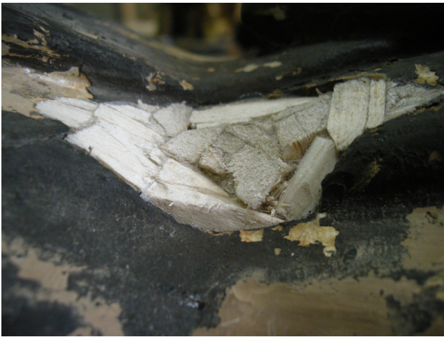
Fig.136 – Pormenor do aspecto final de uma lacuna preenchida com o sistema de parquetagem
