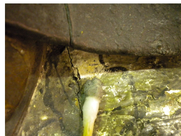
Fig.188 - Pormenor da limpeza com a solução de limpeza superficial na peanha
