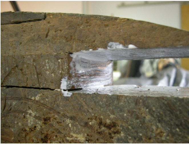
Fig.116 – Pormenor da aplicação de PVA na zona de destacamento
