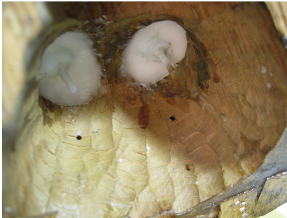
Fig.174 – Pormenor dos orifícios onde serão colocados os reforços
