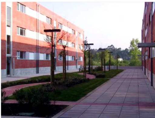
Fig.9 – Habitação social na Maia, projecto do Arq. João Carlos Santos.
