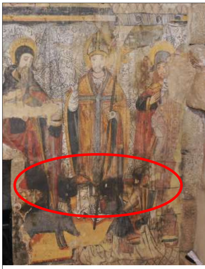
Figura 13: Pintura mural localizada na parede esquerda da nave da igreja, com detalhe para mancha negra localizada na região dos pés dos santos.
