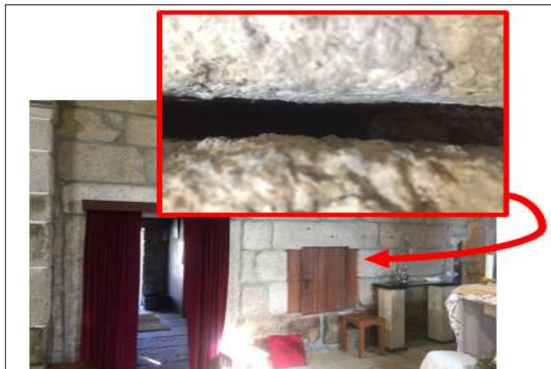
Figura 34: Nicho com portinhola existente na parede lateral da capela mor, onde se nota a separação entre ambos os panos que compõem a parede fortificada, provavelmente dupla. Créditos: João Sandes, 2020
