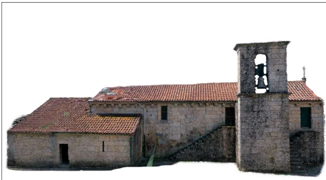
Figura 25: Vista 3D superior, Alçado lateral norte da igreja, obtido com as imagens fotogramétricas onde se utilizou o Photoshop para limpar a poluição visual do seu contorno. Créditos: João Sandes, 2020
