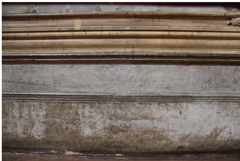
Figura 13- Camada inferior mais resistente que a camada superior. (Inês Magalhães ©)
