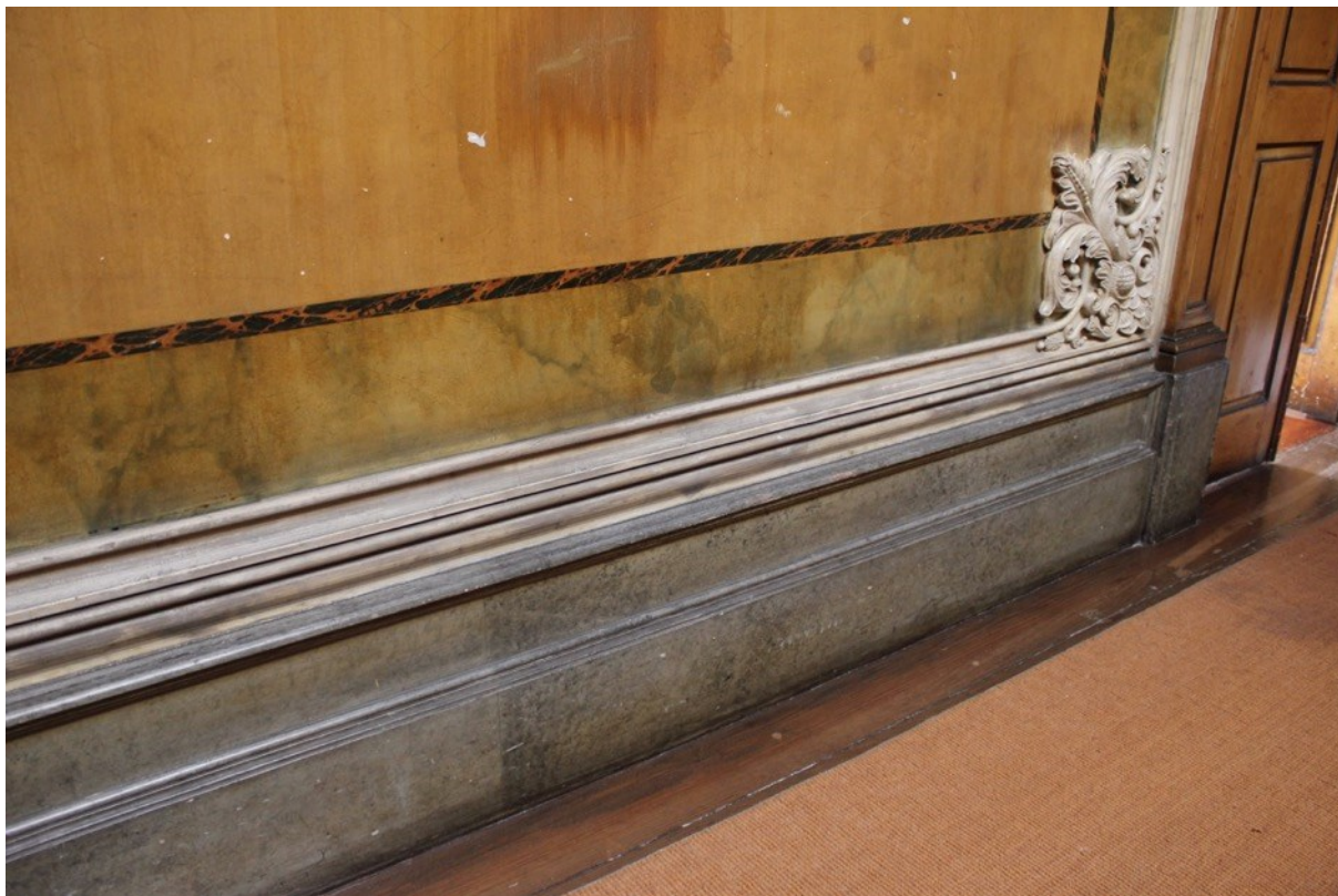
Figura 158- Antes da intervenção parede III. (Inês Magalhães ©)
