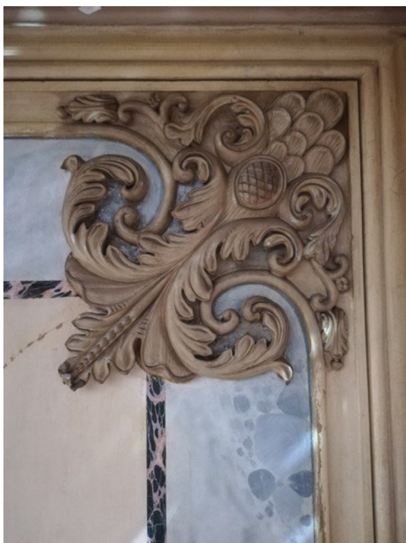
Figura 98- Limpeza da pintura no interior dos ornatos. (Inês Magalhães ©)
