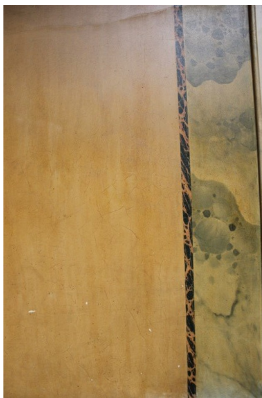
Figura 66- Oxidação do verniz parede III. (Inês Magalhães ©)
