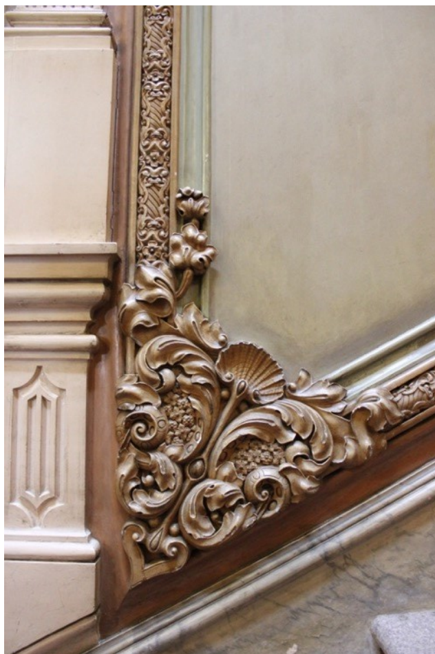
Figura 27- Ornatos em estuque e fingidos de pedra no rodapé em suporte de madeira. (Inês Magalhães ©)
