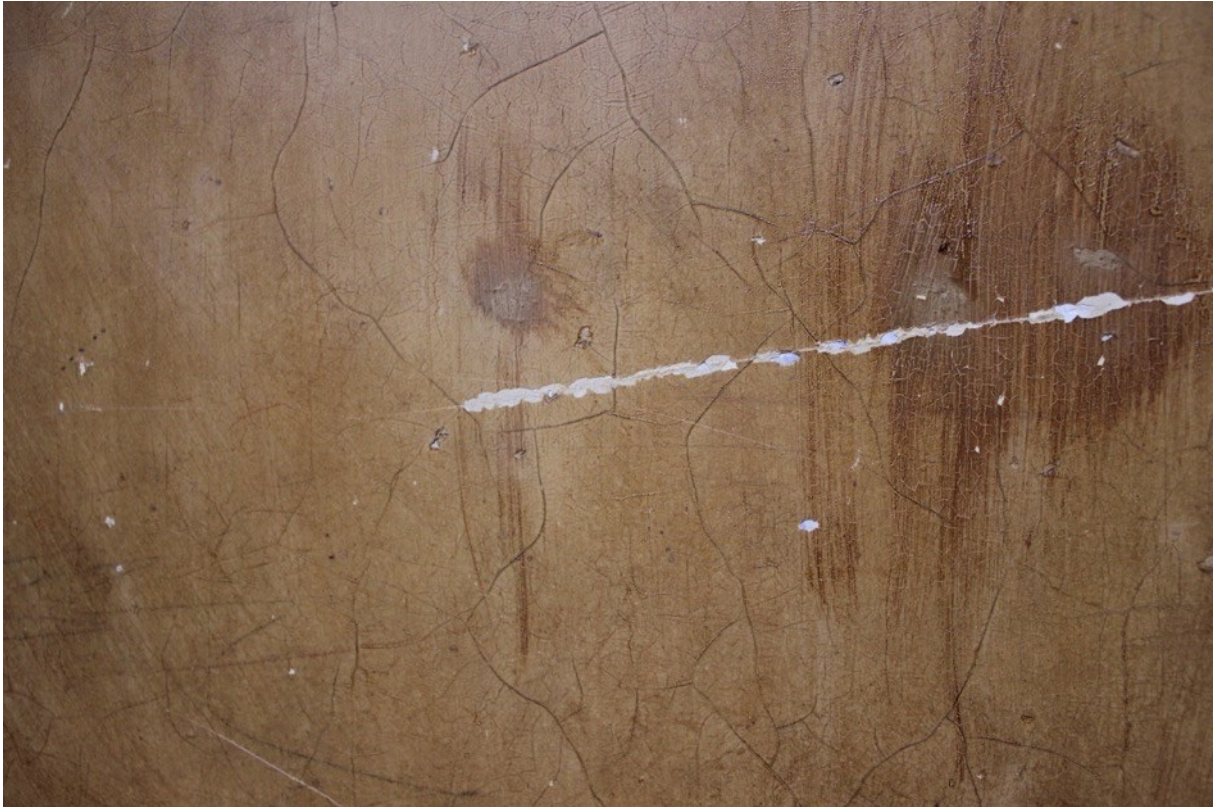
Figura 62- Abrasão provocado acidentalmente Parede I. (Inês Magalhães ©)
