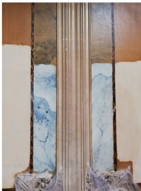
Figura 102- Aspeto após a limpeza com etanol. (Inês Magalhães ©)
