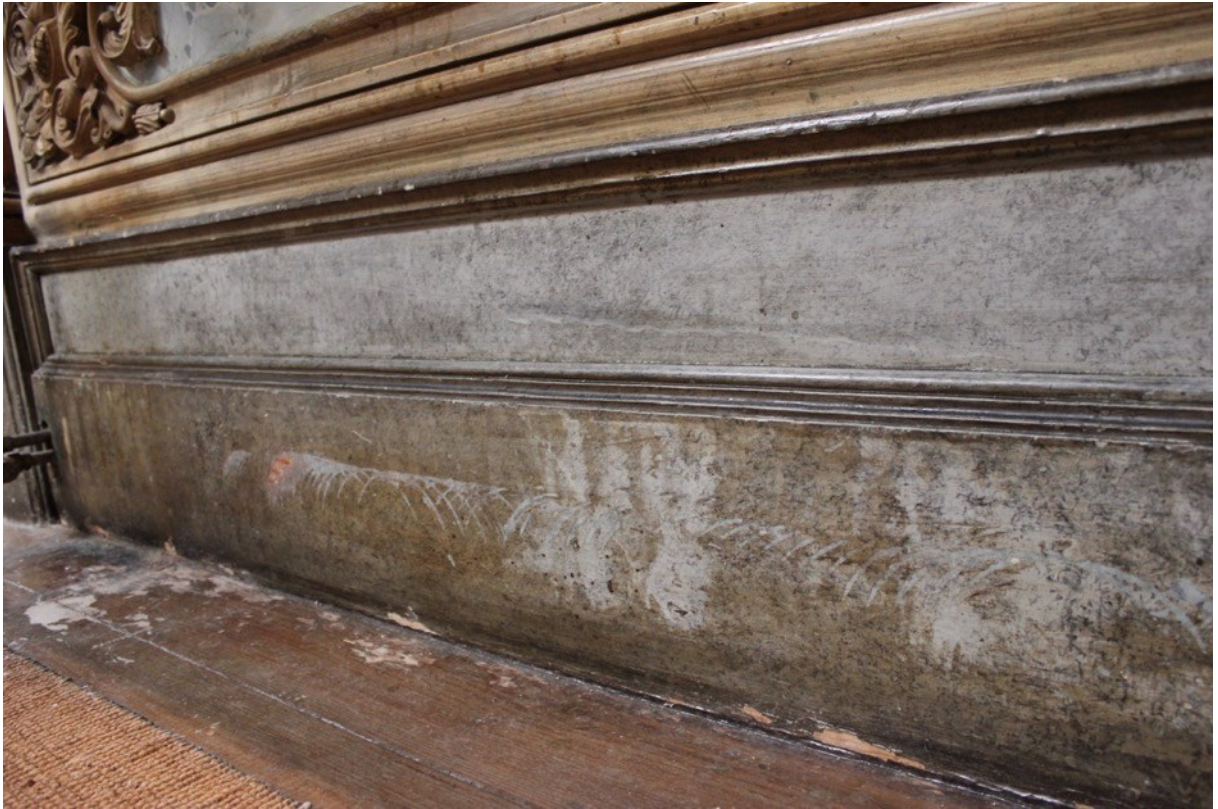
Figura 130- Limpeza rodapé parede I. (Inês Magalhães ©)
