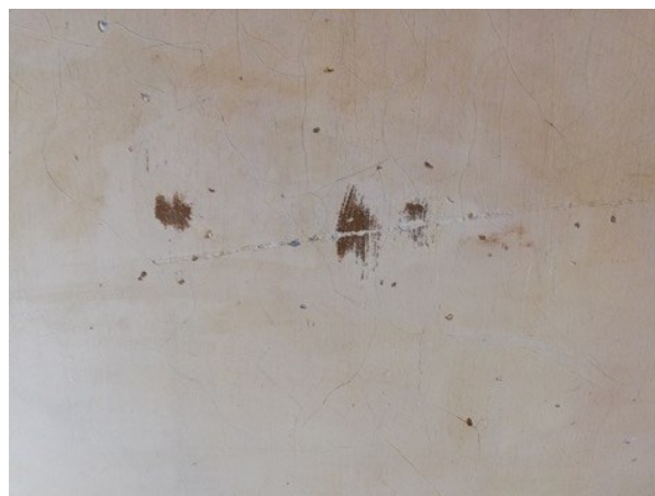
Figura 104- Processo de remoção do repinte Parede III. (Inês Magalhães ©)
