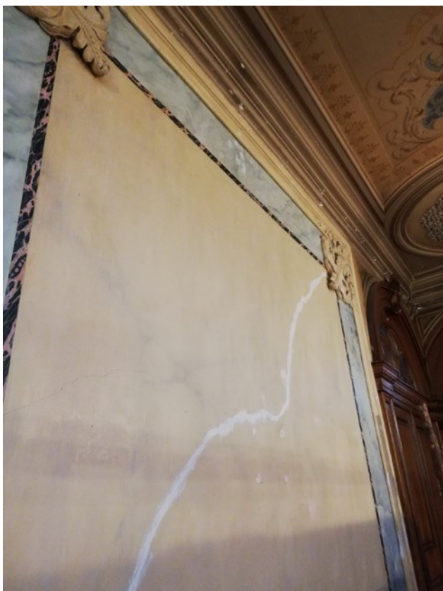
Figura 111- Preenchimento da fissura principal parede I. (Inês Magalhães ©)
