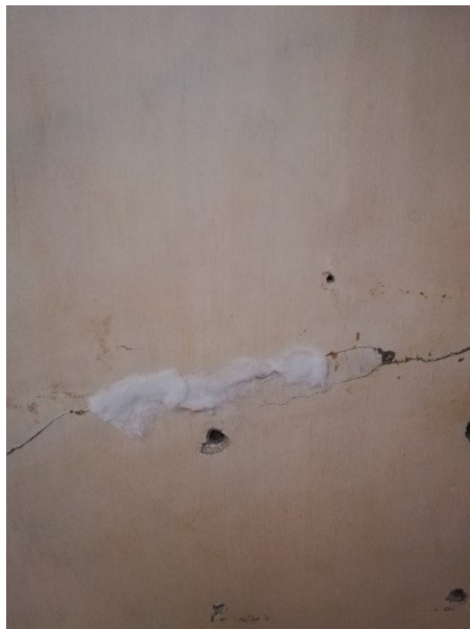
Figura 100- Pacho de etanol para eliminar sujidade entre a fissura. (Inês Magalhães ©)
