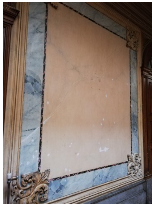
Figura 5- Preenchimentos das lacunas Parede I. (Inês Magalhães ©)
