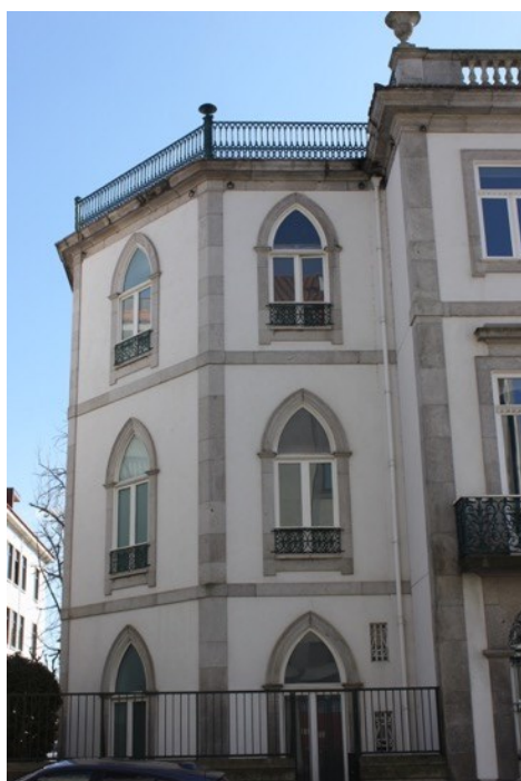
Figura 17 - Estrutura acrescentada ao corpo principal do edifício. (Inês Magalhães ©)
