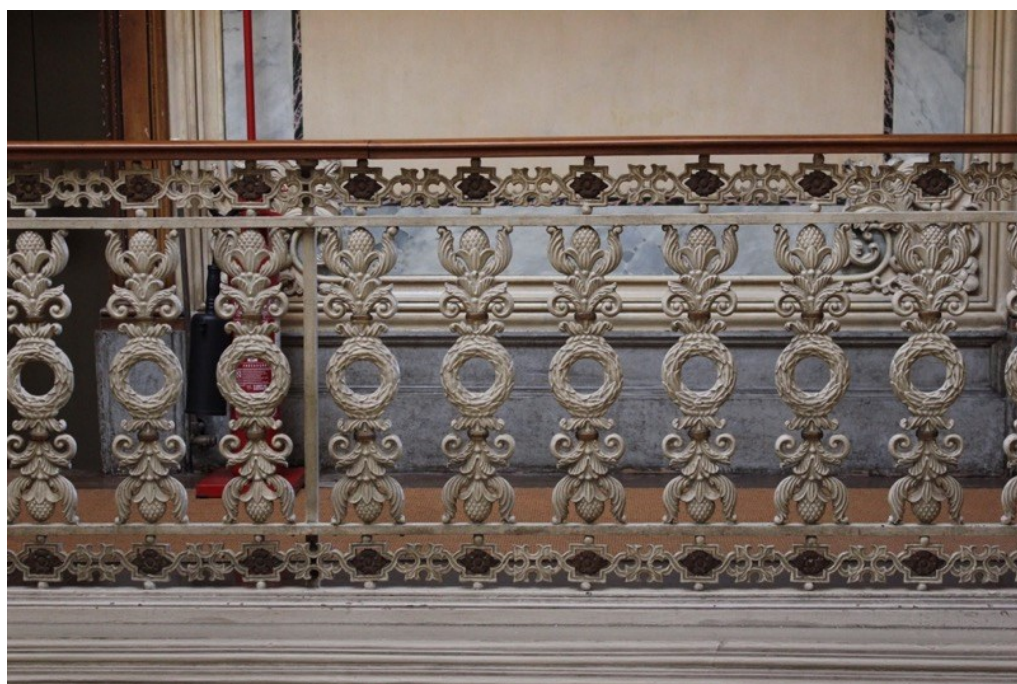
Figura 25- Gradeamento metálico (ferragens). (Inês Magalhães ©)
