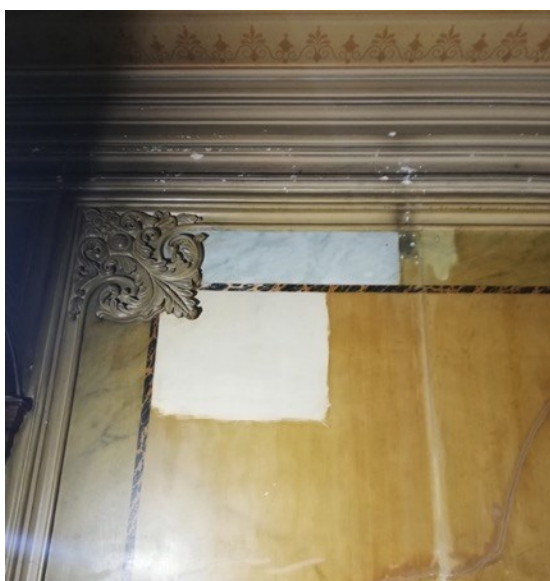
Figura 89- Início da limpeza com etanol do revestimento final - Pintura I. (Inês Magalhães ©)
