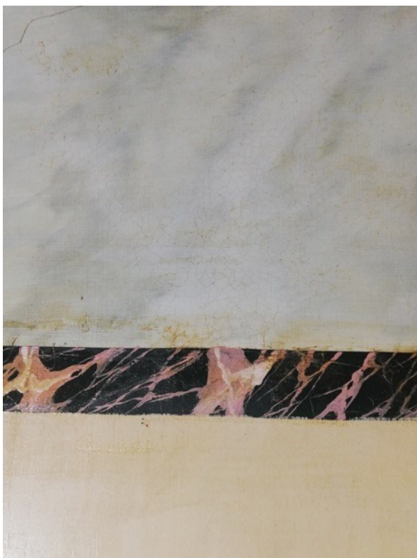
Figura 95 e 96- Restos de verniz na superfície após a primeira aplicação de etanol. (Inês Magalhães ©)
