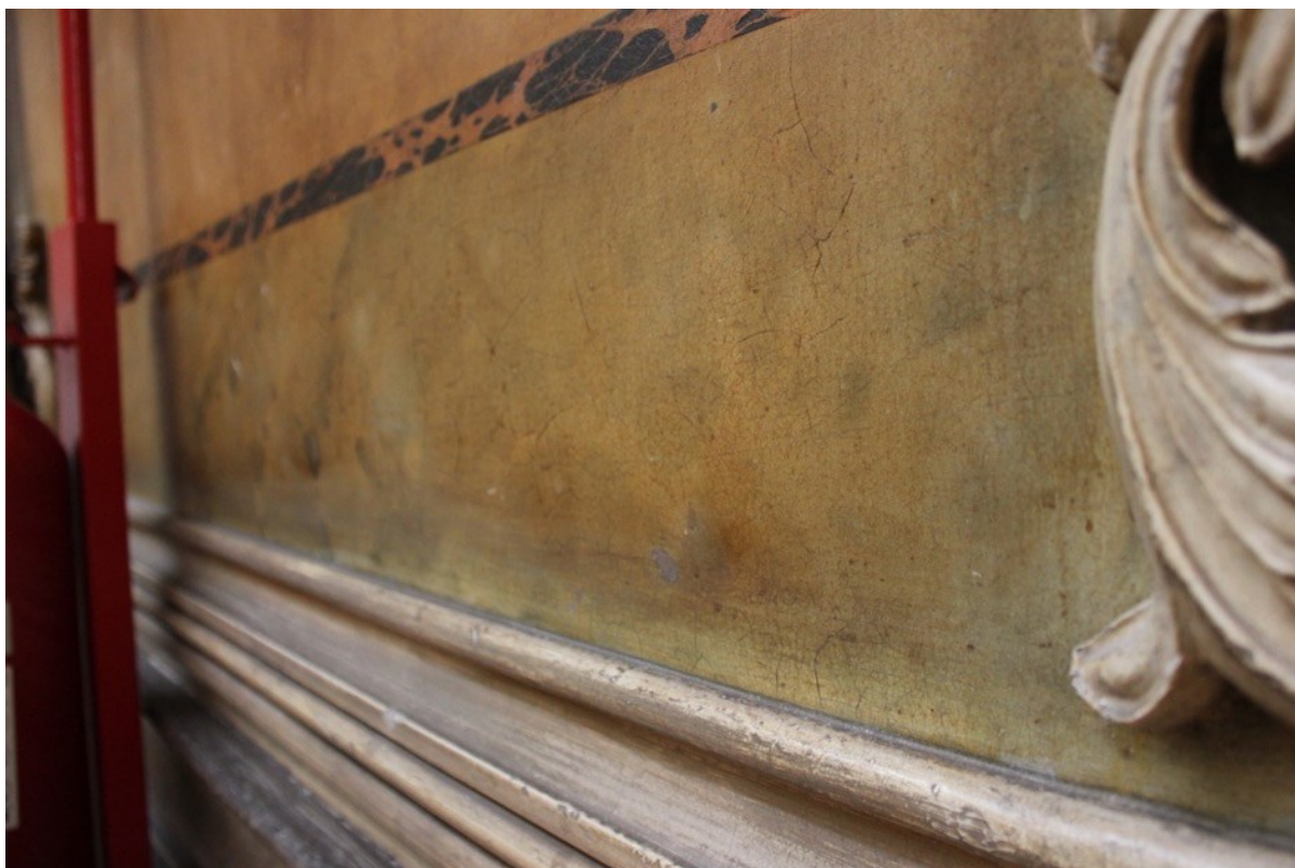
Figura 136- Antes da limpeza Parede I. (Inês Magalhães ©)
