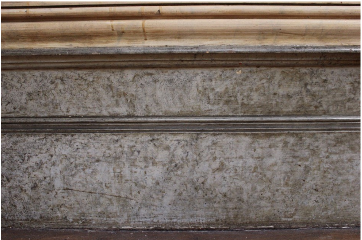
Figura 131- Rodapé parede III depois da primeira limpeza com gel de hidropopilcelulose Klucel G diluído em etanol e acetona. (Inês Magalhães ©)
