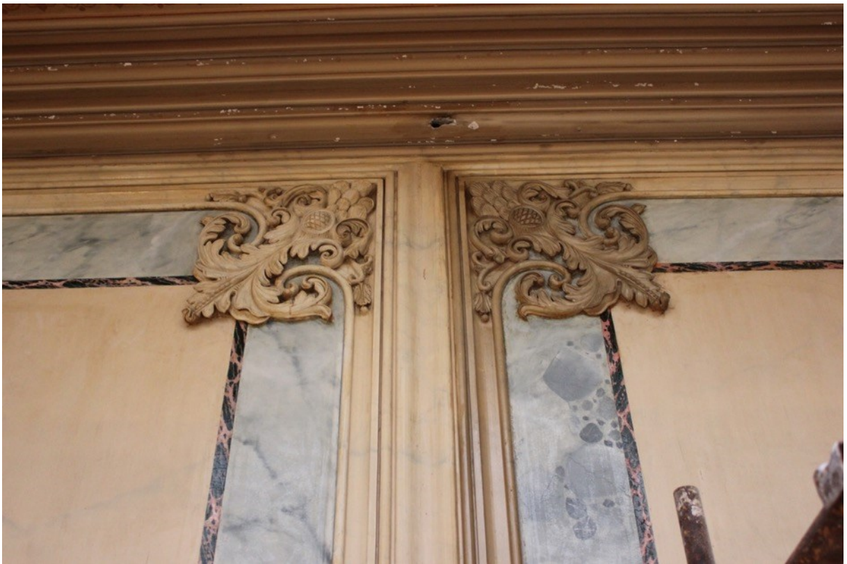
Figura 128- Processo de limpeza nos ornatos Parede III. (Inês Magalhães ©)
