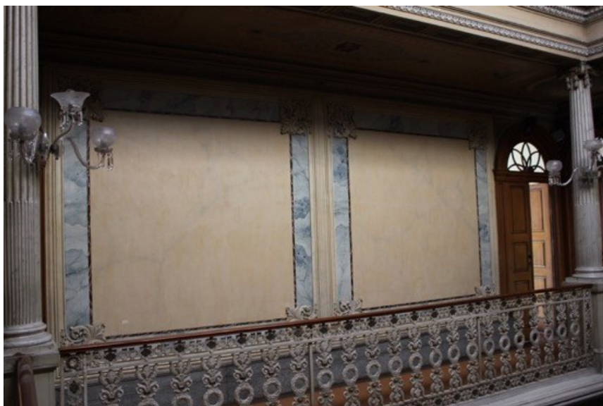
Figura 9- Resultado da aplicação do verniz de proteção final parede III. (Inês Magalhães ©)
