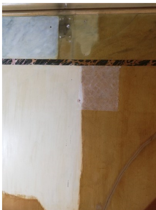
Figura 90- Pacho com papel absorvente embebido em etanol. (Inês Magalhães ©)
