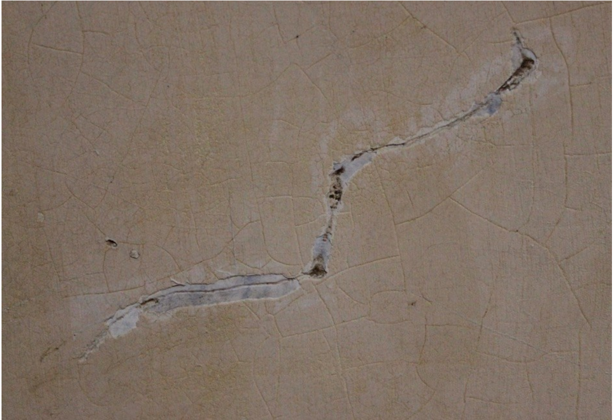
Figura 115- Antes da abertura de uma janela para registo do fingido na camada interior. (Inês Magalhães ©)
