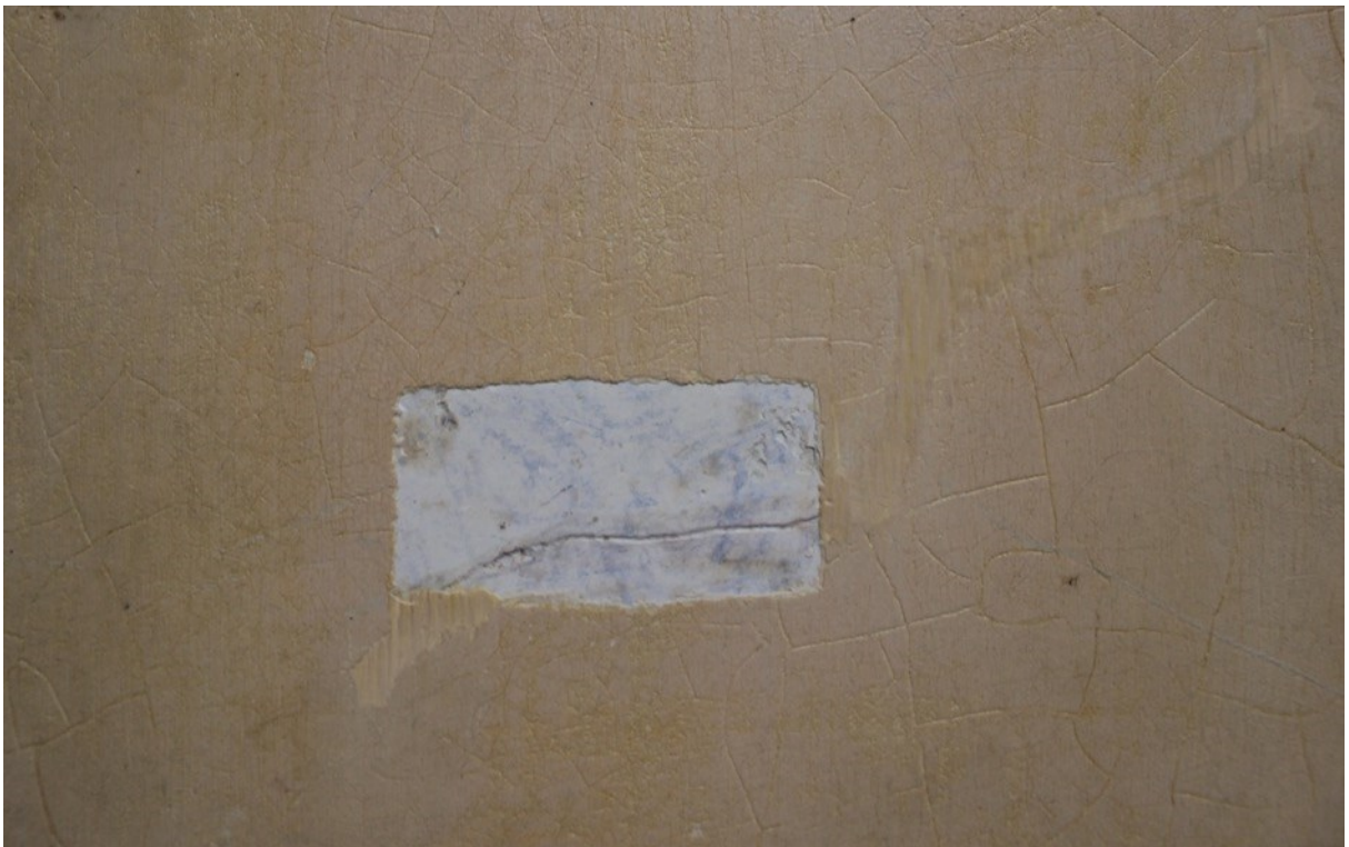
Figura 116- Depois da abertura de uma janela para registo do fingido na camada inferior. (Inês Magalhães ©)
