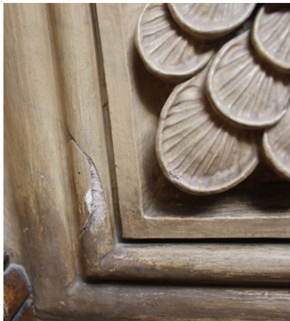
Figura 126- Lacuna volumétrica parede III. (Inês Magalhães ©)
