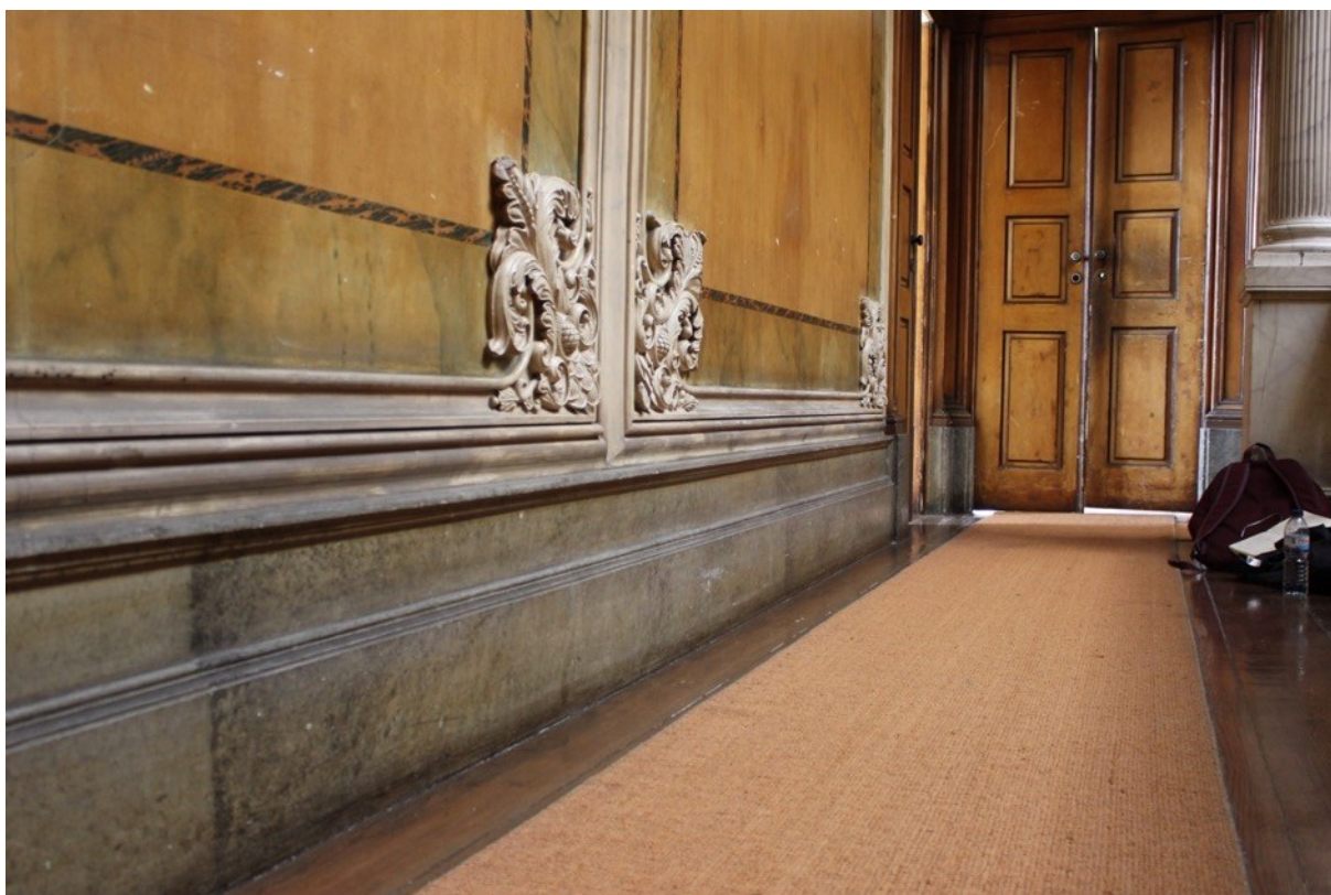
Figura 142- Antes da intervenção pintura III. (Inês Magalhães ©)
