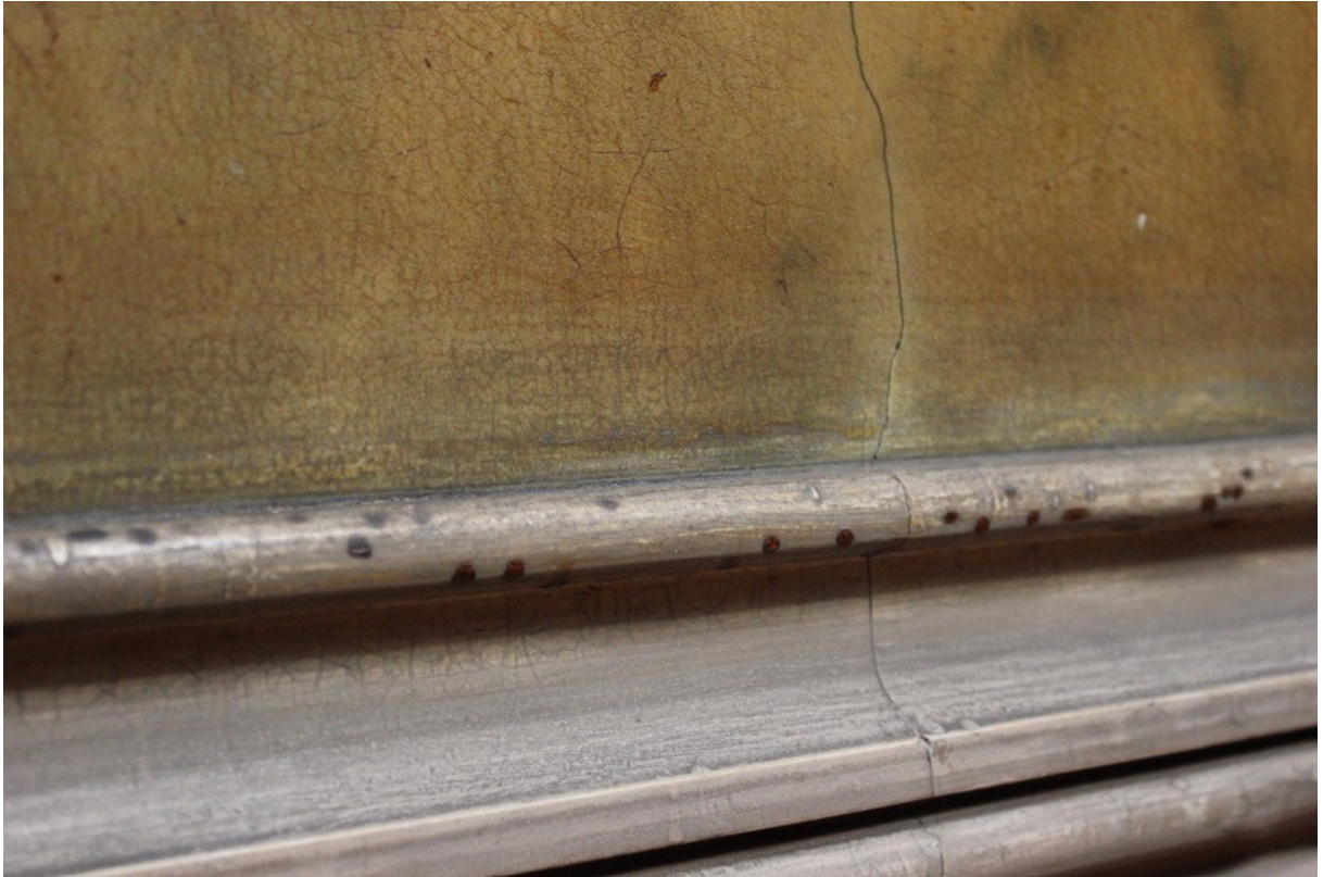
Figura 156- Antes da intervenção pigmentação preta na moldura parede III. (Inês Magalhães ©)
