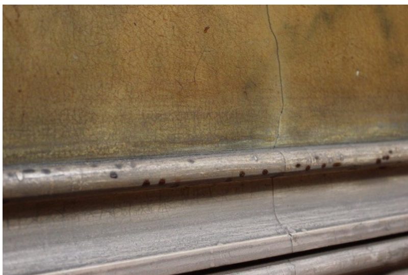
Figura 72- Pigmentação preta na moldura Parede III. (Inês Magalhães ©).
