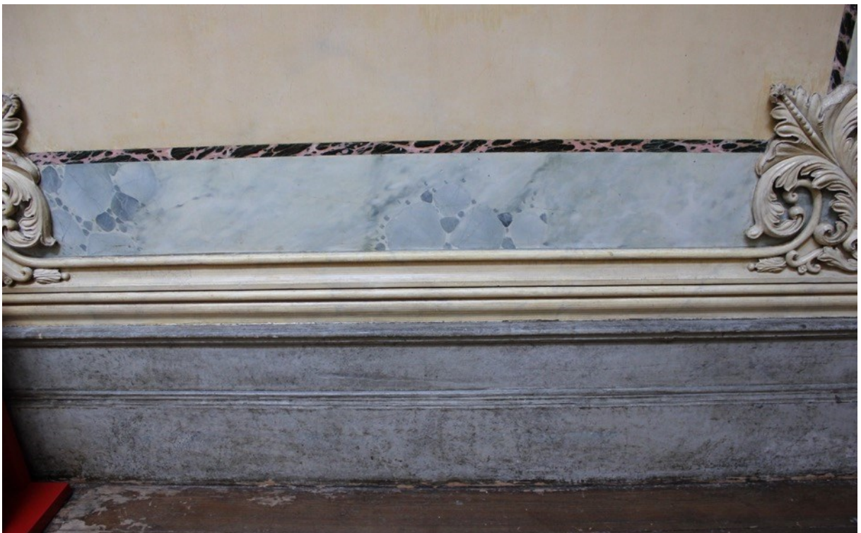
Figura 139- Rodapé depois da intervenção parede I. (Inês Magalhães ©)
