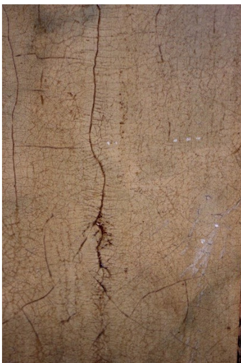
Figura 69- Fissura de onde sai do seu interior uma espécie de resina. (Inês Magalhães ©)
