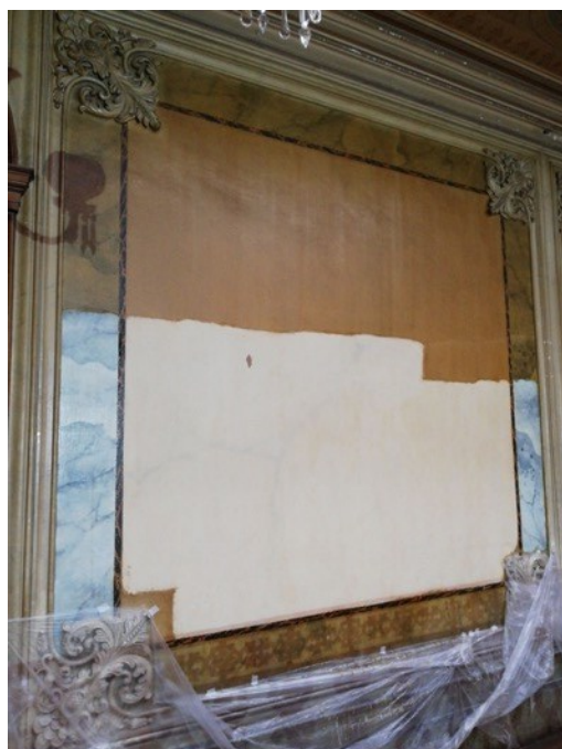
Figura 101- Início da limpeza Parede III. (Inês Magalhães ©)
