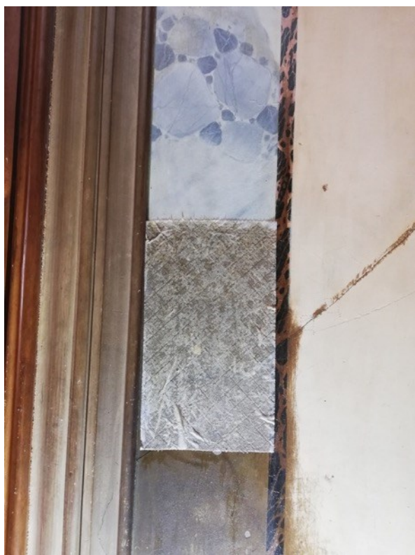
Figura 93- Limpeza com papel absorvente embebido em etanol. (Inês Magalhães ©)
