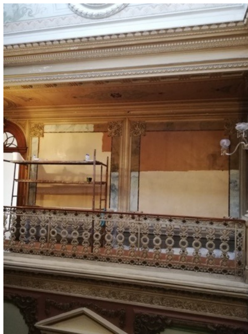
Figura 107- Limpeza parede III. (Inês Magalhães ©)
