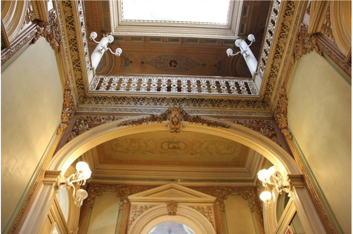
Figura 18- Vista da escadaria principal. (Inês Magalhães ©)
