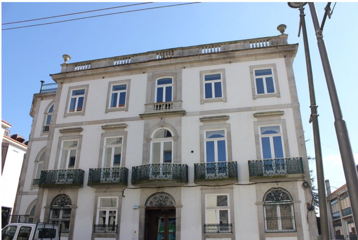
Figura 15 - Fachada Casa do Vinho Verde. (Inês Magalhães ©)
