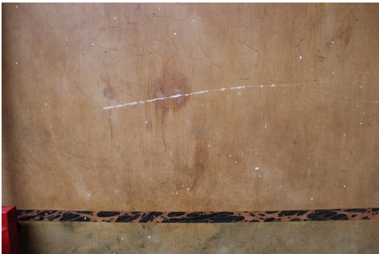
Figura 140- Antes da intervenção Parede I. (Inês Magalhães ©)
