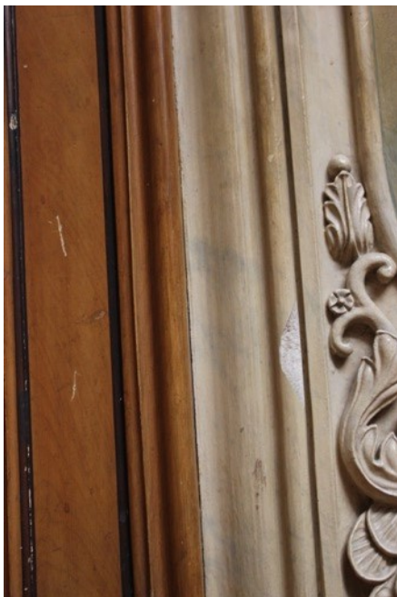
Figura 125- Lacuna volumétrica parede III. (Inês Magalhães ©)
