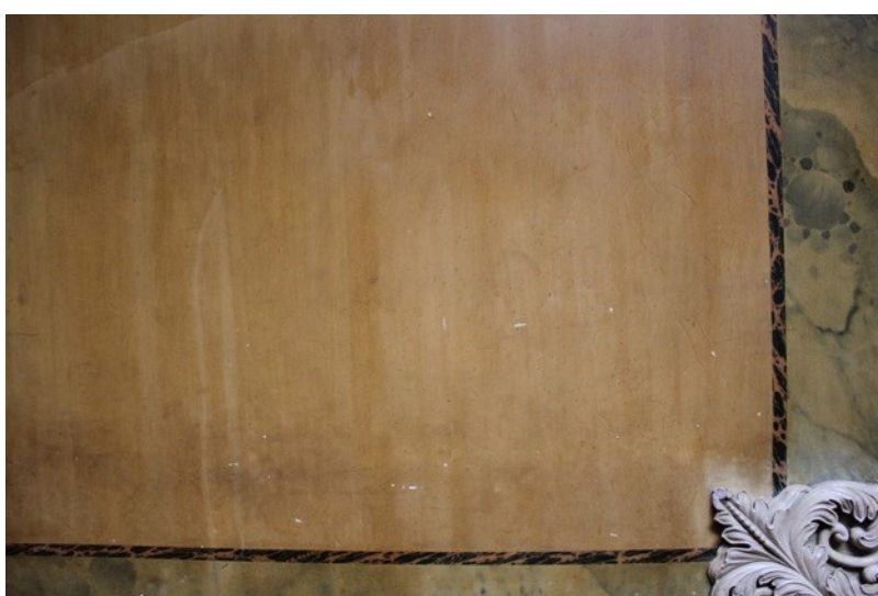
Figura 73- Lacunas e pigmentação preta na camada cromática Parede III. (Inês Magalhães ©)
