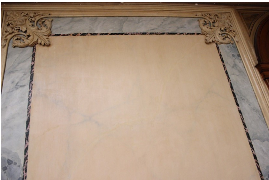
Figura 114- Resultado final reintegração cromática parede I. (Inês Magalhães ©)
