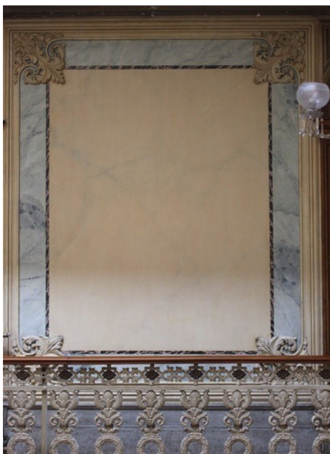
Figura 8- Resultado da aplicação do verniz de proteção final parede I. (Inês Magalhães ©)
