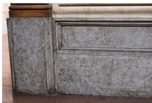
Figura 149- Depois da limpeza do rodapé. (Inês Magalhães ©)
