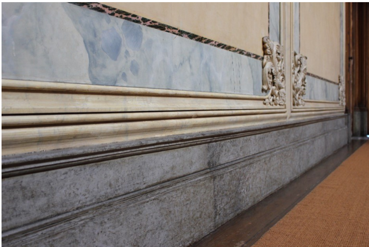
Figura 143- Depois da intervenção parede III. (Inês Magalhães ©)
