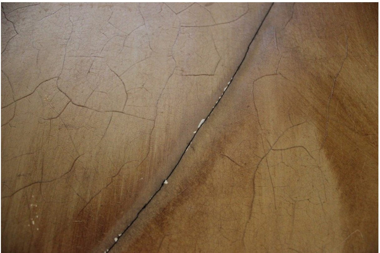
Figura 52- Fissura e manchas de repintes Parede I. (Inês Magalhães ©)
