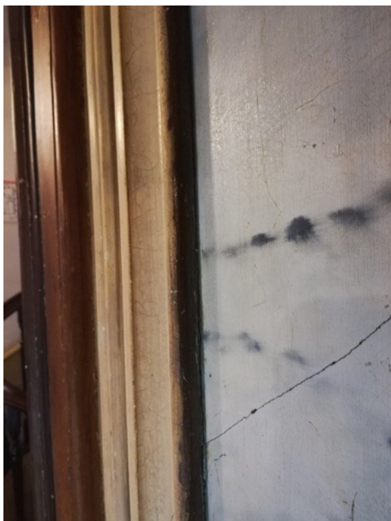
Figura 117- Estuque queimado provocado pelo aquecedor. (Inês Magalhães ©)
