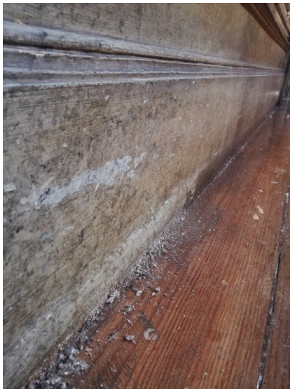
Figura 14- Remoção mecânica da camada do verniz junto ao pavimento. (Inês Magalhães ©)
