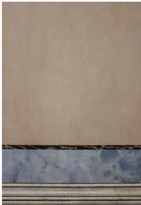
Figura 151- Depois limpeza da almofada da pintura parede III. (Inês Magalhães ©)
