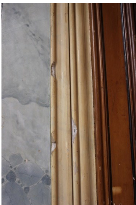
Figura 12- Lacunas volumétricas moldura. (Inês Magalhães ©)
