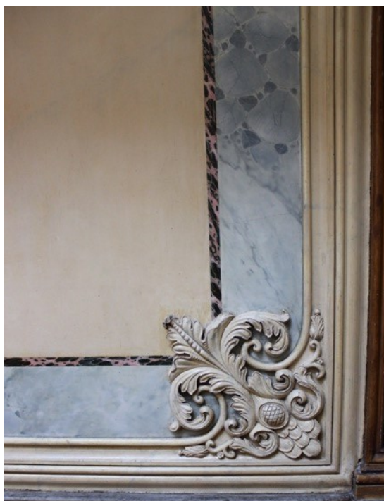
Figura 132- Depois da intervenção moldura parede I. (Inês Magalhães ©)
