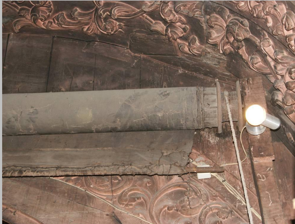
Figura 83: Pormenor do tambor com a pintura enrolada, onde se verifica a presença da trave na margem inferior.
