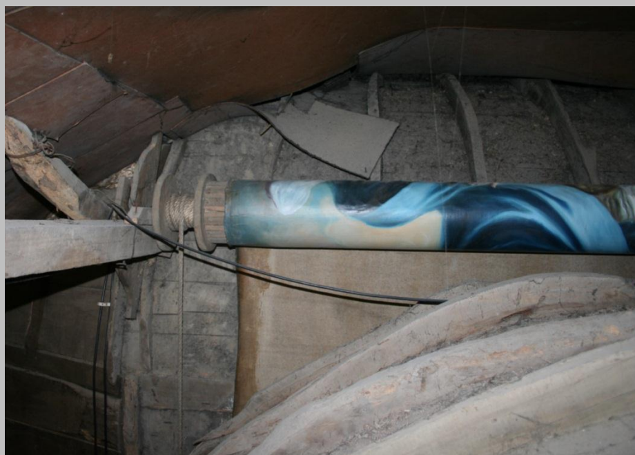
Figura 152: Pormenor do tambor, com a pintura enrolada, situado no coroamento do retábulo.
