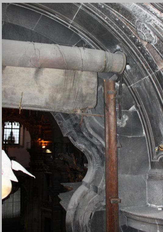
Figura 138: Pormenor do tambor com a pintura enrolada onde se verifica a presença da trave metálica e da calha lateral.
