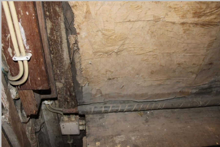
Figura 146: Pormenor da trave metálica e da calha lateral.
