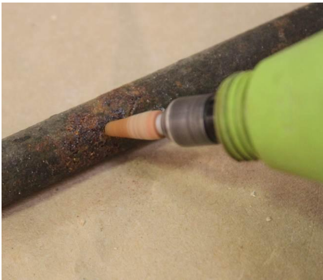
Figura 44: Tratamento da trave metálica - remoção mecânica pontual do produto de oxidação.
