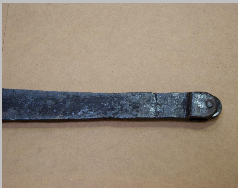
Figura 134: Pormenor da trave metálica com rodízio na extremidade.
