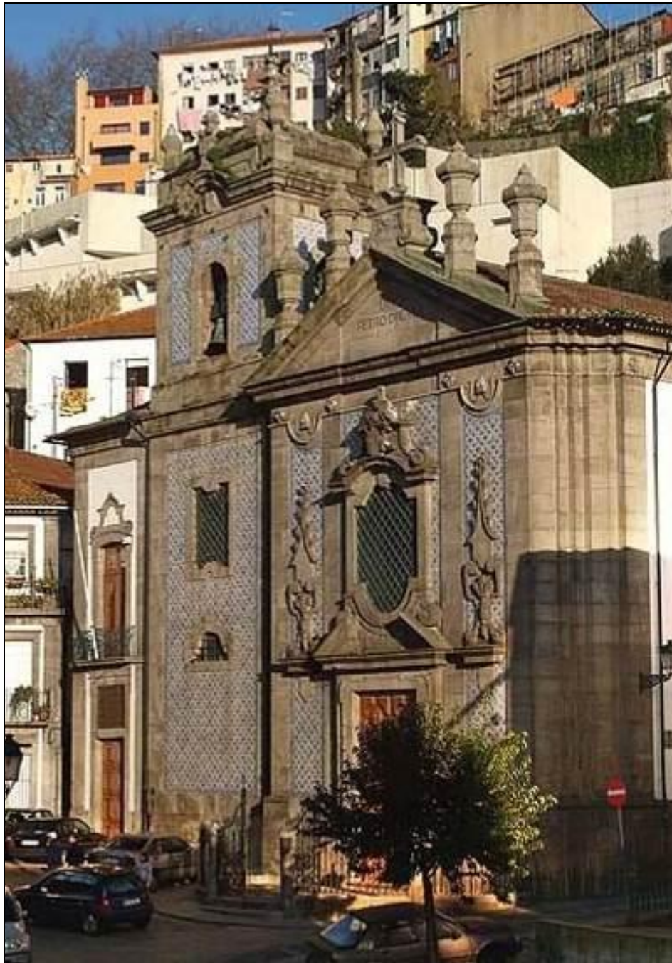
Figura 1: Fachada da Igreja Paroquial de S. Pedro de Miragaia, Porto.
