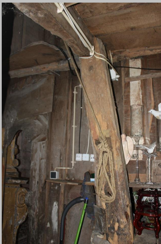
Figura 148: Pormenor do nó executado na corda que segura e aciona o sistema de enrolamento localizado na sacristia.
