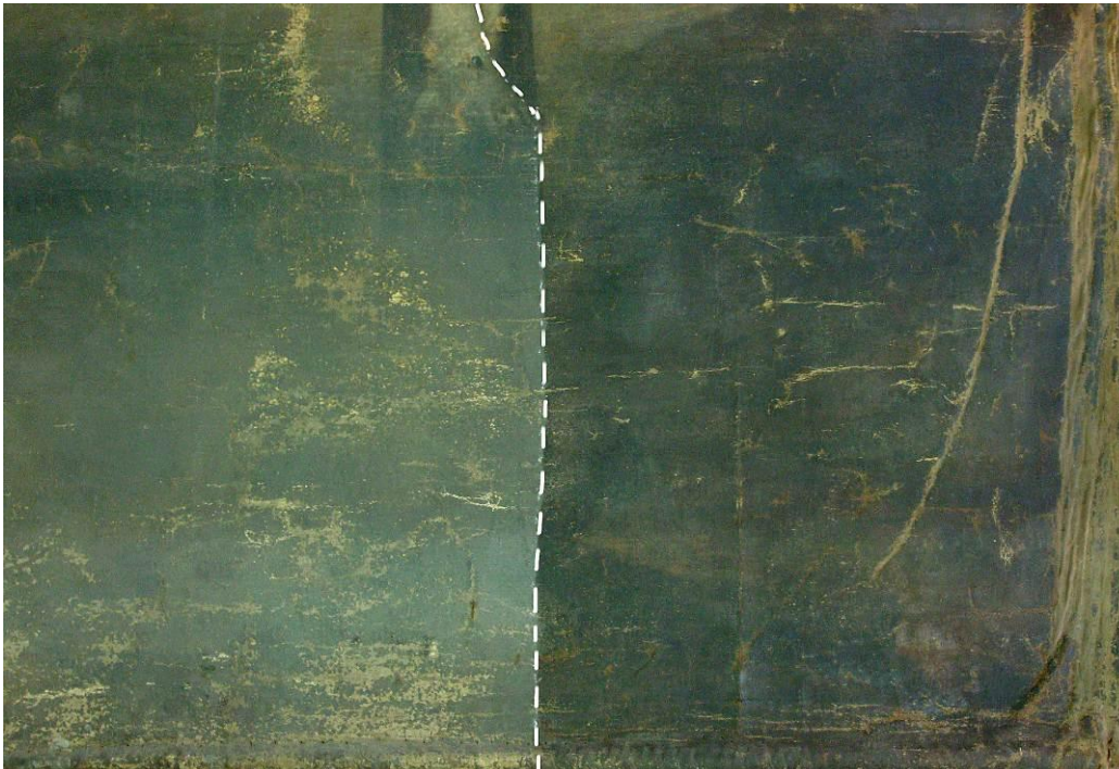
Figura 27: Pormenor da obra durante a limpeza química.
