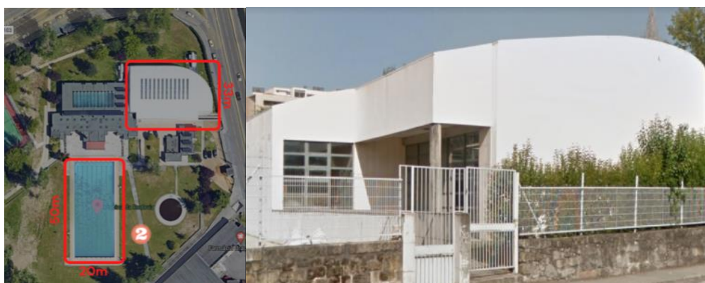
Fig.20 – Locais de intervenção artística na Piscina Municipal da Rodovia
