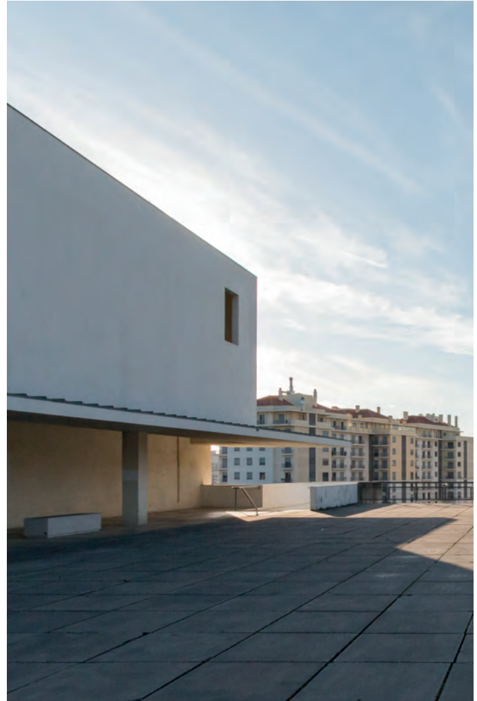
Convento de São Domingos, Lisboa Foto Hugo Casanova, 2018
