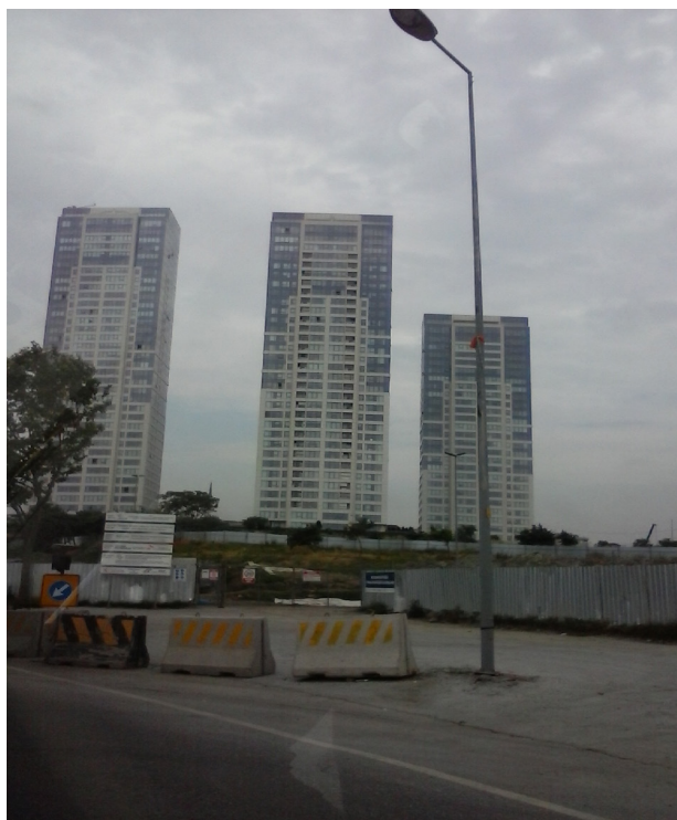
Figs. 115. Situação atual do empreendimento Onalti Dokuz (2015).
