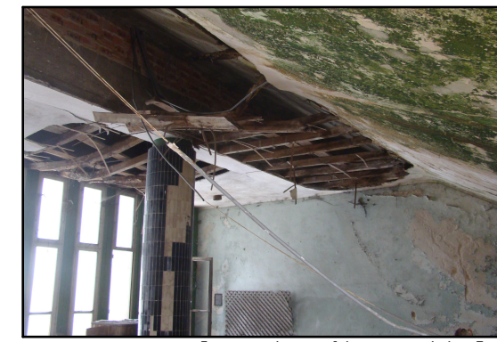
Estrutura do tecto falso na zona do bar Piso 1, Pedro Santos, 2016
