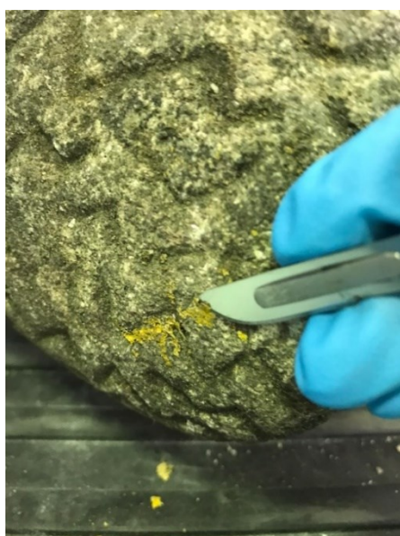
Figura 200 e Figura 201. Remoção de líquenes com recurso a um bisturi (©Carlota Carvalho)
