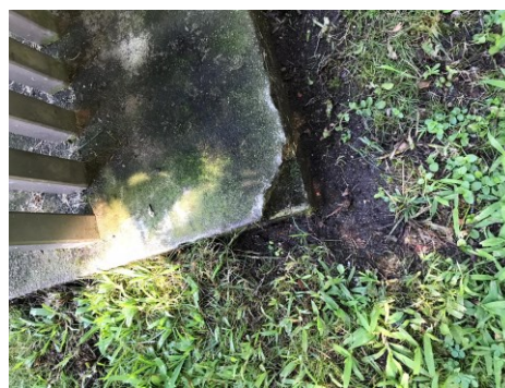
Figura 8 e Figura 9. Lacuna Volumétrica no Canto Esquerdo da Laje de Betão (©Carlota Carvalho)
