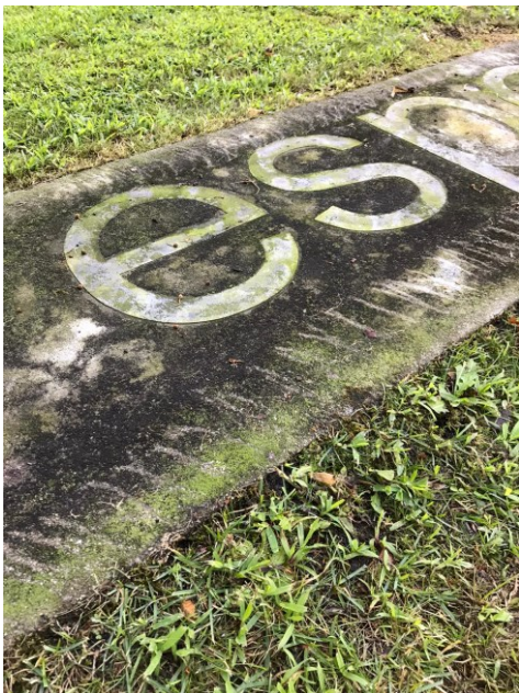
Figura 4 e Figura 5. Colonização Microbiológica da Base de Betão e Letras de Chumbo (©Carlota Carvalho)
