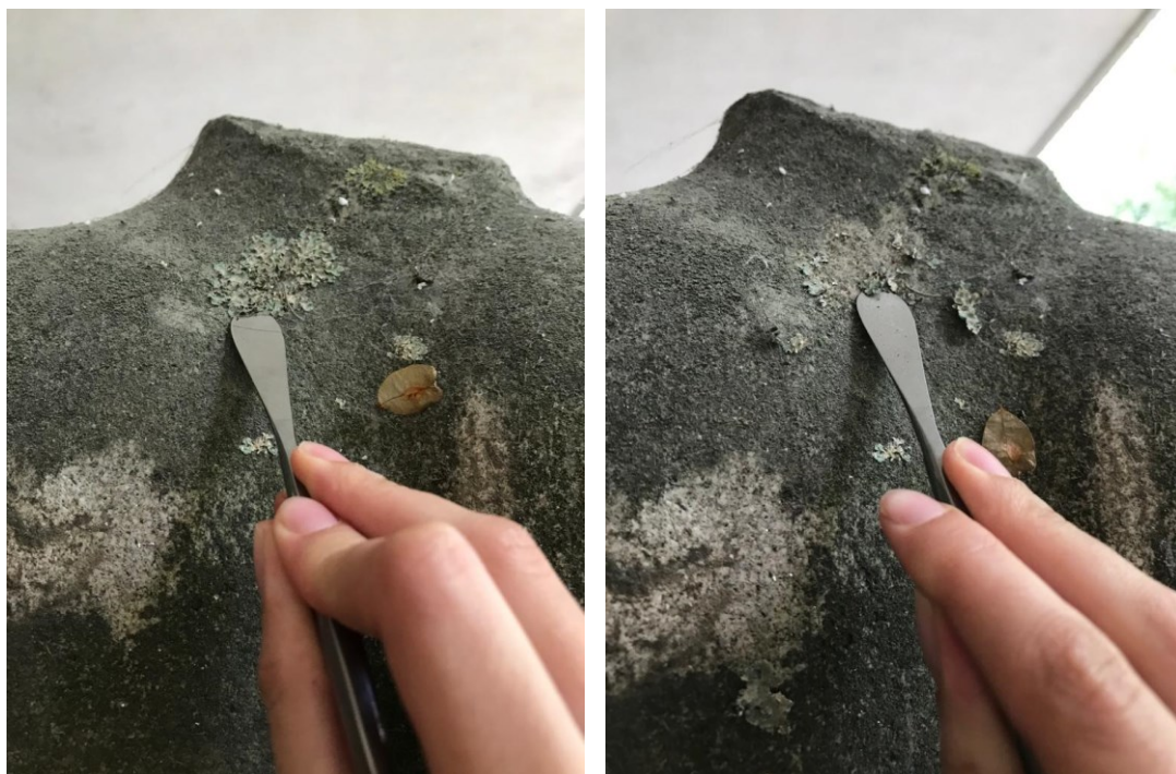
Figura 93 e Figura 94. Remoção mecânica de líquenes com espátula metálica semirrígida (©Carlota Carvalho)
