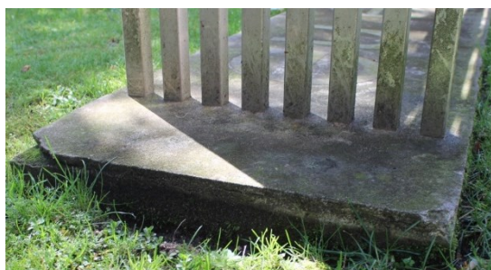
Figura 8 e Figura 9. Lacuna Volumétrica no Canto Esquerdo da Laje de Betão (©Carlota Carvalho)
