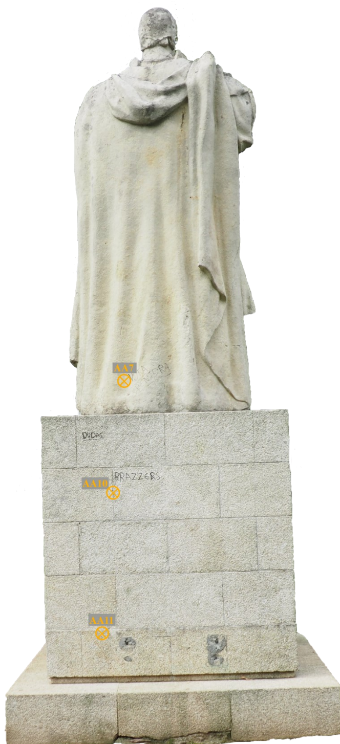
Figura 42. Plano das áreas de amostragem da vista do tardo para a metodologia de Karsten Pipes da escultura Afonso de Albuquerque (© Carlota Carvalho)
