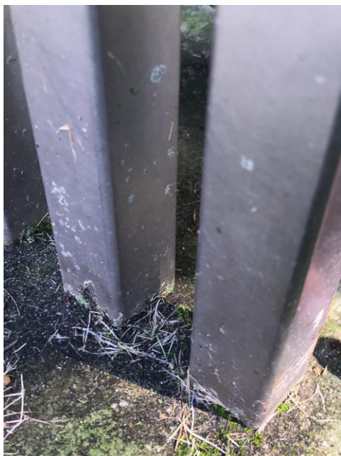
Figura 6 e Figura 7. Corrosão Pontual na Superfície Metálica (©Carlota Carvalho)
