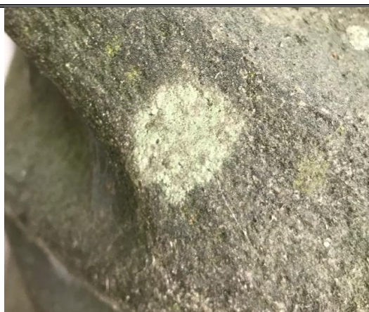
Figura 4. Pormenor de Biocolonização (Possível área onde se encontrava um líquene) (©Carlota Carvalho)
