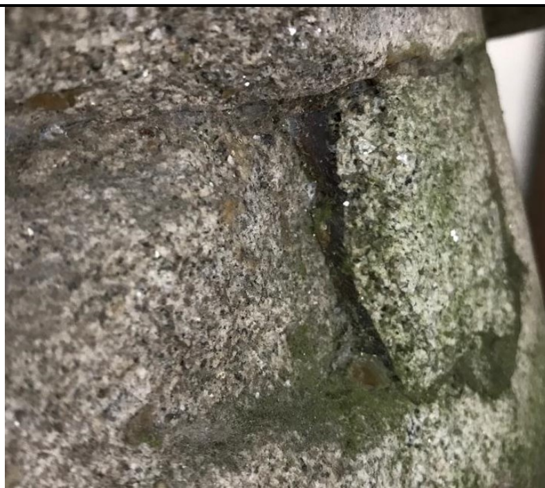
Figura 7. Pormenor de uma Intervenção Anterior (Colagem com Adesivo Desconhecido) (©Carlota Carvalho)
