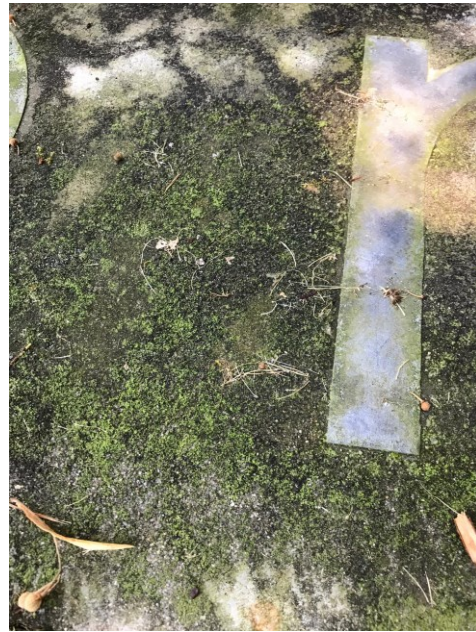
Figura 4 e Figura 5. Colonização Microbiológica da Base de Betão e Letras de Chumbo (©Carlota Carvalho)
