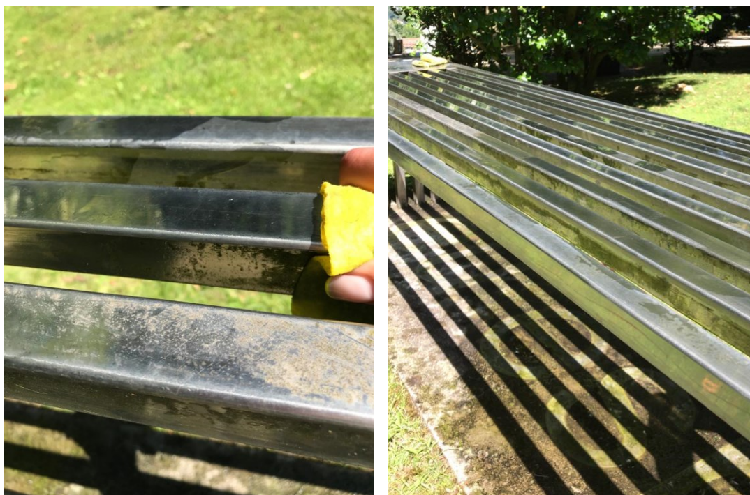
Figura 262- Figura 265. Limpeza superficial aquosa com água corrente e auxiliada por panos (©Carlota Carvalho)
