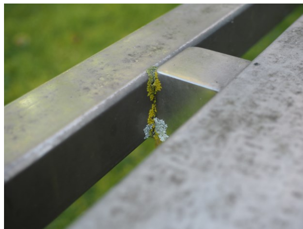
Figura 10. Fungo no Lado Direito do Assento (próximo da Gravura) (©Carlota Carvalho)
