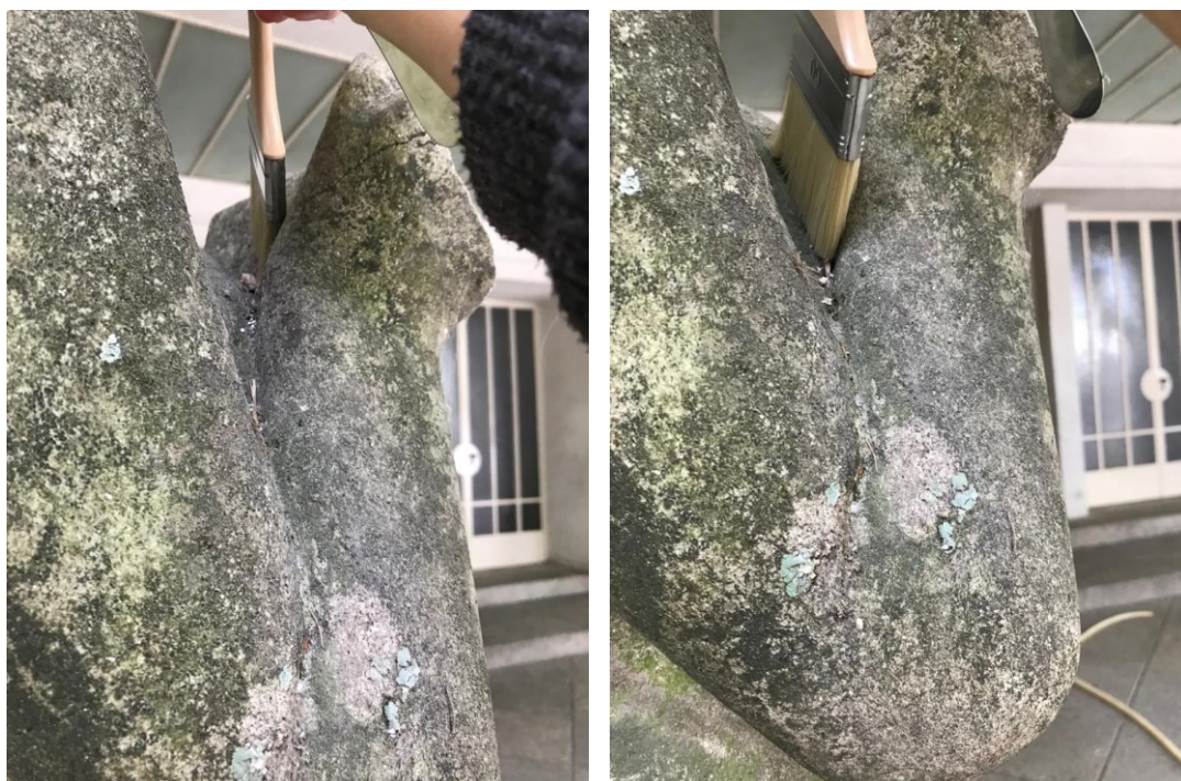
Figura 91 e Figura 92. Limpeza mecânica superficial com recurso a trincha de cerdas brandas (©Carlota Carvalho)
