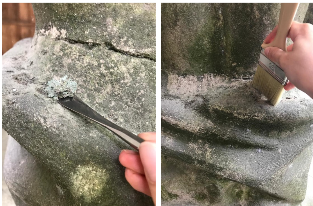
Figura 95 e Figura 96 Limpeza mecânica superficial (©Carlota Carvalho)
