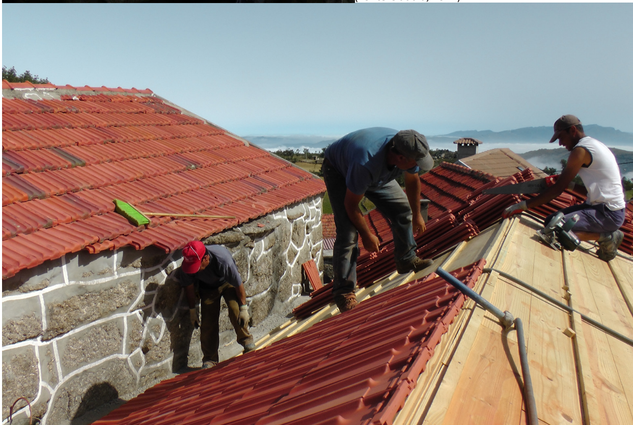
Figura 94 – Aplicação da telha (Fonte:Cláudia, 2014)
