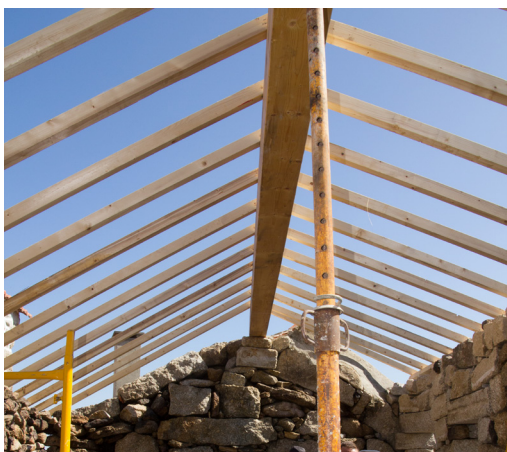
Figura 59 – Aplicação da viga principal (Fonte:Autor, 2014)
