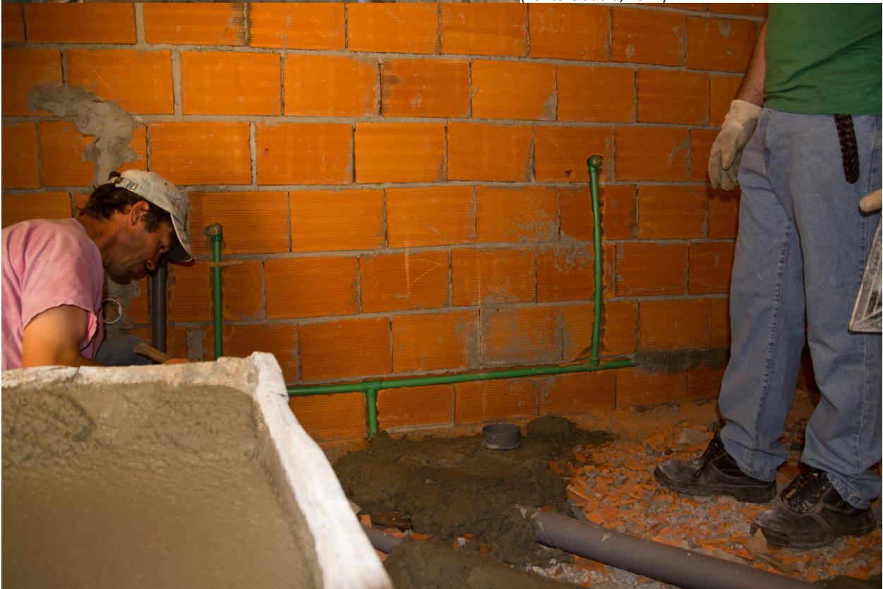
Figura 100 – Realização da canalização (Fonte:Cláudia, 2014)
