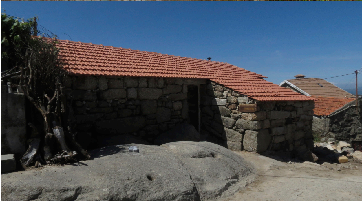
Figura 122 – Exterior do edifício (Fonte:Cláudia, 2014)
