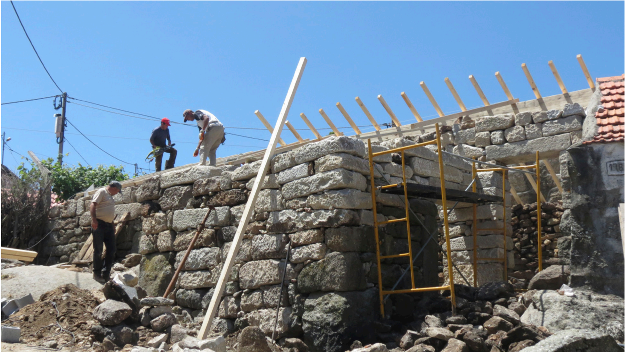
Figura 87 – Colocação dos barrotes na cobertura (Fonte:Cláudia, 2014)
