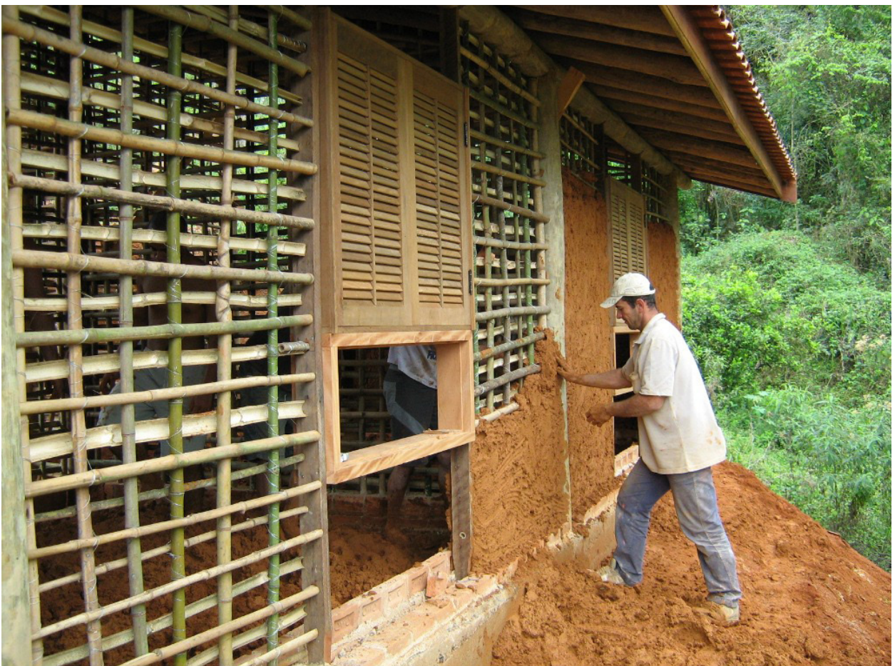
Figura 3 - Construção em Taipa de pau-a-pique (Fonte: http://www.coopertecti.com.br/desenvolvimento-sustentavel )
