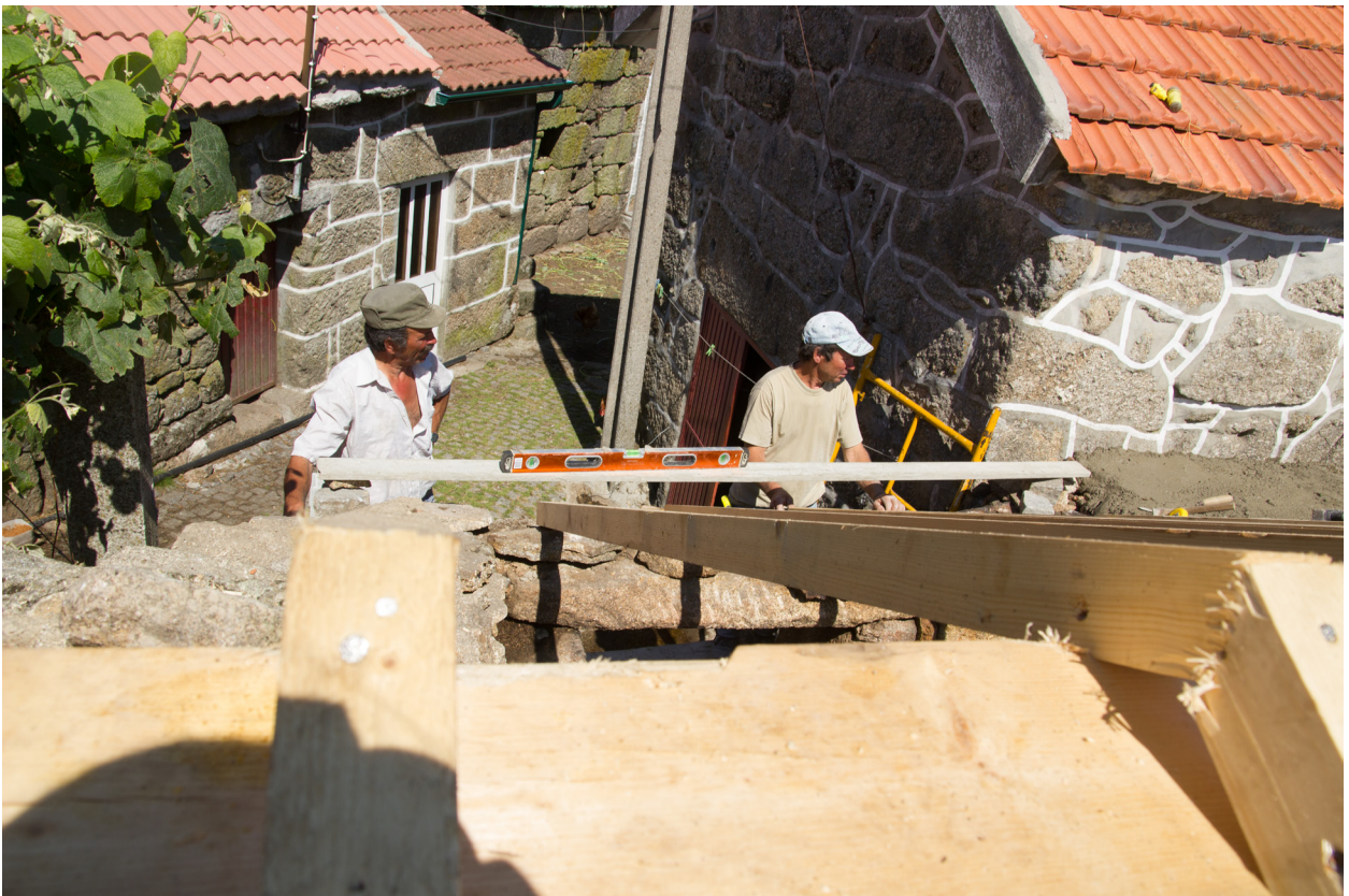
Figura 88 – Aplicação da calceira (Fonte:Cláudia, 2014)
