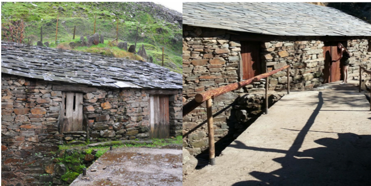
Figura 2 - Azenha antes e depois da intervenção (Fonte: Iniciativa Terra Amada)
