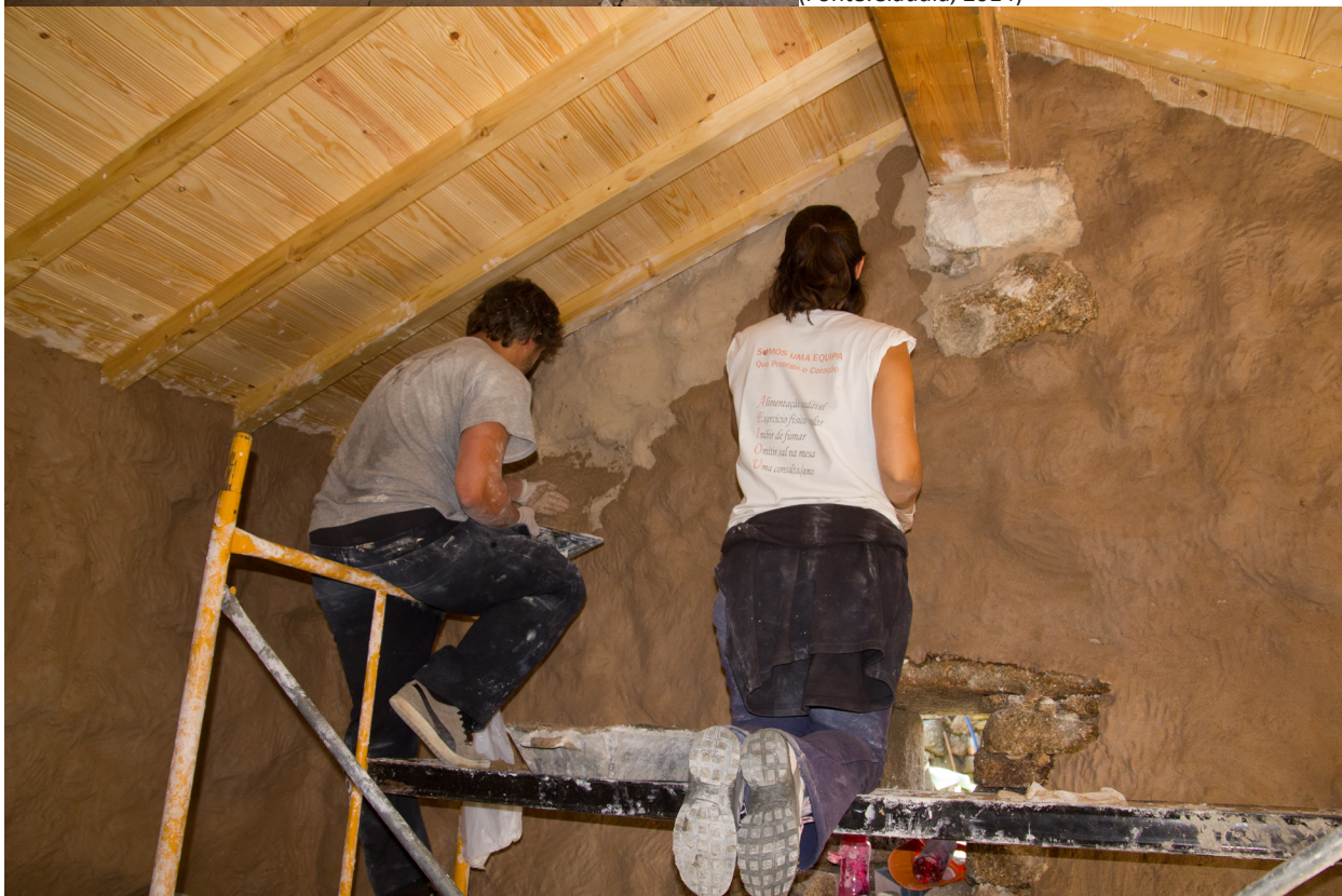
Figura 98 – Aplicação de argamassa na parede do quarto (Fonte:Cláudia, 2014)
