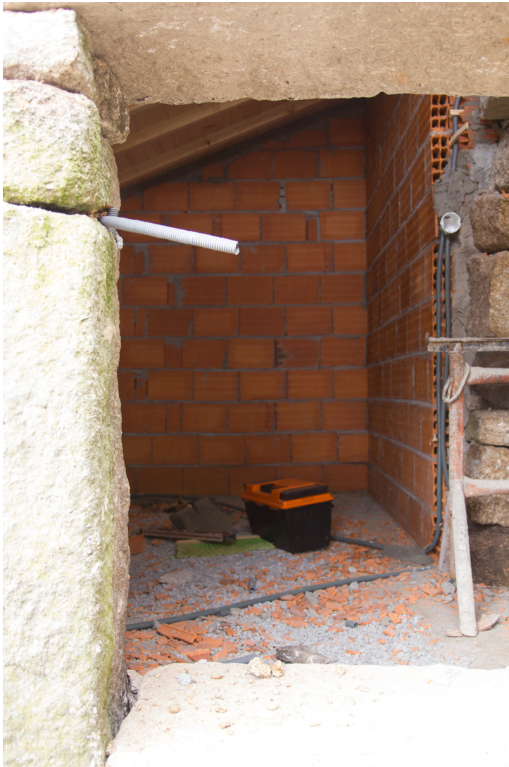
Figura 95 –Finalização da parede de tijolo do w.c. (Fonte:Cláudia, 2014)
