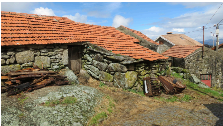
Figura 69 – Casa da Cristina (antes da intervenção) (Fonte:Autor, 2014)
