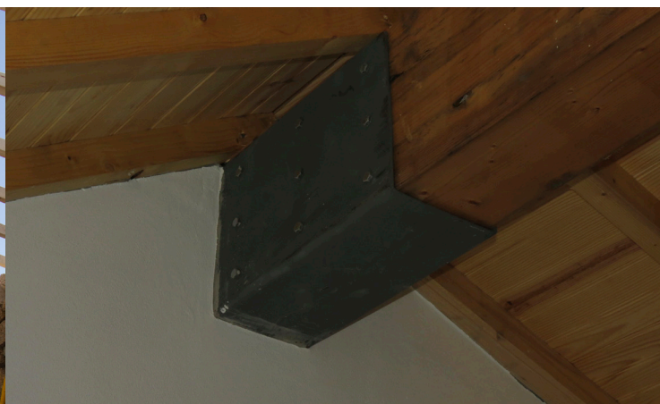
Figura 60 – União entre as duas vigas (Fonte:Autor, 2014)
