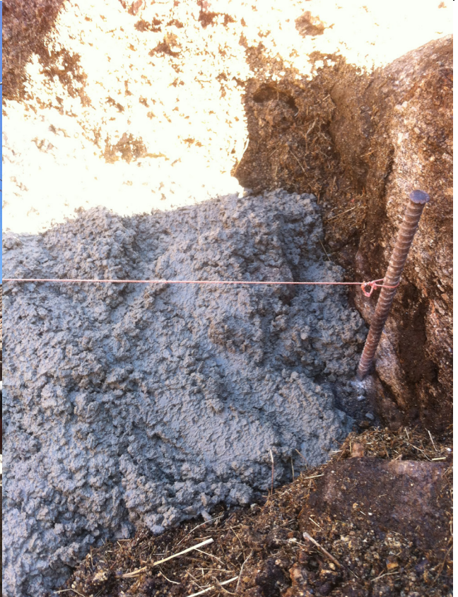
Figura 80 – Nivelamento do quarto (Fonte:Cláudia, 2014)
