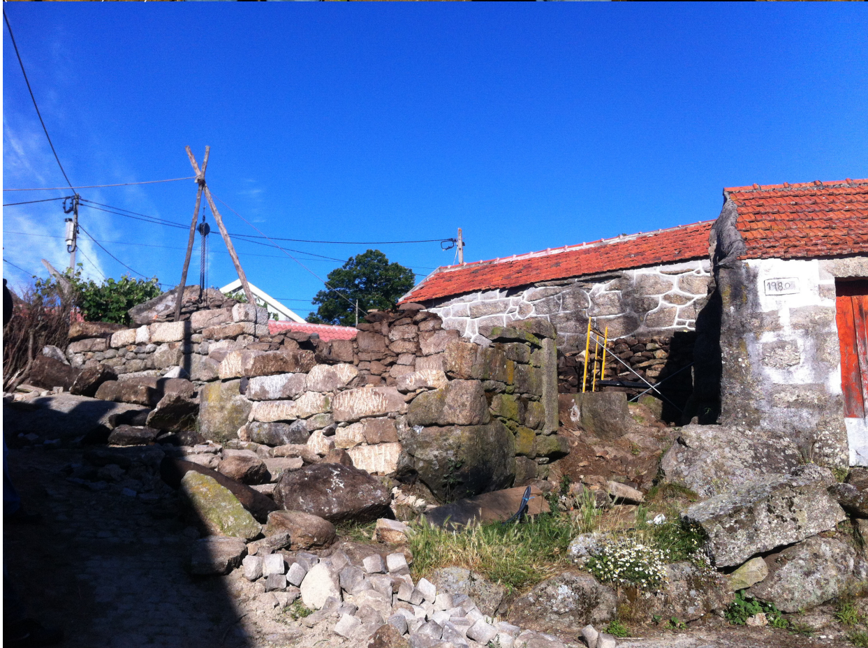
Figura 77 – Início da reconstrução das paredes exteriores (Fonte:Cláudia, 2014)
