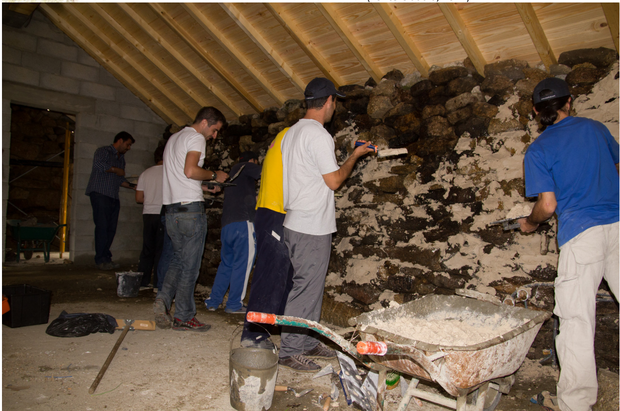
Figura 96 – Aplicação da argamassa (Fonte:Cláudia, 2014)
