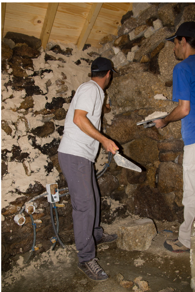
Figura 64 – Explicação da aplicação da argamassa pela DDLar-gamassa (Fonte:Autor, 2014)
