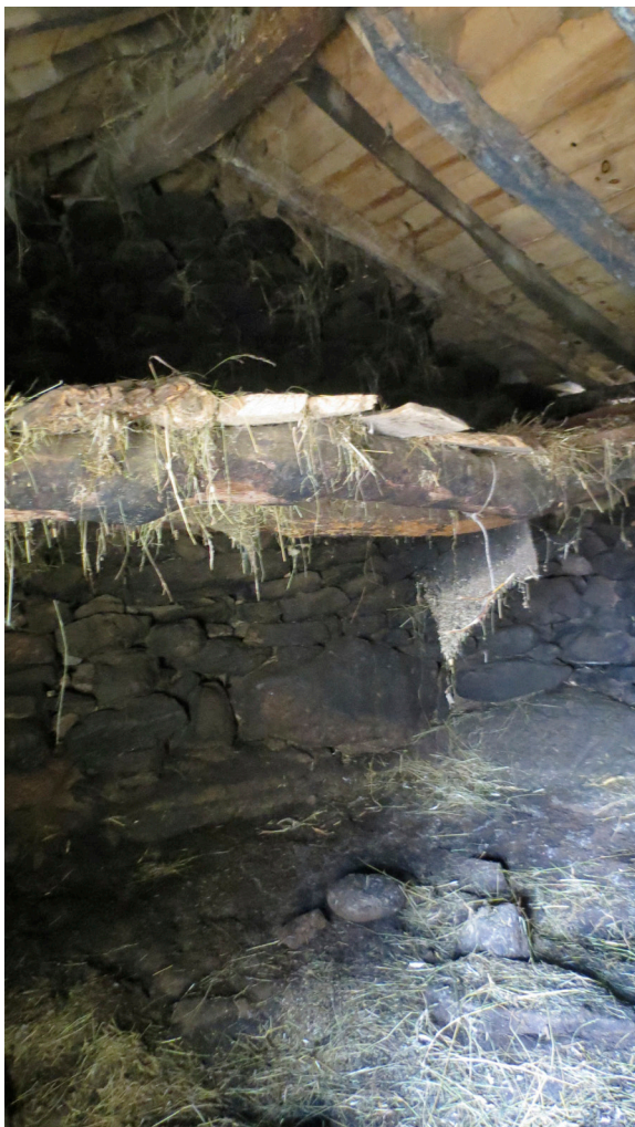
Figura 24 – Zona de Open-space, cozinha/sala estar – antes; (Fonte: Autor, 2014)
