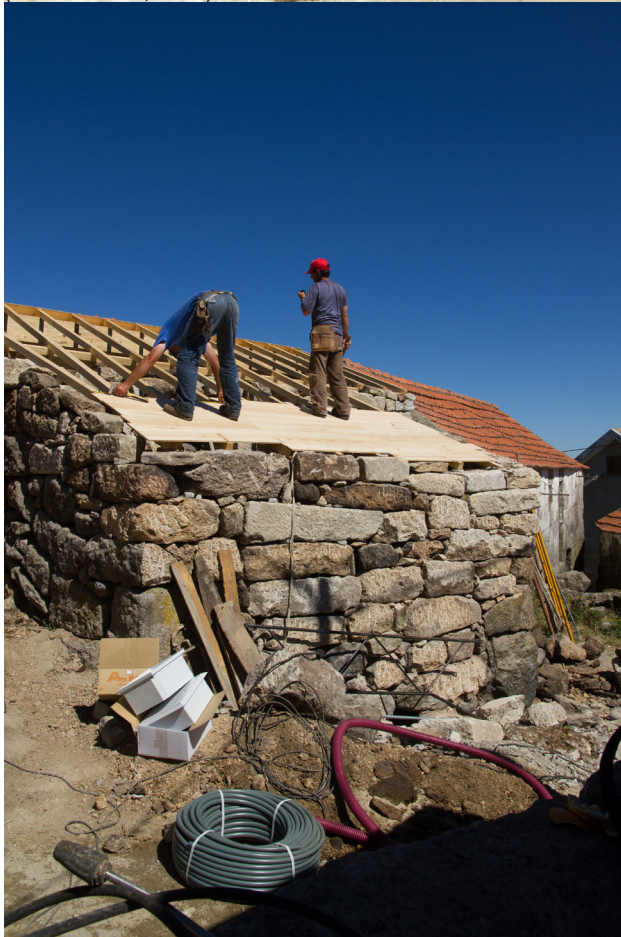
Figura 91 – Aplicação do forro (Fonte:Cláudia, 2014)
