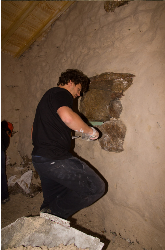
Figura 65 – Aplicação da argamassa (Fonte:Autor, 2014)
