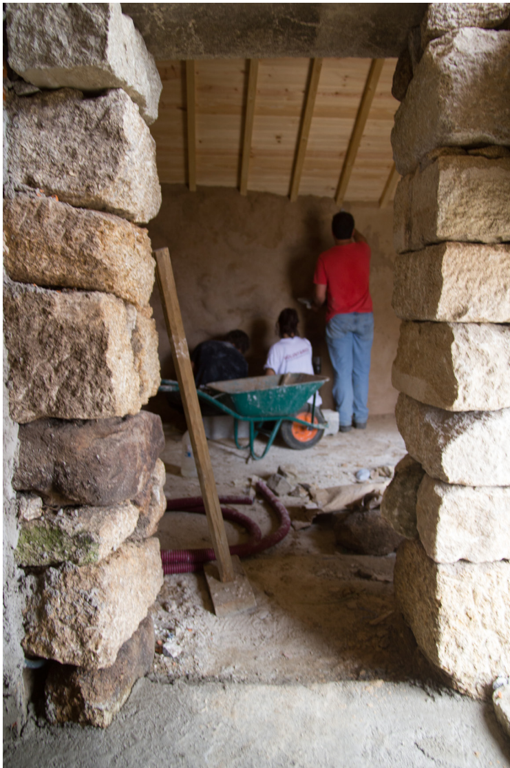
Figura 104 – Acabamento realização à argamassa (Fonte:Cláudia, 2014)
