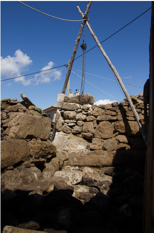
Figura 12 - “Garibaldi”, Utensílios para levantar pedras de maior dimensão em espaços reduzidos (Fonte: Cláudia, 2014)
