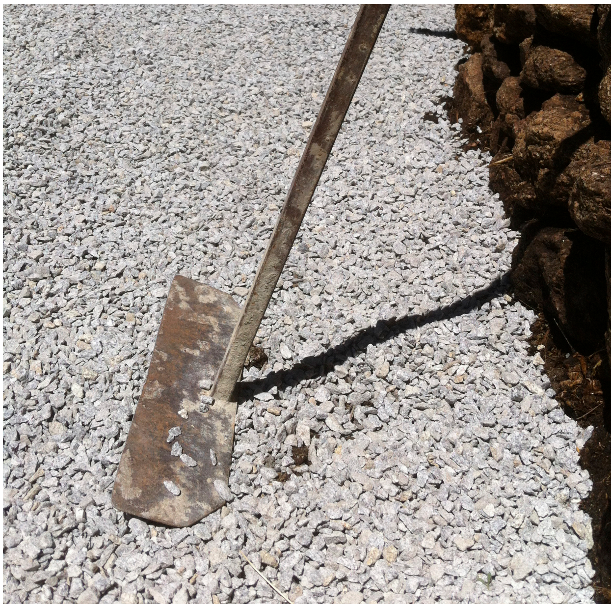
Figura 89 – Nivelamento do piso da casa de banho (Fonte:Cláudia, 2014)
