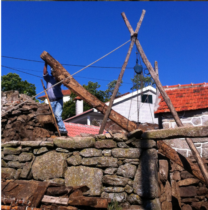
Figura 71 – Remoção da viga do edifício (Fonte:Autor, 2014)
