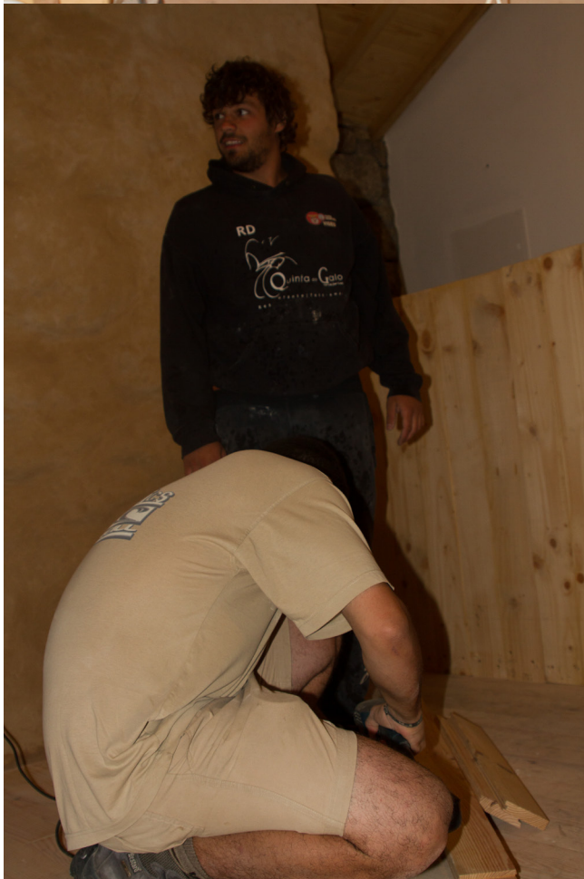
Figura 117 – Colocação da divisória entre espaços (Fonte:Cláudia, 2014)
