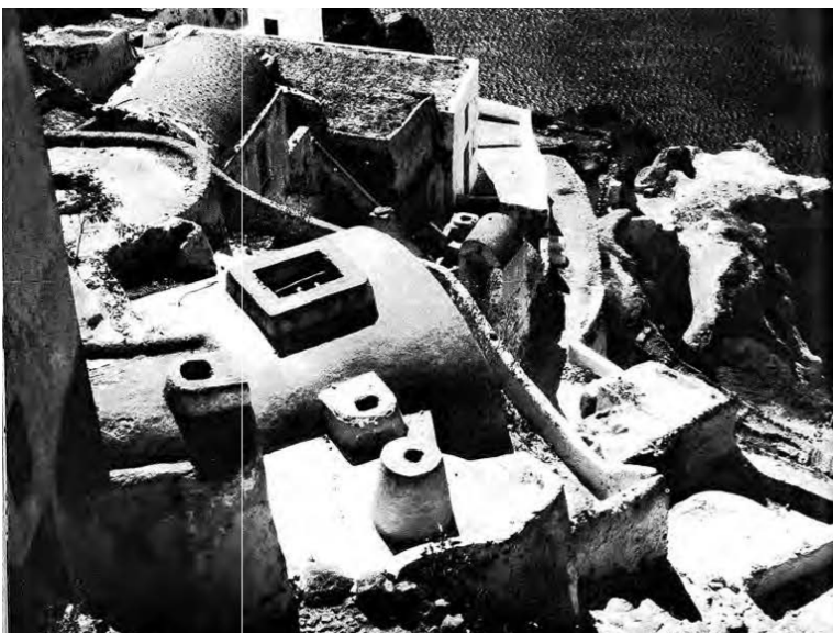
Figura 11 - Telhados com chaminés esculpidas, típicas da ilha do mar Egeu (Fonte: Rudofsky 1972)
