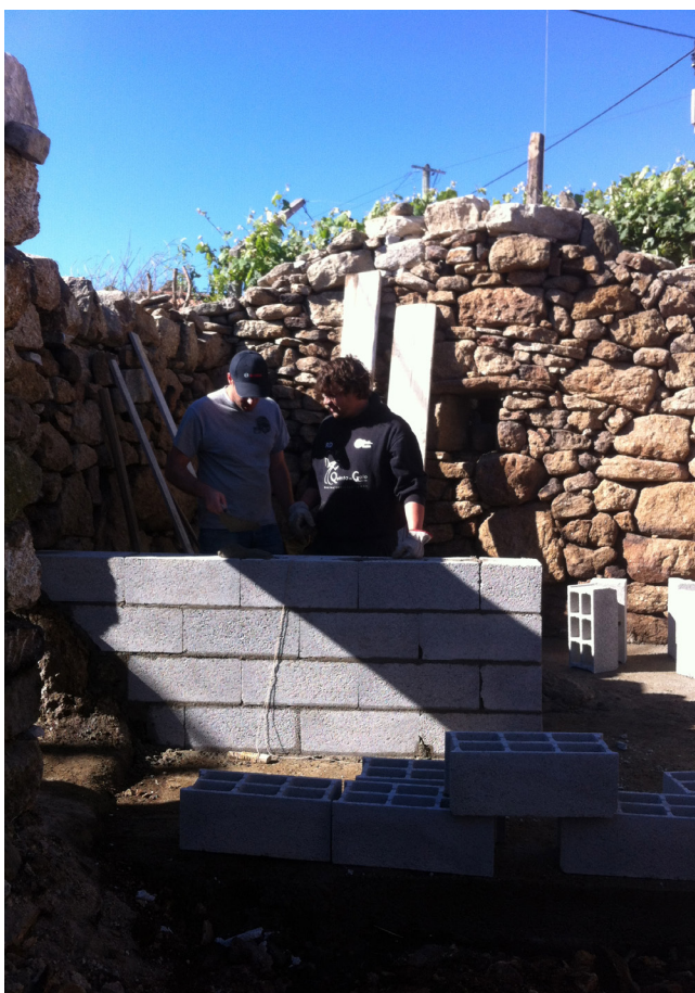
Figura 81 – Início da construção da parede divória do quarto (Fonte:Cláudia, 2014)
