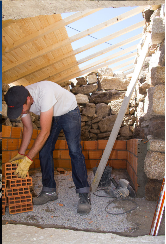
Figura 92 – Construção da parede da casa de banho (Fonte:Cláudia, 2014)
