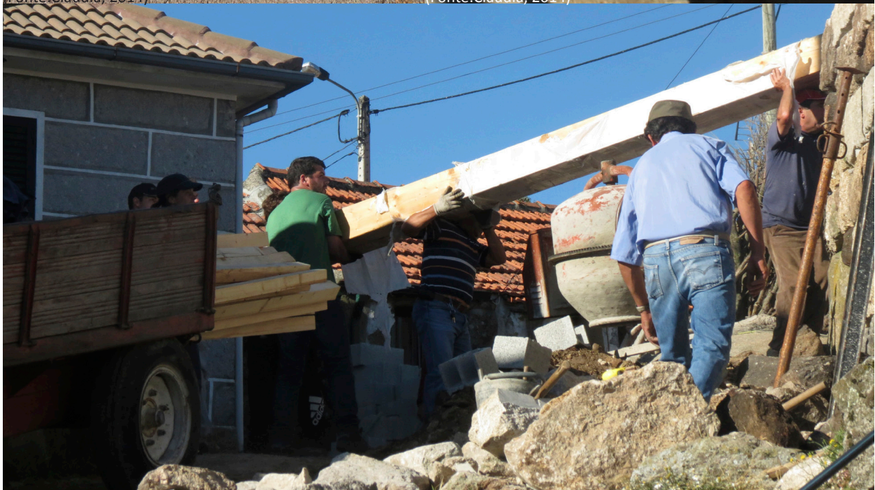
Figura 85 – Colocação da viga principal no edifício (Fonte:Cláudia, 2014)
