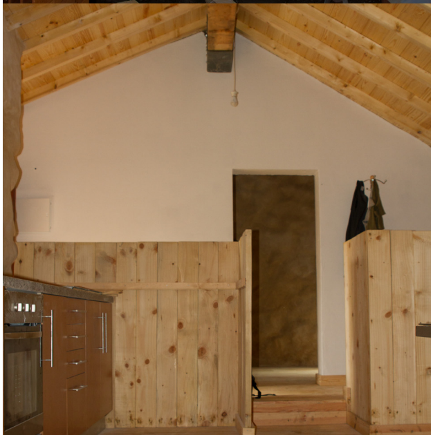
Figura 62 – Parede divisória do quarto antes e do hall pintada (Fonte:Autor, 2014)
