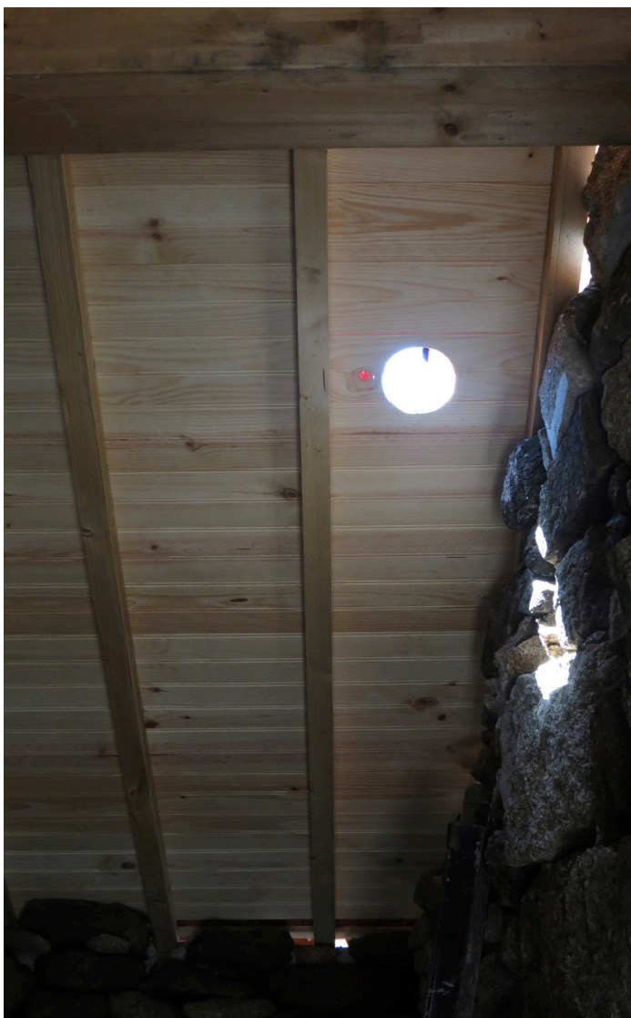
Figura 93 – Abertura da futura chaminé (Fonte:Cláudia, 2014)
