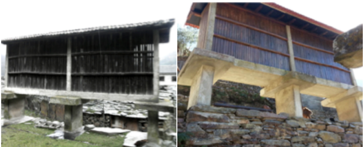
Figura 7 - Espigueiro antes e depois (Fonte: Iniciativa Terra Amada)
