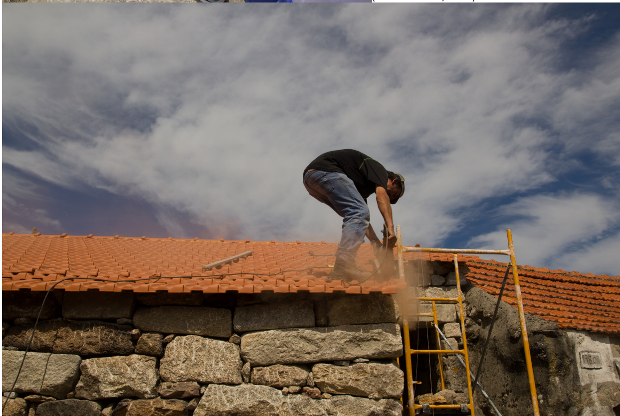
Figura 115 – Remate da telha (Fonte:Cláudia, 2014)
