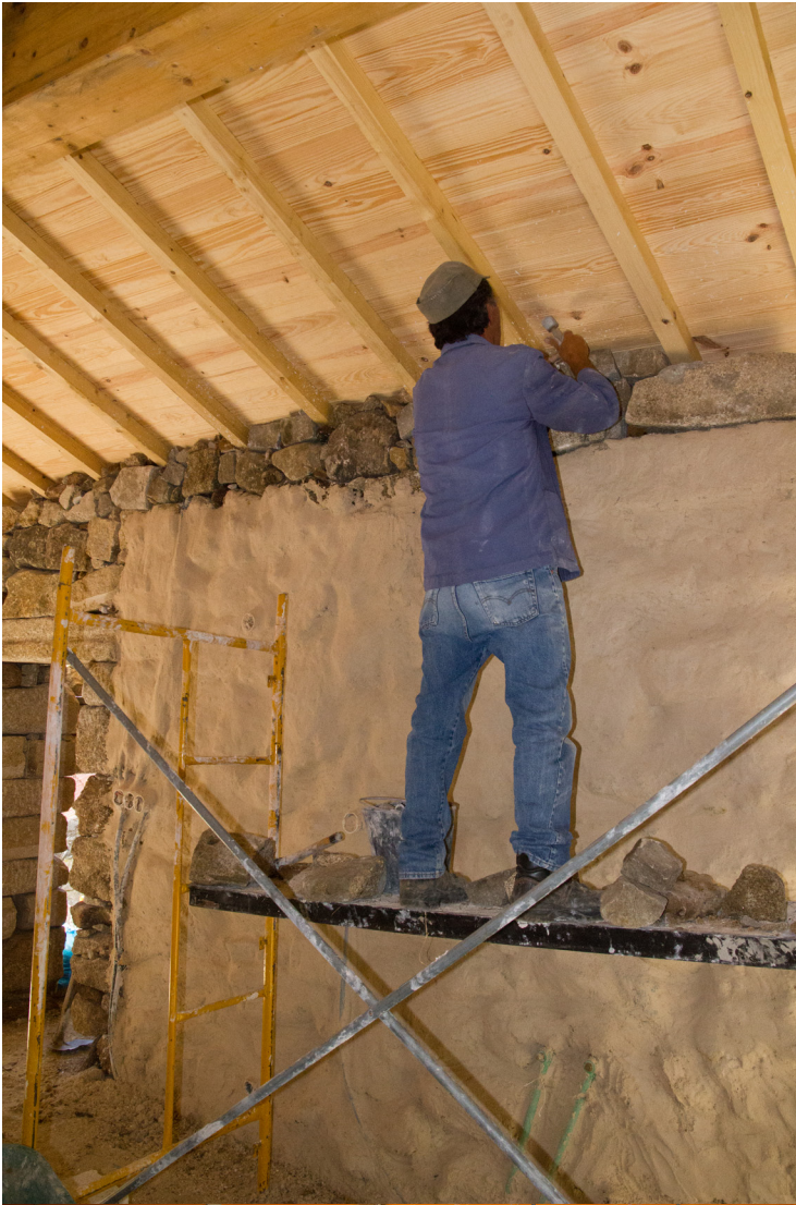
Figura 99 – Remate da parede divisória entre a cozinha e a sala (Fonte:Cláudia, 2014)
