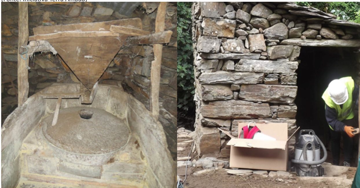
Figura 3 - Moinho antes e depois da intervenção (Fonte: Iniciativa Terra Amada)
