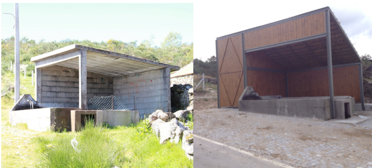
Figura 4 - Tanque da aldeia antes e depois (Fonte: Esquerda - Iniciativa Terra Amada, Direita - Autor,2014)
