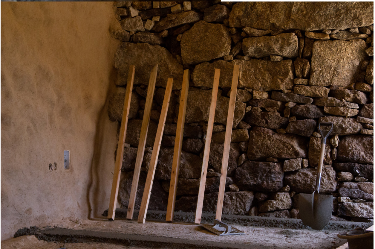
Figura 113 – Barrotes para a futura aplicação do soalho (Fonte:Cláudia, 2014)
