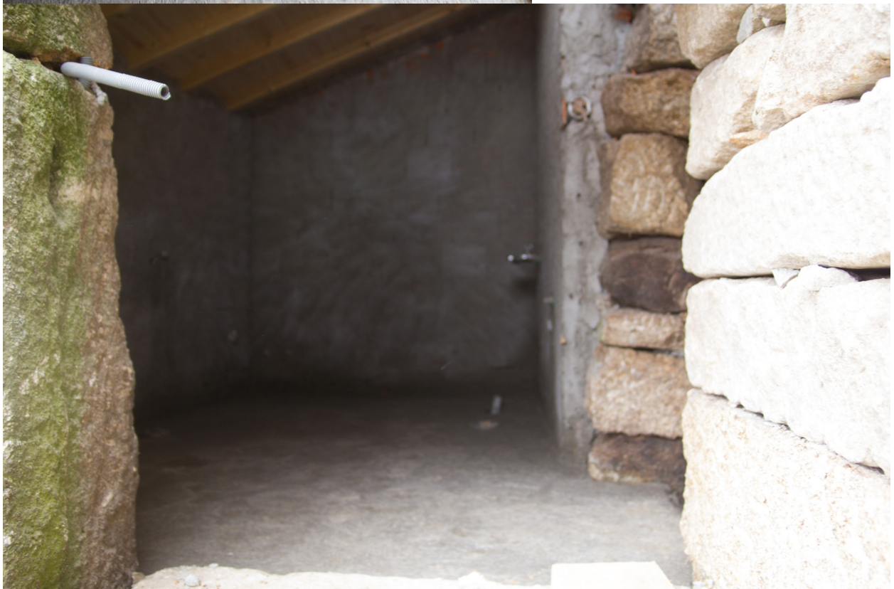
Figura 105 – regularização do pavimento da casa de banho (Fonte:Cláudia, 2014)
