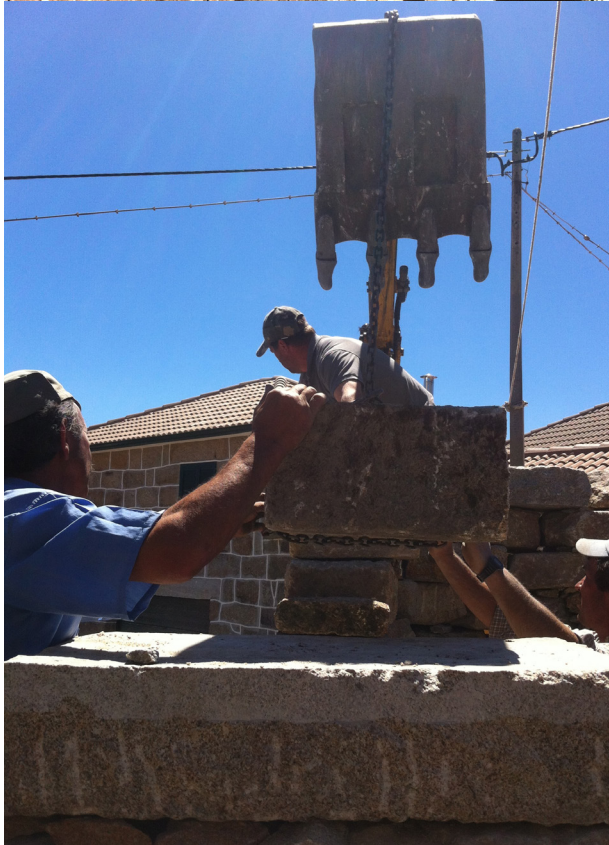
Figura 79 – Colocação da padieira do vão do w.c. (Fonte:Cláudia, 2014)
