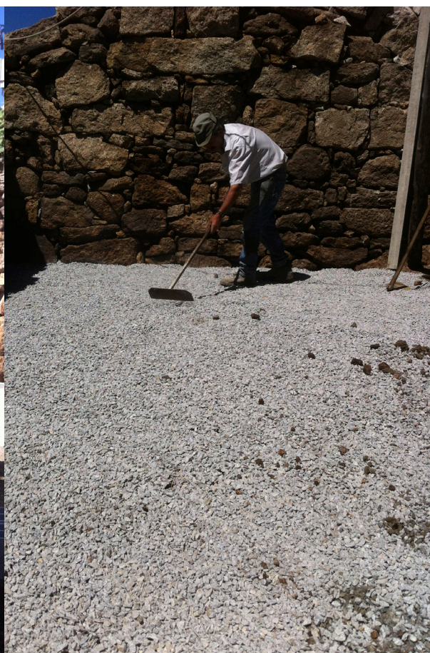
Figura 82 – Início do nivelamento do resto da habitação (Fonte:Cláudia, 2014)
