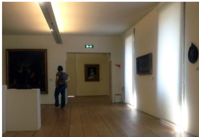
Figura 28 – Plano de sala de exposição onde se nota o excesso de penetração de radiação ultravioleta por deficiente dimensionamento das telas protectoras dos vãos das janelas.
