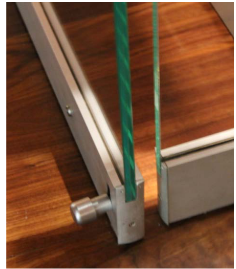
Figura 23 - Pormenor da falta de estanquidade das vitrinas onde se exibem as peças de ourivesaria na vertical.
