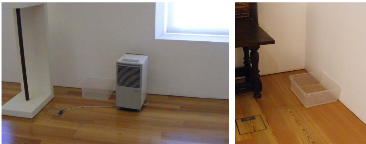
Figuras 14 e 15 – Colocação de recipiente de água para correcção de valores de HR no espaço expositivo (Verão de 2013).
