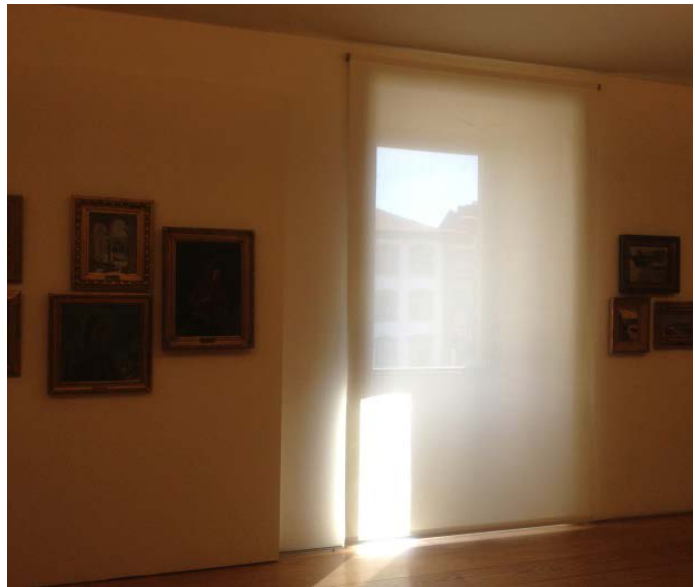
Figura 30 - Exemplo do deficiente isolamento proporcionado pelo material usado na tela de protecção dos vãos da janela.
