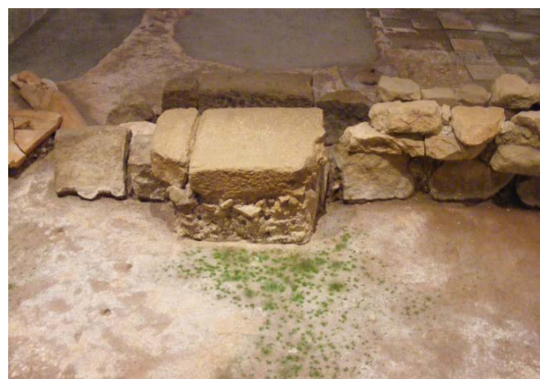
Figura 6 – Pormenor do pavimento do mosaico romano musealizado com colonização biológica (Verão de 2013).
