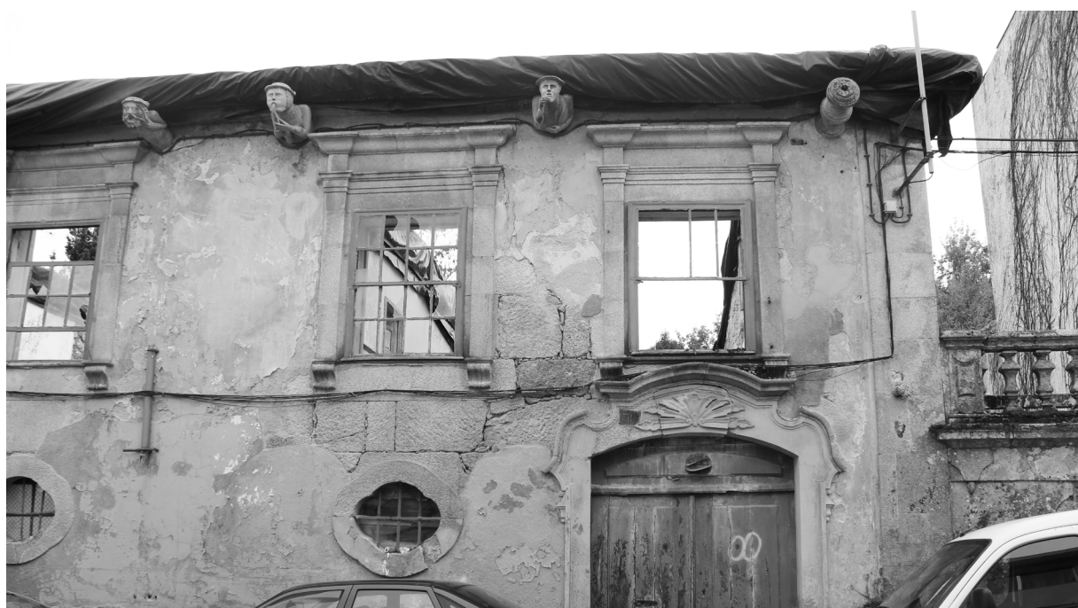
FIGURA 22 Fachada da Casa Fonte: autora
