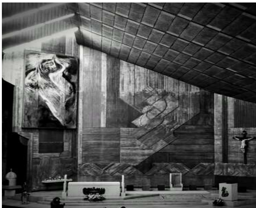
Figura 53 – Aproximação da textura cinza do betão descofrado, a forma original. Fonte 355
