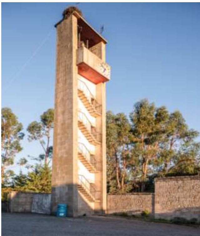
Fig. 25 - A separação da torre sineira através do muro contíguo a ligar à igreja. Fotografia de João Lopes Cardoso
