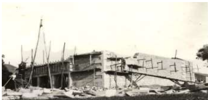
Fig. 16 - Momentos de construção. Fonte: Repositório da Câmara de Penamacor 110
