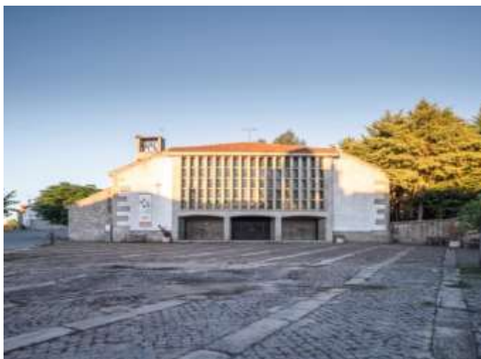
Fig. 6 - A fachada poente. A implantação orográfica exterior da arquitetura da moderna igreja de Águas.
