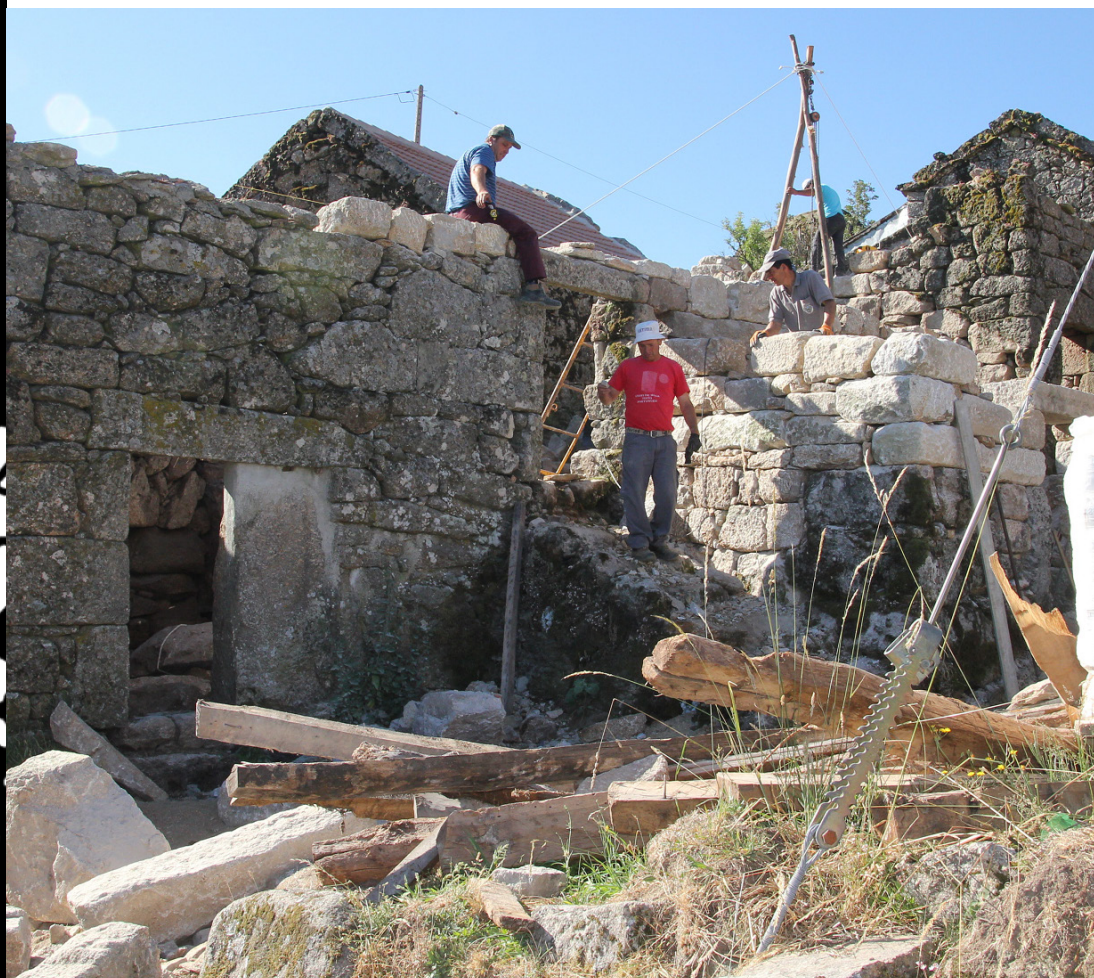
Fig.56 Construção das paredes de pedra (Fonte: Cláudia Rodrigues)
