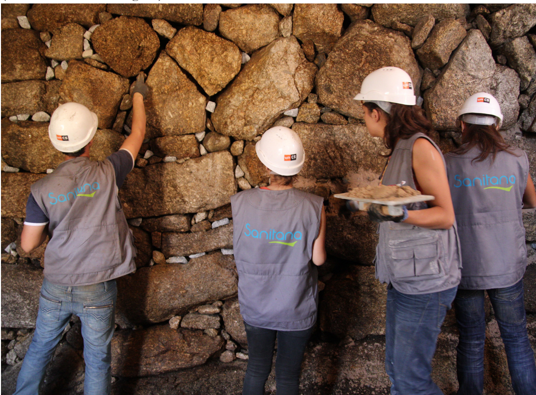
Fig.61 Colmatar as juntas (Fonte: Cláudia Rodrigues)
