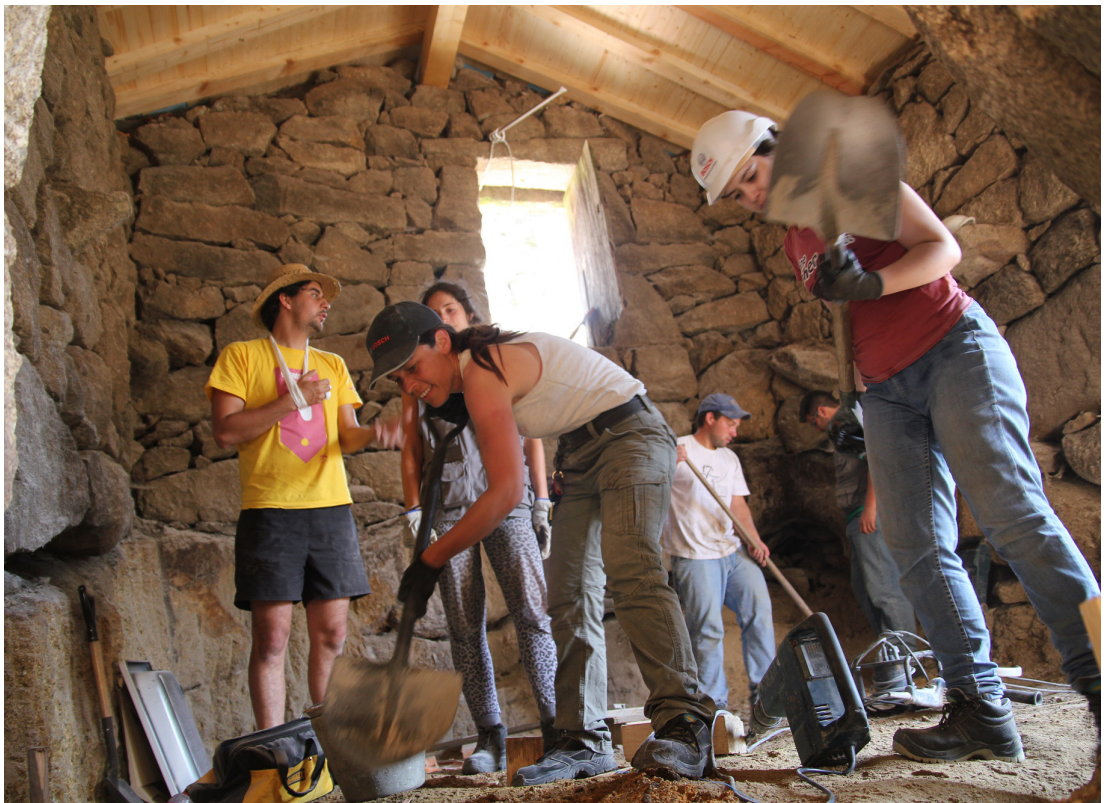
Fig.63 Escavação para colocação da drenagem (Fonte: Cláudia Rodrigues)
