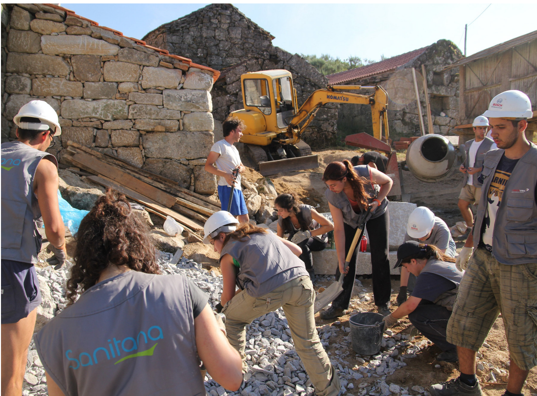
Fig. 65 Rachão e gravilha para a construção do pavimento (Fonte: Cláudia Rodrigues)
