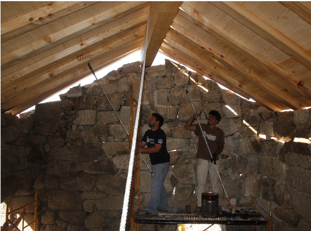
Fig. 64 Aplicação de Xilofene no forro (Fonte: Cláudia Rodrigues)
