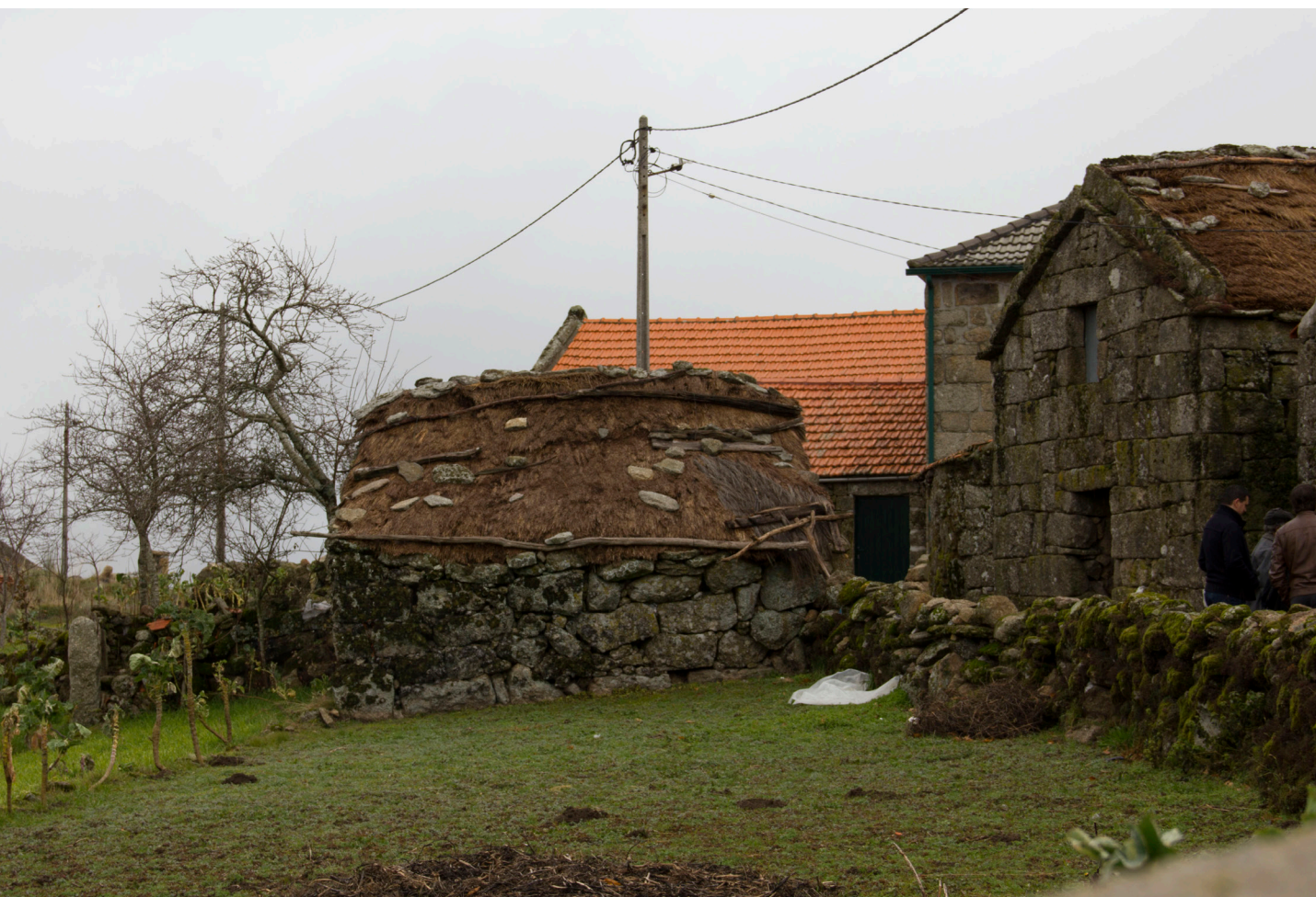
Fig. 23 Coberturas de colmo únicas Vale de Papas (Fonte:David Costa)
