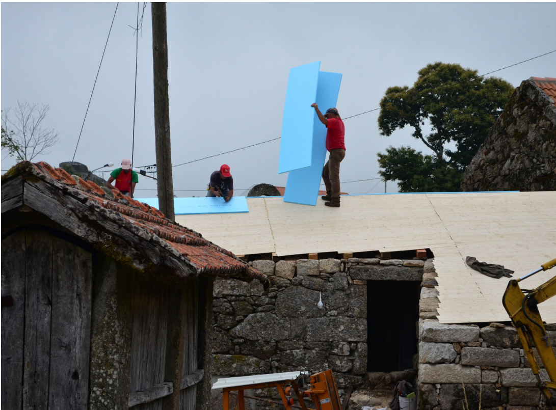
Fig.60 Colocação isolamento na cobertura (Fonte: Pedro Costa)
