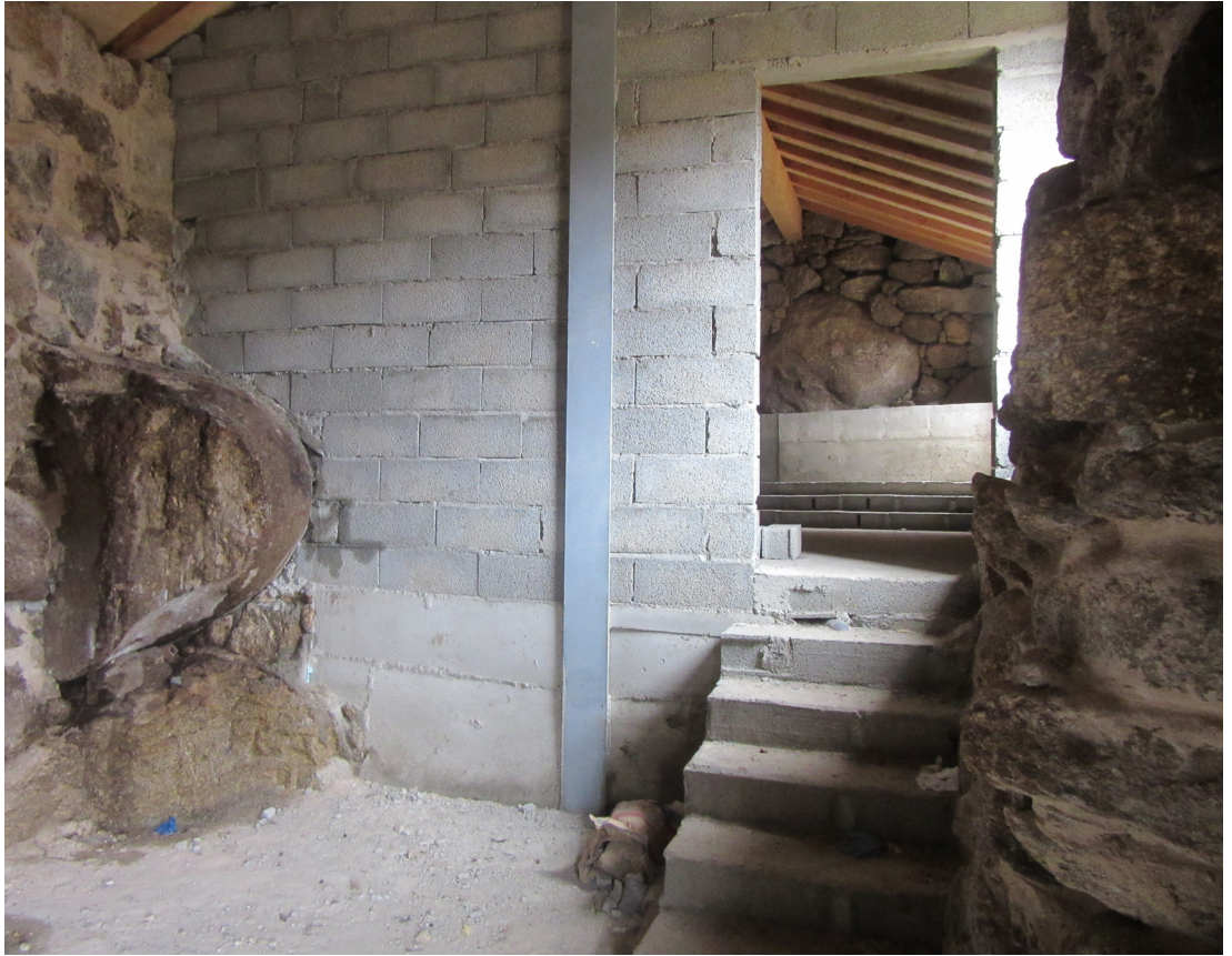
Fig. 74 / 75 Sala de Cura (Fonte: Autor)
