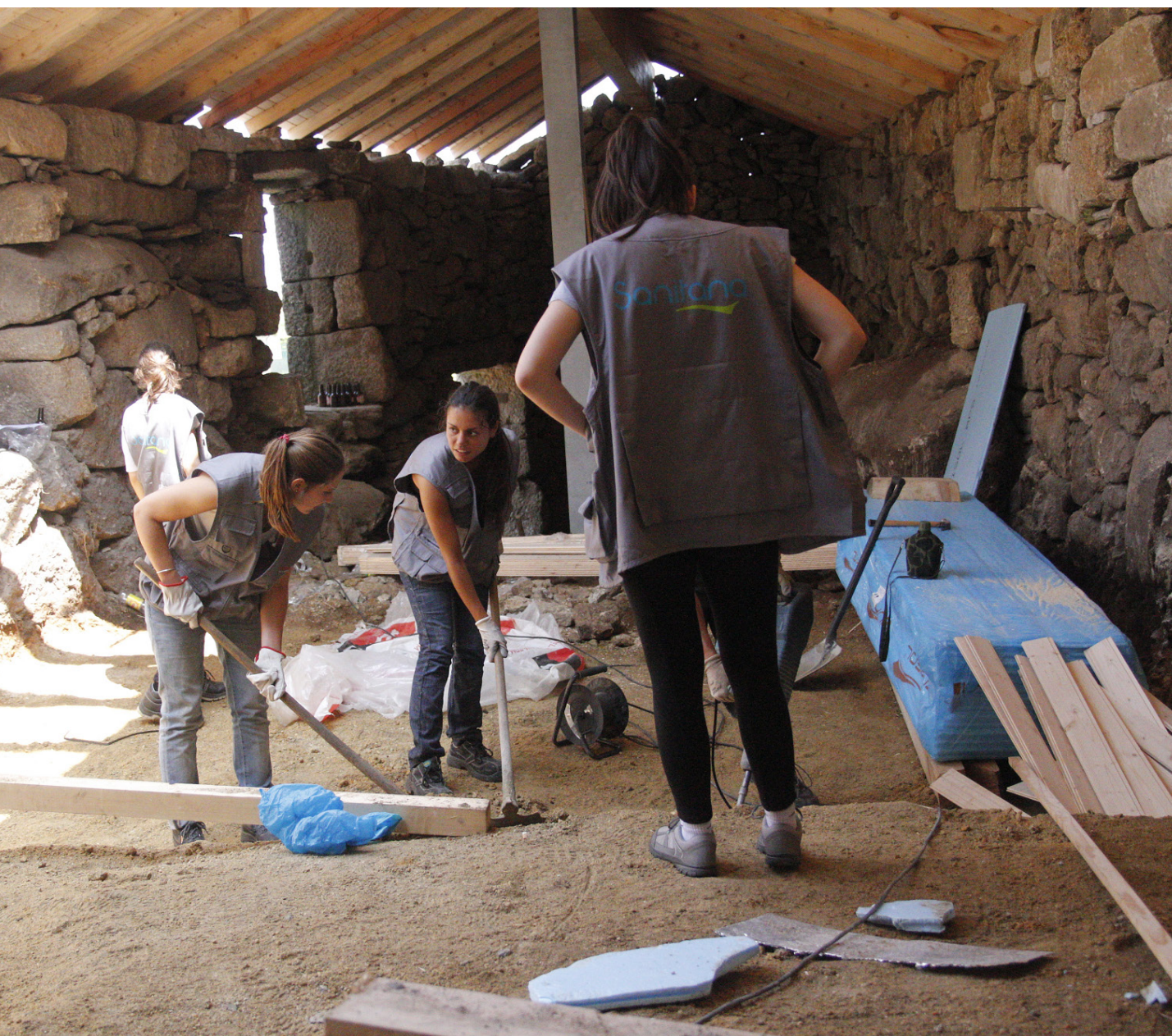
Fig. 67 / 68 Colocação da drenagem (Fonte: Cláudia Rodrigues)
