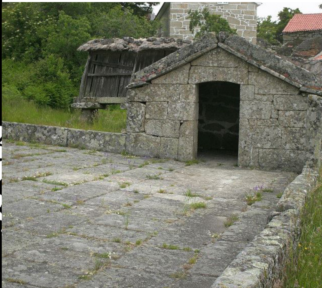
Fig. 77 Espigueiro antes de cair 2012 (Fonte: Crestina)
