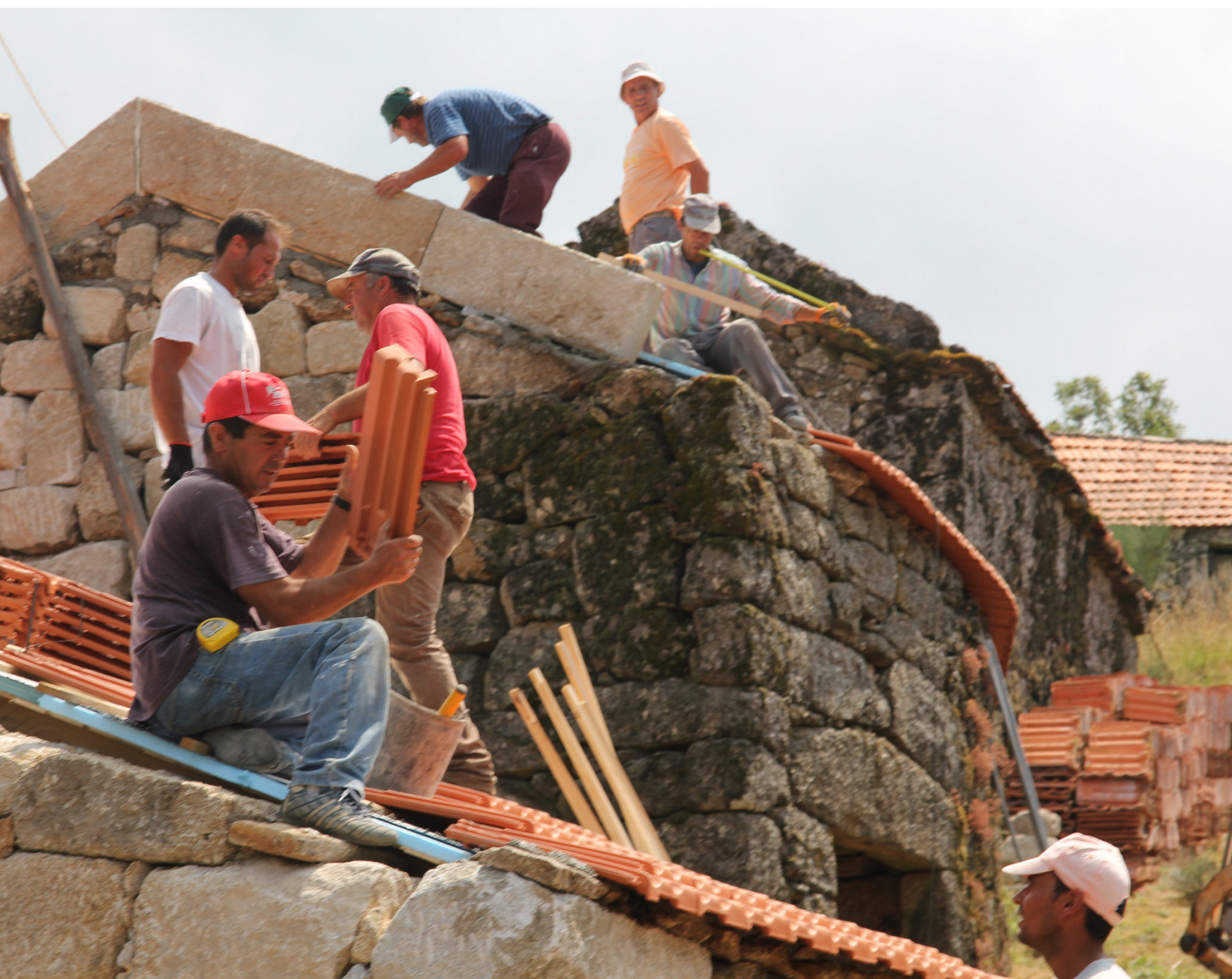
Fig.59 Construção da cobertura (Fonte: Cláudia Rodrigues)
