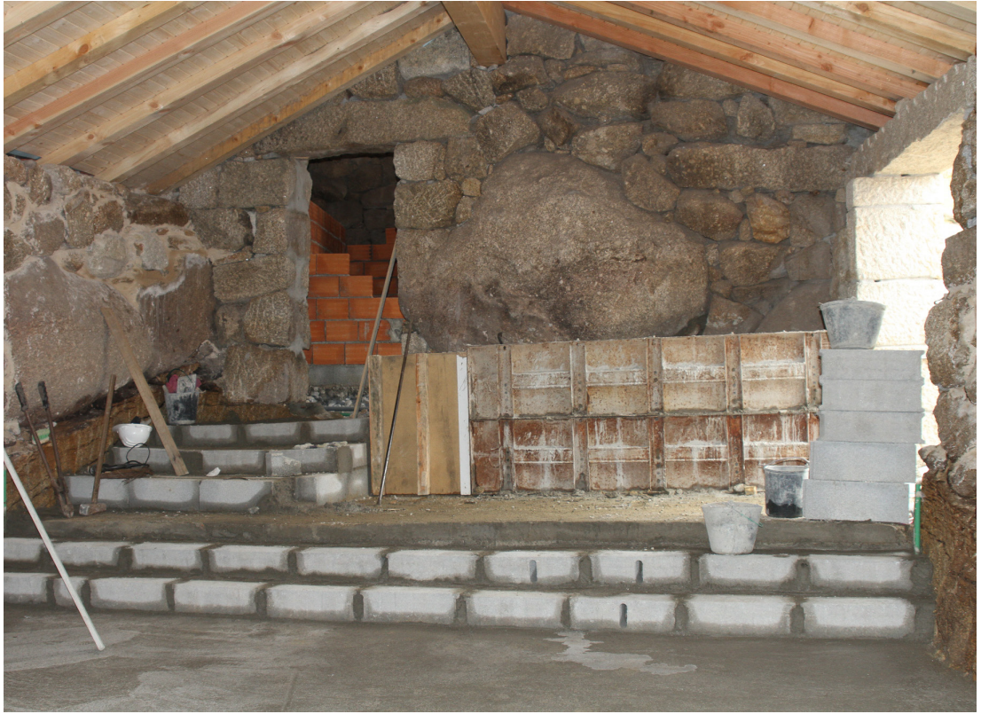
Fig.62 Construção das escadas e lintel (Fonte: Cláudia Rodrigues)
