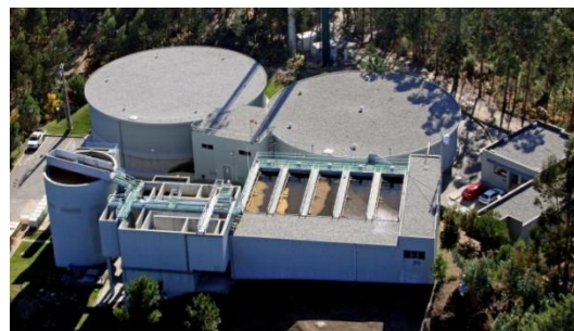
Figura 2.6 – ETA de Castelo de Paiva
