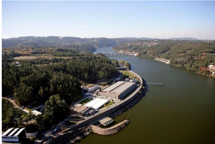
Figura 2.4 – Complexo da ETA de Lever
