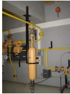
Figura 2.52 – Vaso de expansão e pressostato
