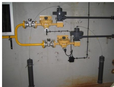
Figura 2.54 – Válvulas redutoras de vácuo
