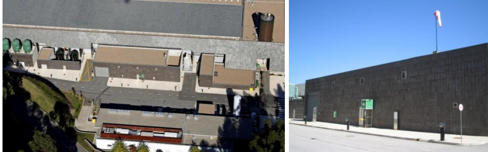
Figura 2.49 – Cloragem da ETA de Lever
