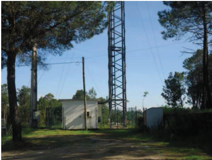
Fotografia 17 - Antena - Junto à zona de construção
