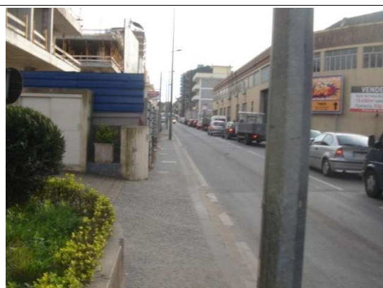
A inclinação deste passeio foi pensada para a entrada e saída de viaturas, dificultando a passagem de peões, principalmente dos peões com mobilidade reduzida.
