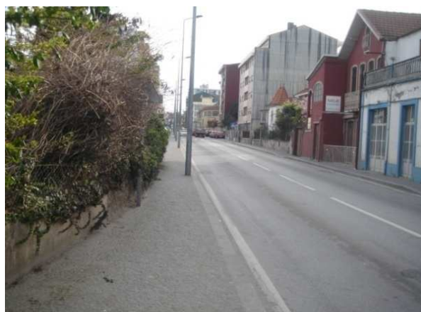
Espaços verdes sem manutenção adequada podem dificultar a passagem dos peões.
