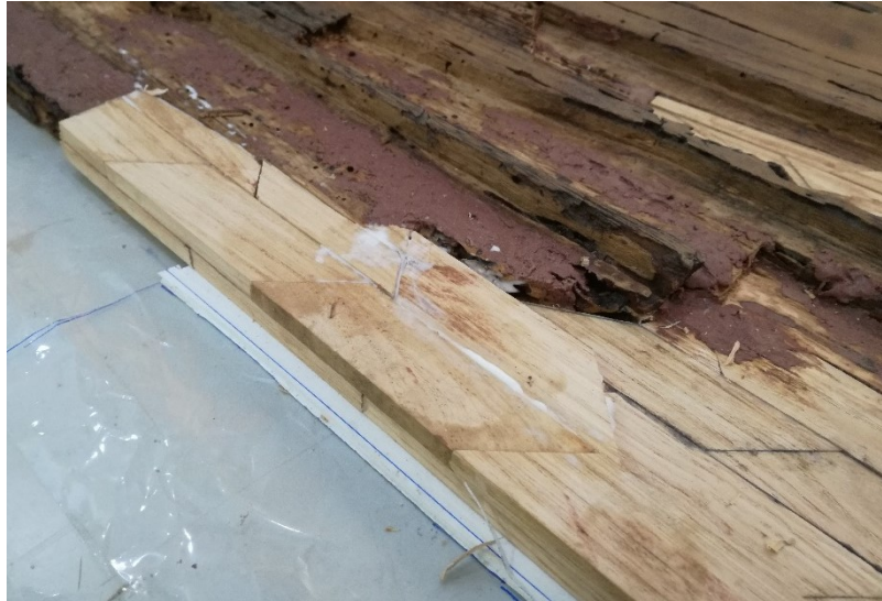
Figura 32 - Aplicação da segunda camada de blocos de madeira
