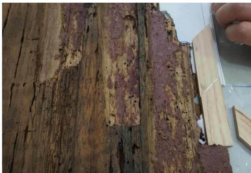
Figura 31 – Aplicação da primeira camada de blocos de madeira
