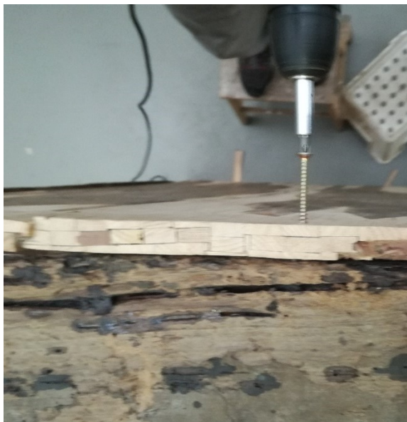
Figura 45 – União dos painéis à restante estrutura através de parafusos
