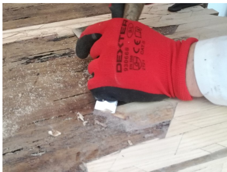
Figura 34 - Nivelamento da terceira de preenchimento
