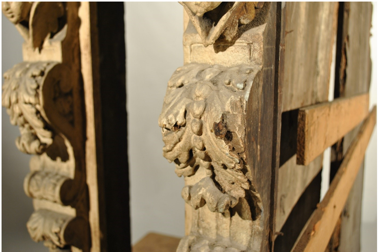
Figura 12 – Fotografia de pormenor dos elementos decorativos e das traves de reforço adicionadas posteriormente à execução da obra
