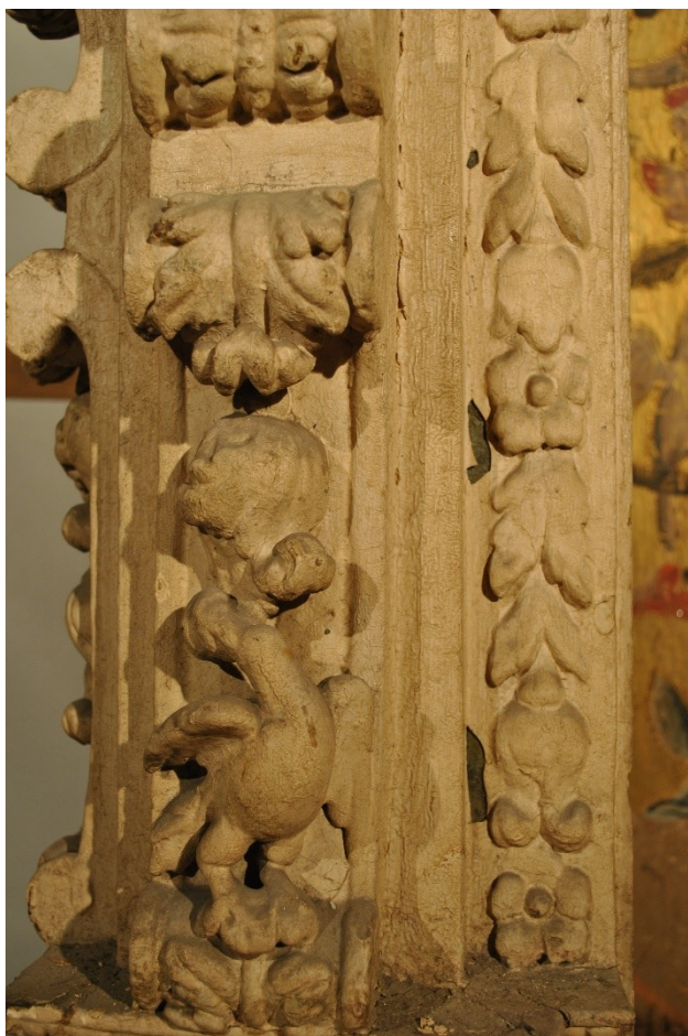
Figura 15 - Fotografia de detalhe do efeito dos repintes sobre a volumetria da obra
