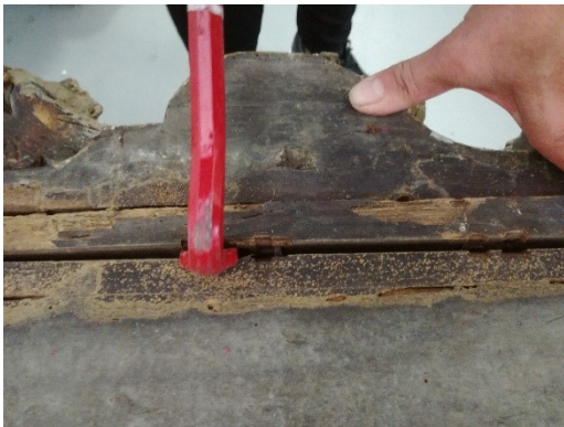
Figura 22 - Remoção dos painéis decorativos com recurso a pé de cabra
