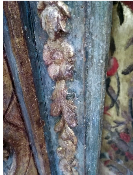
Figura 5 - Intervenção anterior - Novo trinco
