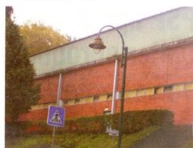
O Pavilhão multiusos
