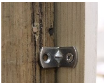
Figura 55 Exemplar de um dos elementos metálicos em "L" aparafusado à moldura suplementar para reforço de união entre molduras pelo reverso
