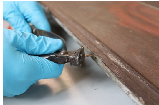
Figura 28 Remoção dos pregos com alicate
