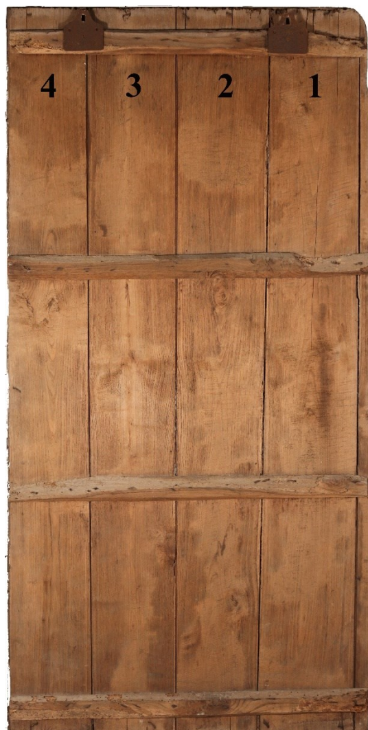
Figura 12 Visão geral do verso da obra com identificação das quatro pranchas
