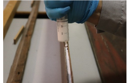
Figura 34 Colocação de adesivo Vinavil® 59 com seringa na ranhura de união das pranchas
