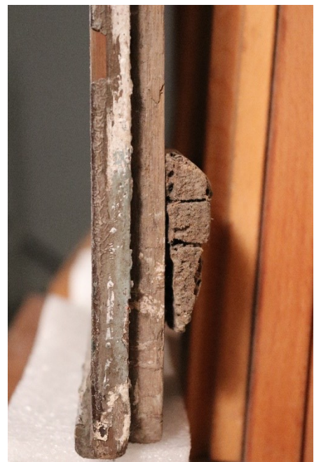
Figura 25 Pormenor lateral da obra com moldura, prancha e travessa de união
