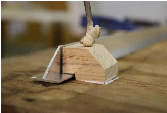
Figura 38 Pormenor de taco de madeira colado com Vinavil 59 para fixação do perfil de alumínio em forma de "T" invertido
