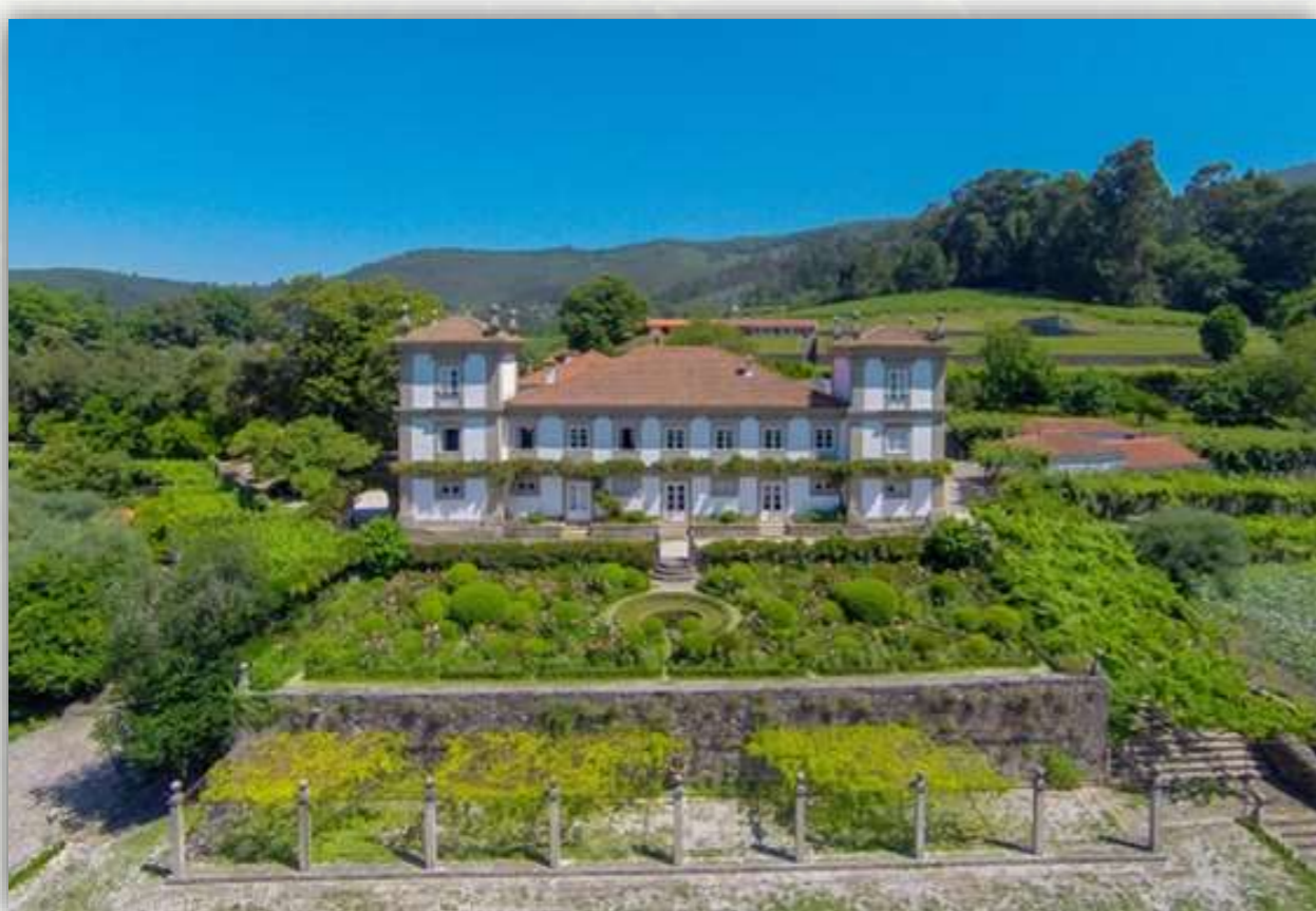
Figure 3: Paço de Calheiros, Ponte de Lima, Portugal
