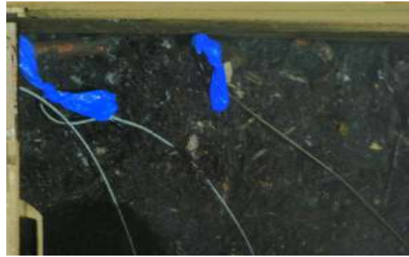
Figura 6.23 - fios de extração identificados em túnel (fitas azuis)
