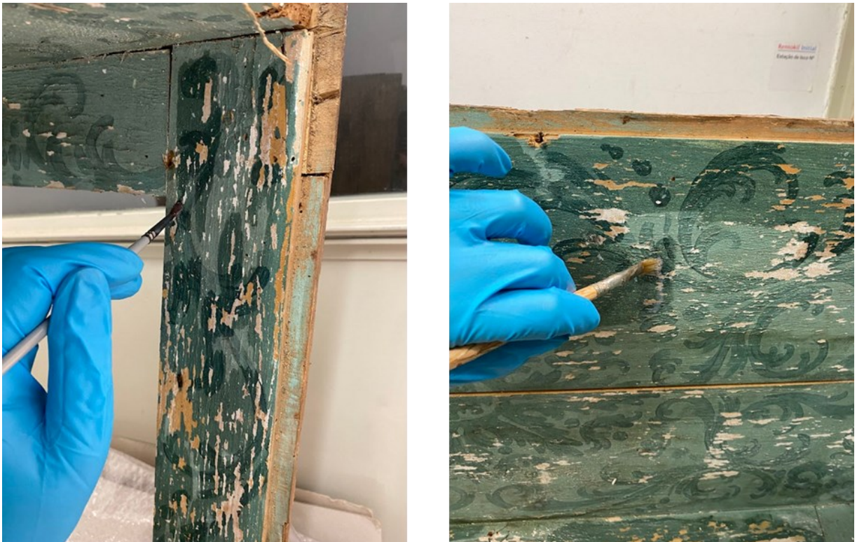
Figura 31 - Fixação da policromia interior com dispersão acrílica. © José Tavares.
