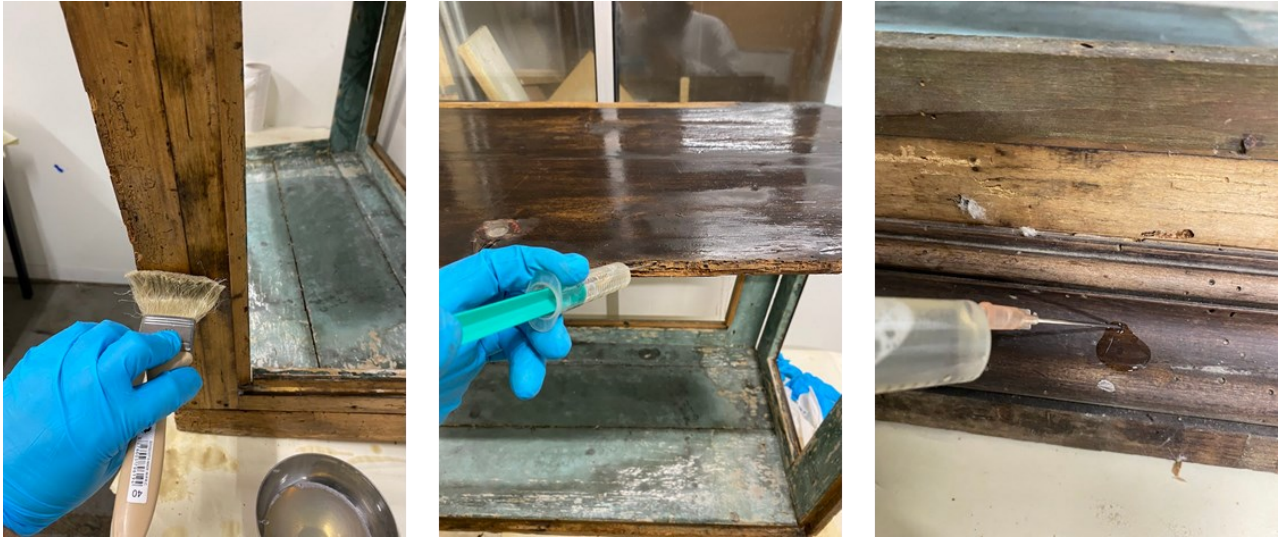
Figura 34 - Desinfestação da estrutura com trincha e seringa. © José Tavares.
