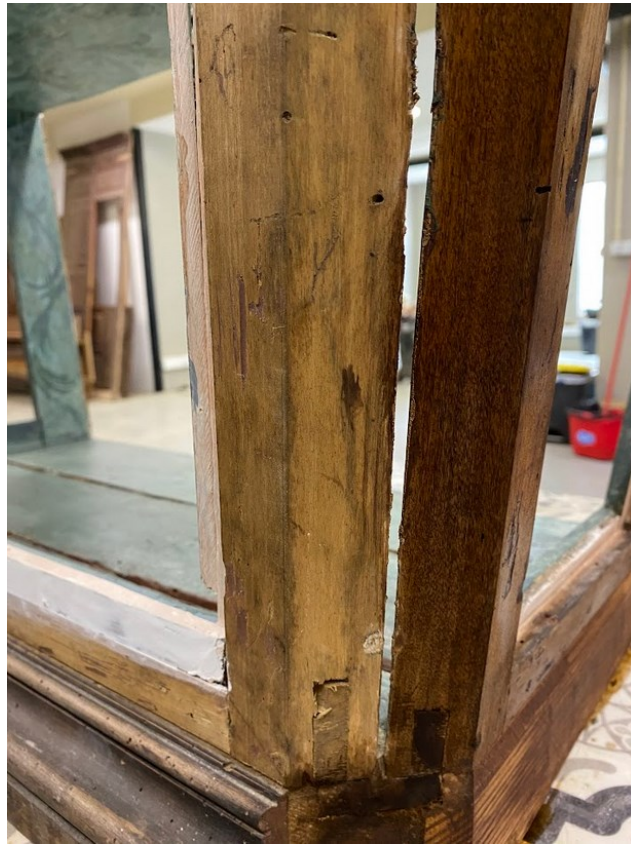
Figura 45 - Distinção entre superfície ainda sem velatura e superfície com velatura já aplicada. © José Tavares.
