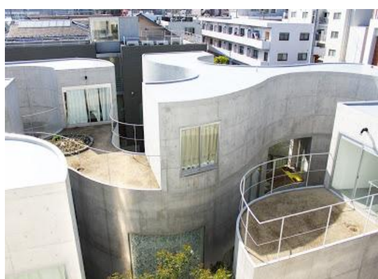
Figura 81 - Forma curvilínea do edifício.
