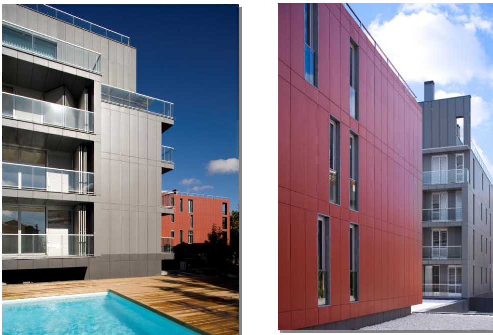
Figura 97 - Fachada do bloco A e fachada do bloco B.
