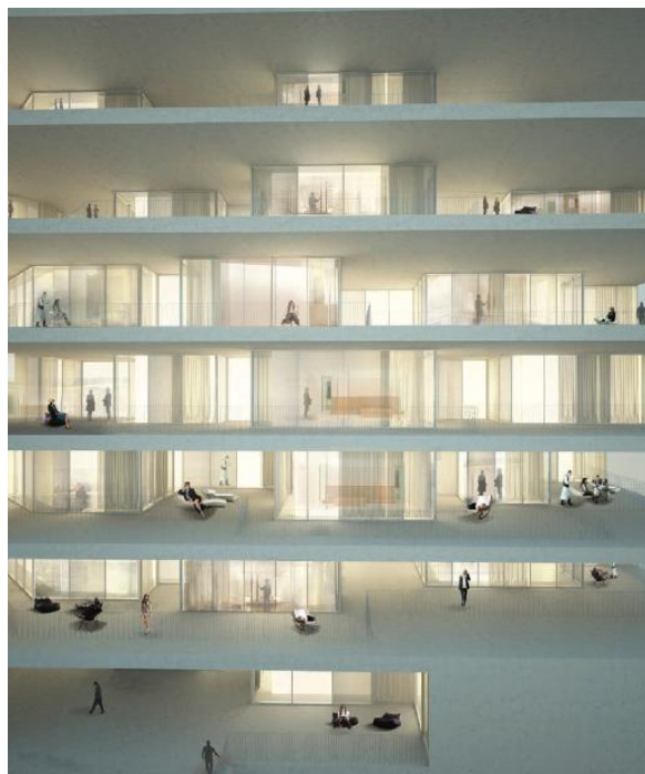
Figura 88 - Fachada do edifício.
