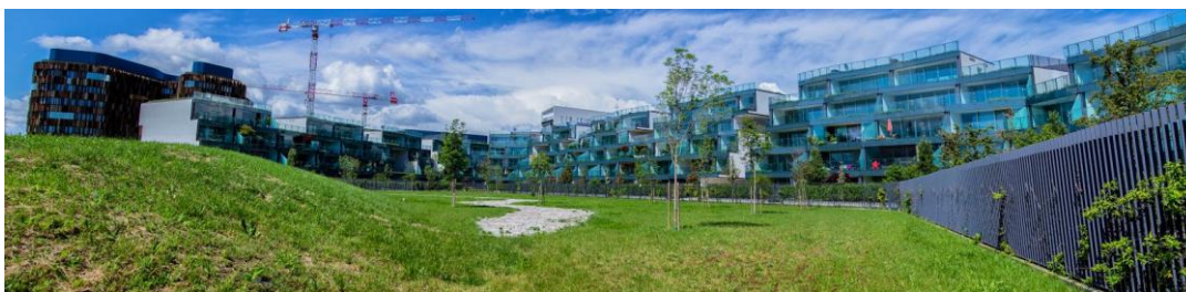
Figura 47 - Vista do Complexo habitacional Milanofiori.
