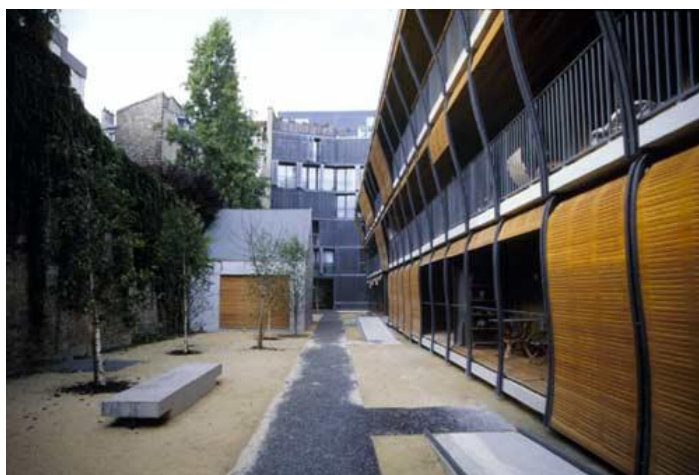
Figura 72 - Vista da fachada do jardim da Rue des Suisses olhando ao longo das varandas do bloco jardim. Fonte disponível em: http://housingprototypes.org/project?File_No=FRA023
