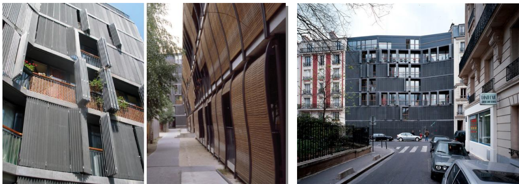
Figura 66 - Fachada dos edifícios.
