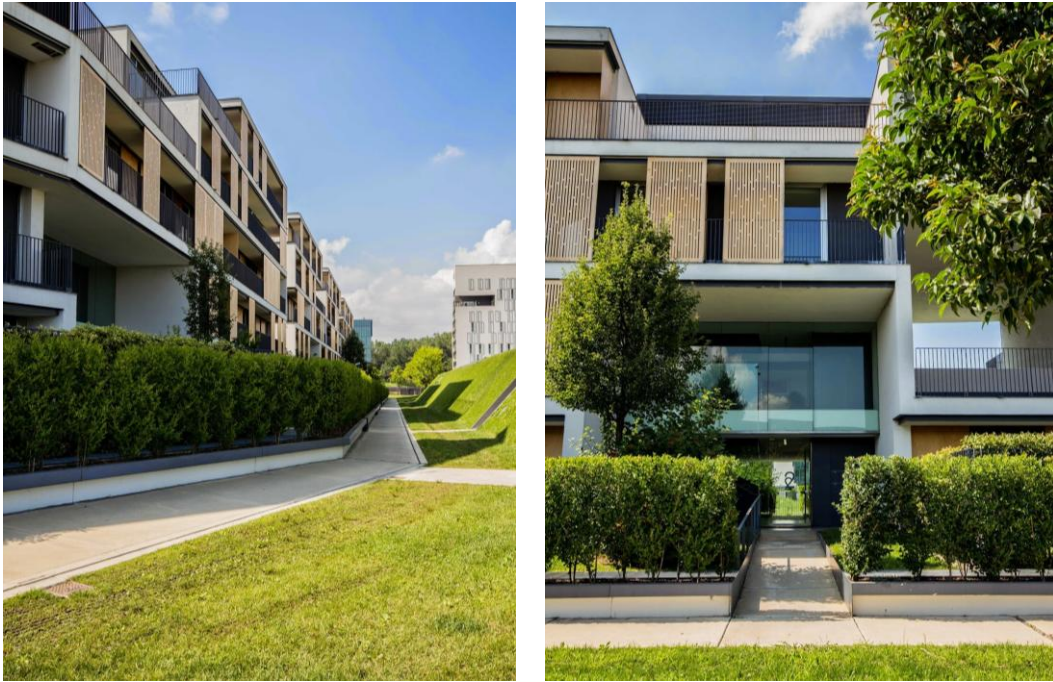
Figura 48 - Fachada painéis em madeira.
