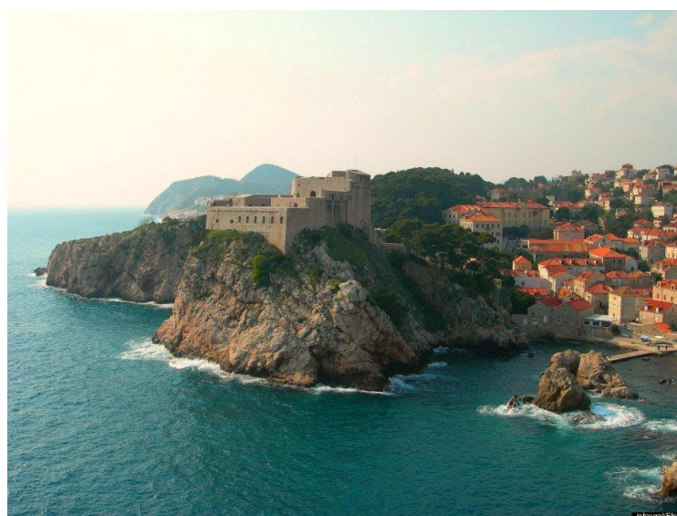
Figura 168 - Muro do castelo de Dubrovnik, Dubrovnik, Croácia.
