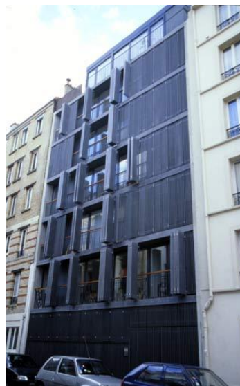
Figura 71 - Fachada da Rue Jonquoy. Fonte disponível em: http://housingprototypes.org/project?File_No=FRA023
