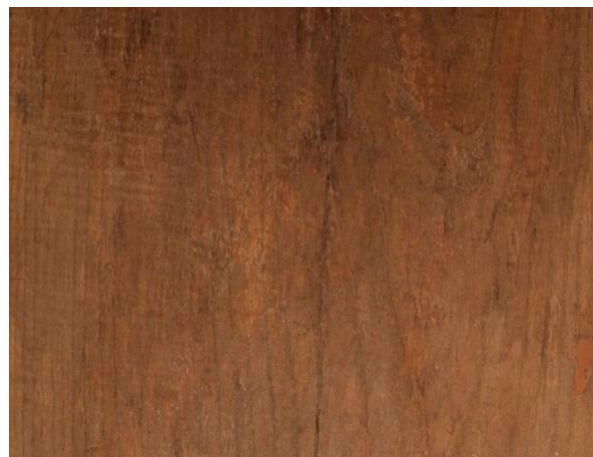
Fig.AIV. 2 – Pormenor das fissuras que acompanham os veios da madeira, da pintura a óleo, sobre tábuas, Flagelação de Cristo .
