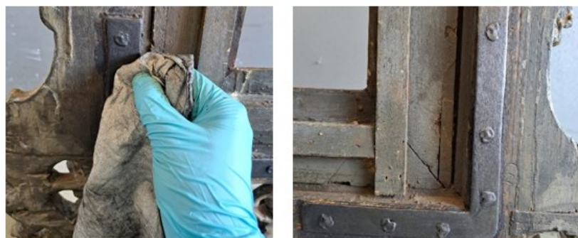
Fig. 21 – (1) Aplicação de pasta cerosa para tratamento de ferro fundido. (2) Elemento metálico depois de tratamento. Mafalda Noverça© 2022
