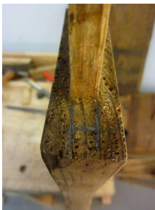
Fig. 252 Pormenor do tratamento da Grade - marcação das zonas de corte para adaptação dos encaixes
