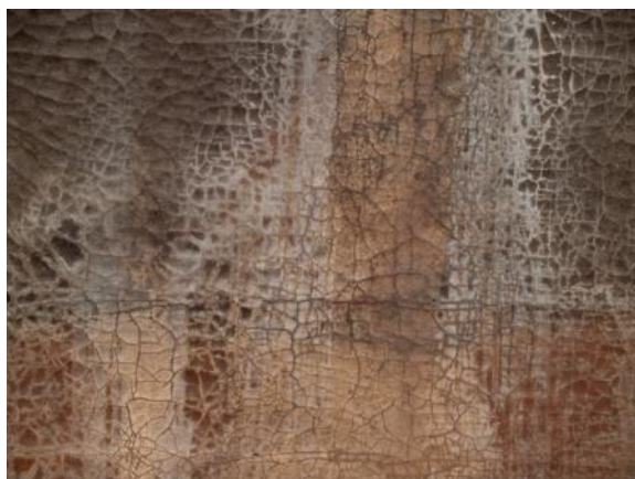
Fig. 56 Fotografia da obra antes do tratamento - Pormenor
