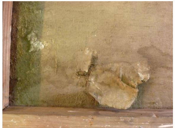
Fig. 78 Fotografia da obra antes do tratamento - Pormenor
