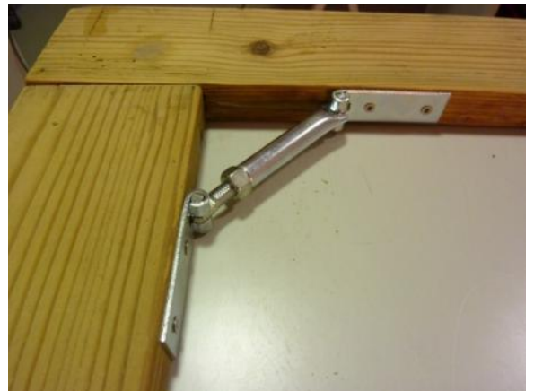
Fig. 263 Pormenor do tratamento da Grade - colocação dos extensores metálicos
