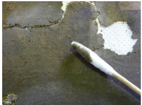
Fig. 138 Pormenor do tratamento da pintura - Limpeza química da sujidade
