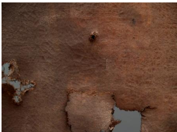
Fig. 55 Fotografia da obra antes do tratamento - Pormenor
