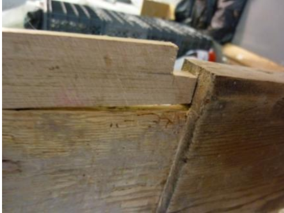
Fig. 257 Pormenor do tratamento da Grade - excerto de madeira para adaptação dos encaixes
