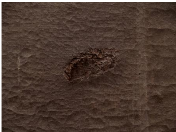
Fig. 51 Fotografia da obra antes do tratamento - Pormenor
