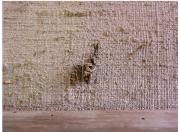
Fig. 70 Fotografia da obra antes do tratamento - Pormenor
