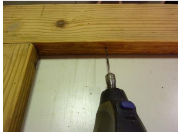
Fig. 261 Pormenor do tratamento da Grade - colocação dos extensores metálicos
