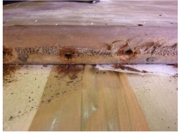
Fig. 122 Pormenor do tratamento da pintura - remoção das taxas metálicas para remoção da grade
