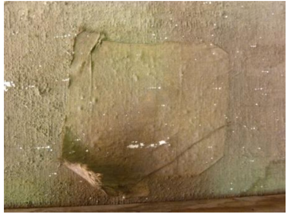
Fig. 68 Fotografia da obra antes do tratamento - Pormenor
