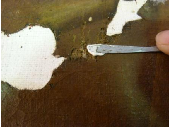
Fig. 191 Pormenor do tratamento da pintura - aplicação de massas de preenchimento
