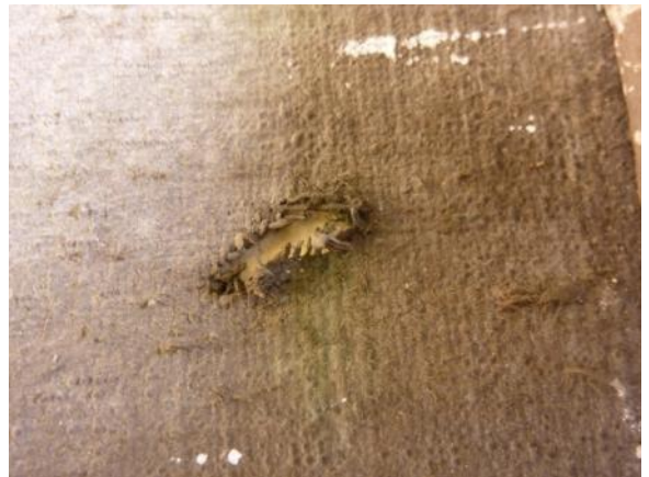
Fig. 72 Fotografia da obra antes do tratamento - Pormenor
