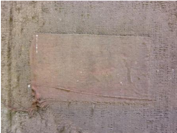
Fig. 75 Fotografia da obra antes do tratamento - Pormenor
