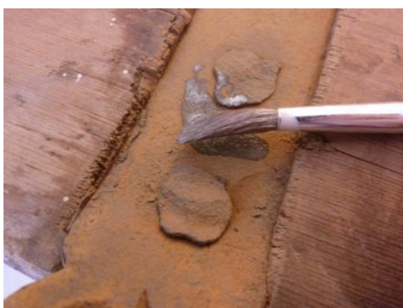
Fig. 267 Pormenor do tratamento da Moldura - Aplicação de conversor de óxidos
