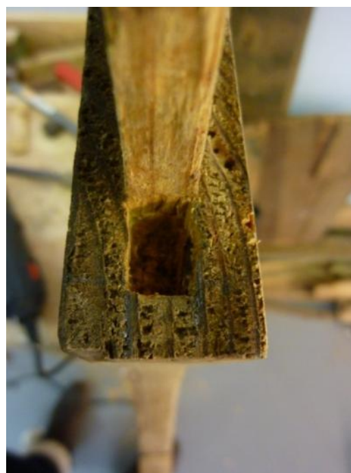
Fig. 256 Pormenor do tratamento da Grade - abertura de caixa para adaptação dos encaixes
