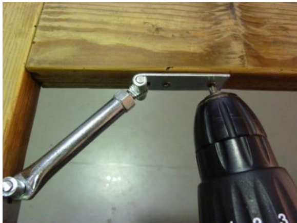
Fig. 262 Pormenor do tratamento da Grade - colocação dos extensores metálicos
