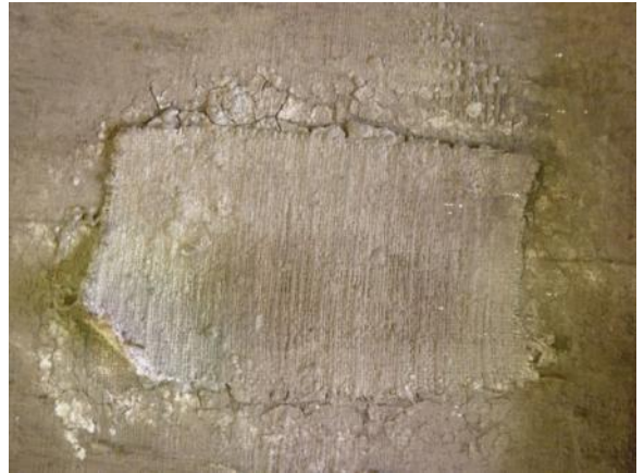
Fig. 76 Fotografia da obra antes do tratamento - Pormenor
