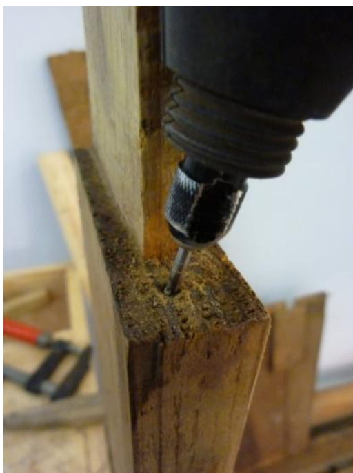
Fig. 253 Pormenor do tratamento da Grade - abertura de caixa para adaptação dos encaixes
