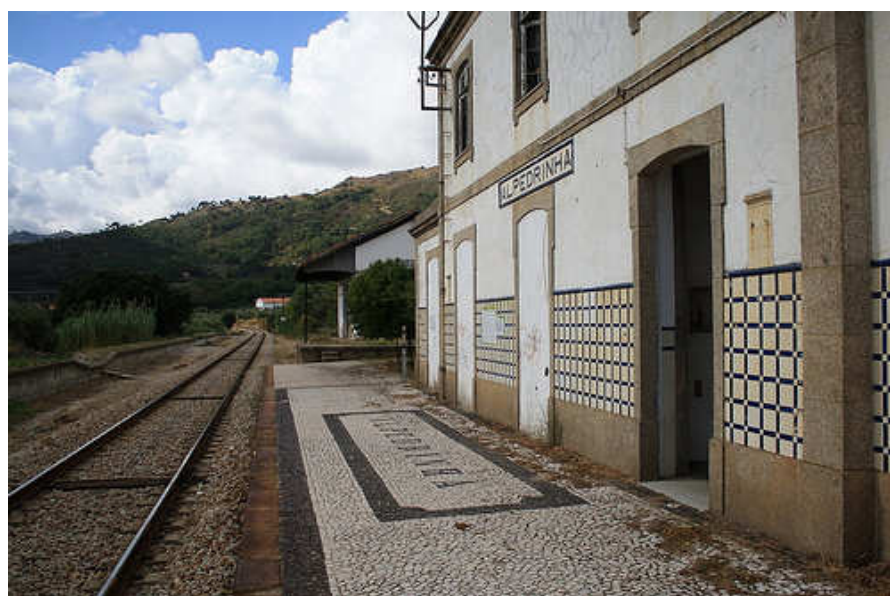
Ilustração 86: Exemplo Estação Serra Estrela (Estação Alpedrinha)
