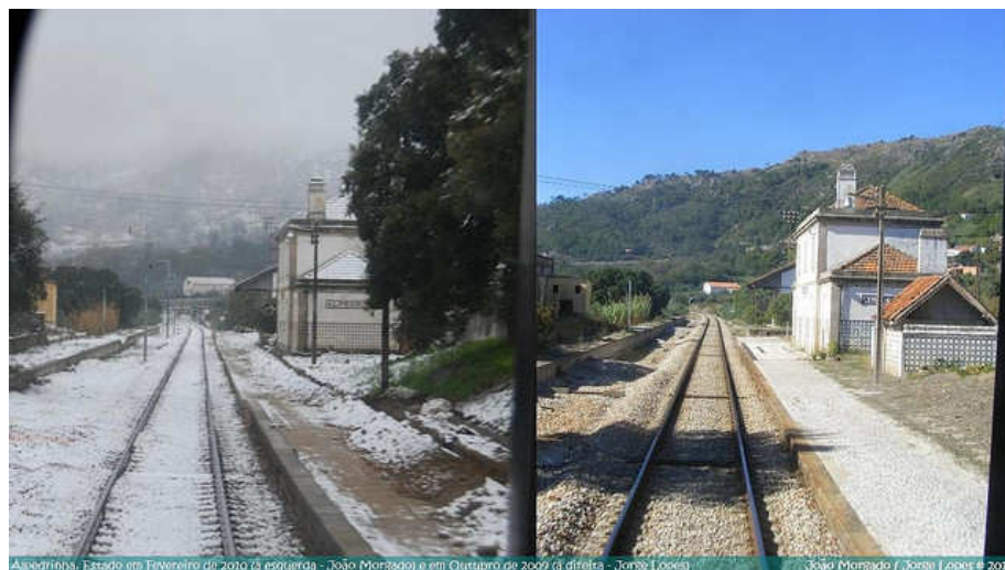
Ilustração 85: Exemplo Estação Serra Estrela (Estação Alpedrinha)
