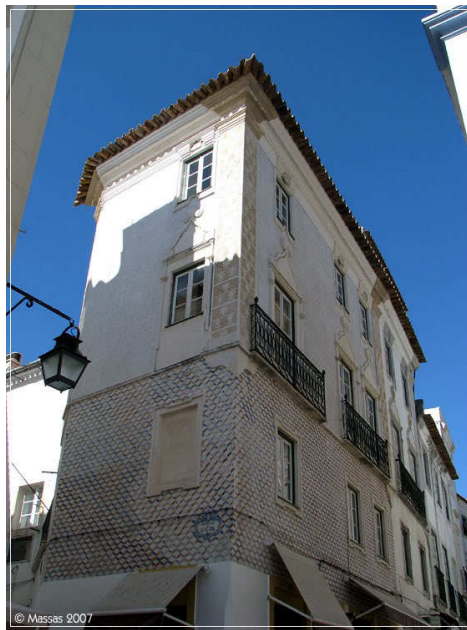
Ilustração 60: Pormenor Edifício Rua da Selaria (actualidade)
