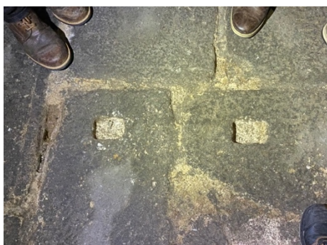
Figura 29: Orifícios de encaixe de prumos verticais. Retábulo-mor Igreja de São Francisco do Porto Autoria: Soraia Martins
