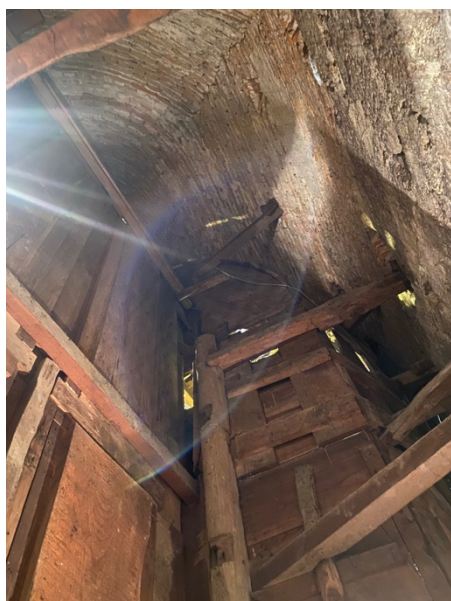
Figura 59: Zonas às quais não foi possível o acesso para medições Autoria: Soraia Martins
