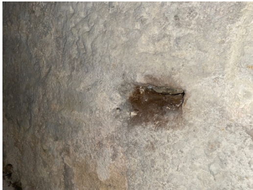
Figura 47: Orifício para fixação das vigas na alvenaria Autoria: Soraia Martins
