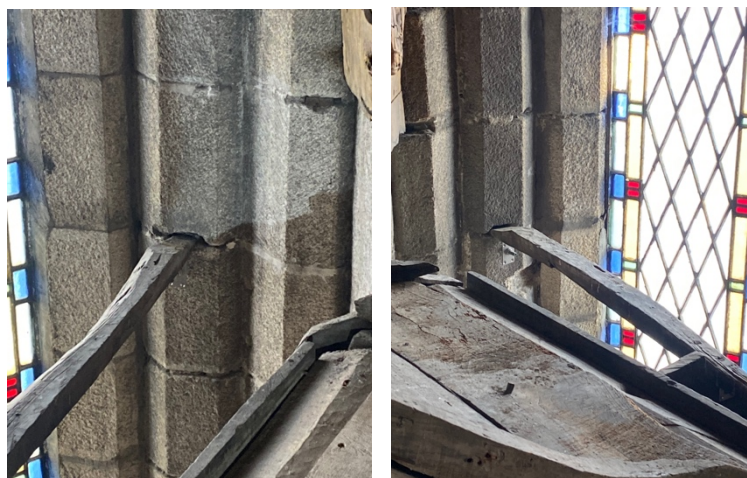
Figura 12: Estado de fixação às paredes das vigas de estabilização do retábulo-mor da Igreja de São Francisco no Porto Autoria: Soraia Martins
