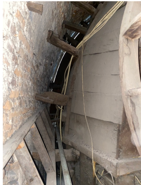
Figura 52: Sistema elétrico e objetos colocados na estrutura Autoria: Soraia Martins
