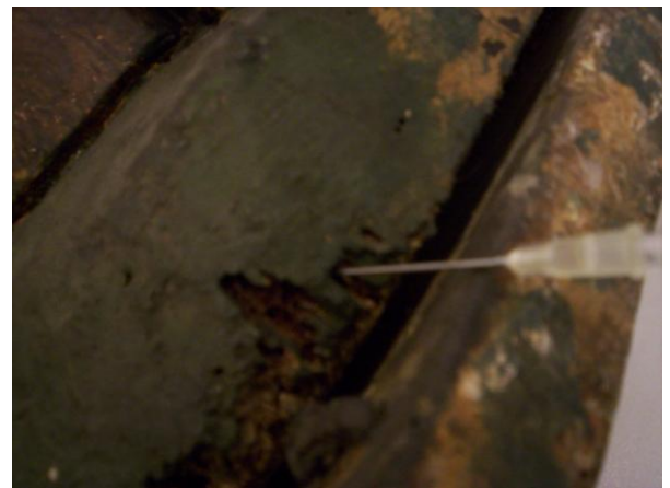
Figura 74: Realização da consolidação por injeção
