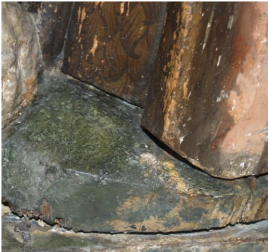
Figura 77: limpeza da camada superficial de sujidade na peanha
