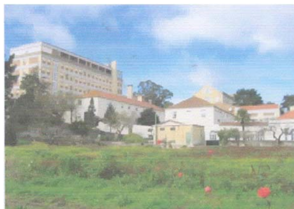
Figura 1 - Vista geral dos edifícios principais da Casa de Saúde da Idanha.
