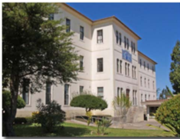
Figura 2 - Vista exterior (nascente) da Casa de Saúde do Telhal.
