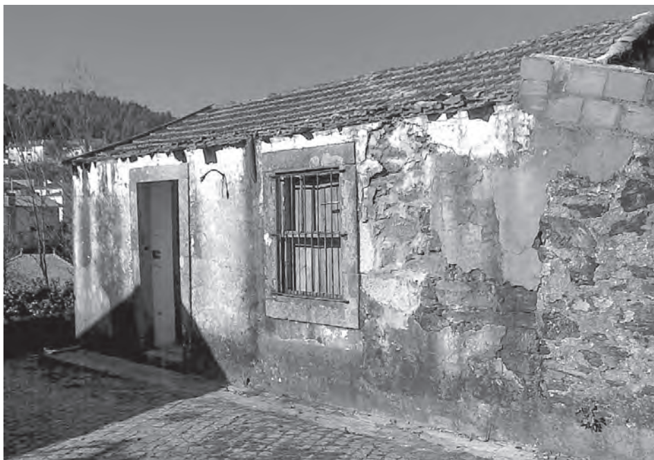
Primeiro edifício escolar da freguesia, antes da reconstrução.
