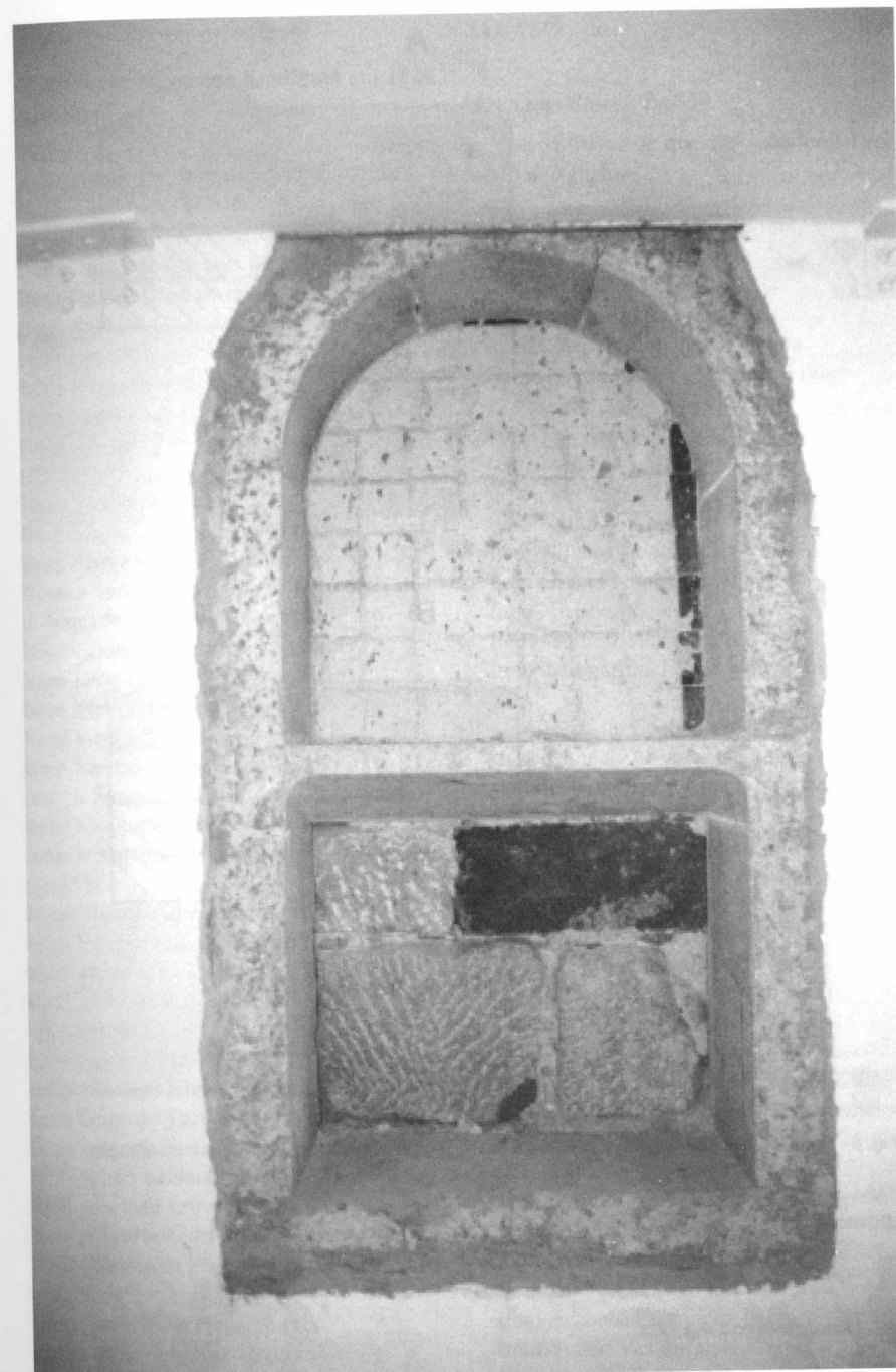
Fig. 7 - O nicho aberto na parede nascente de uma divisão das traseiras da casa.
