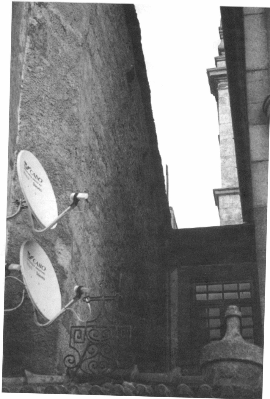
Fig. 4 - Parede lateral do prédio da rua de S. Bento da Vitória que, provavelmente, pertenceu à antiga igreja.
