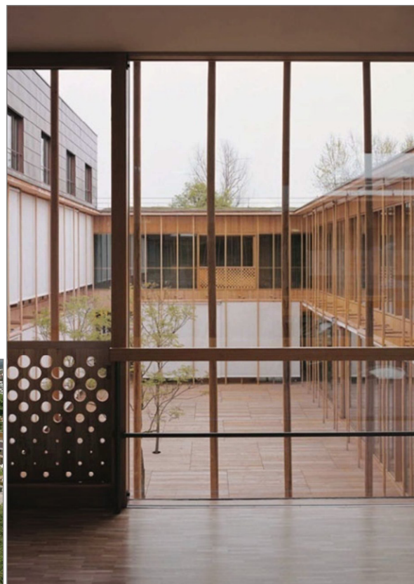
Fig.65 –Interior do pátio do Centre for SpinalCordandBrain Injuries , (2002), REHAB, de Herzog & de Meuron , em Basel, Suíça.
