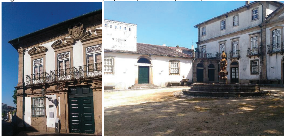
Figura 48. Fachada externa (esquerda) e interna (direita) do Museu dos Biscainhos.
