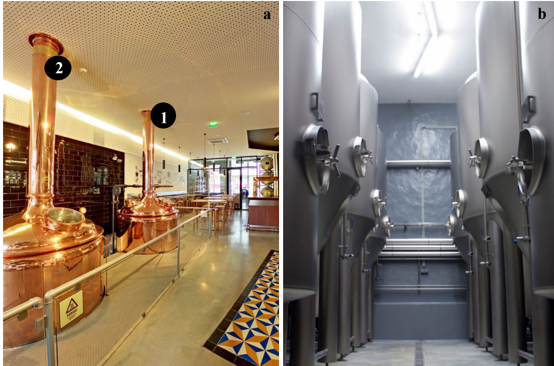
Figura 3 a) Caldeiras de produção: 1- Caldeira de brassagem; 2- Caldeira de filtração e ebulição. b) Tanques de produção.
