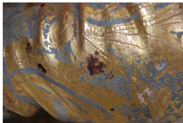
Fig. 10 - Pormenor da oxidação de um elemento de ligação metálico exposto do busto do Santo Inocente.
