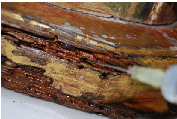
Fig. 5 - Consolidação por injeção da peanha de São Lourenço.
