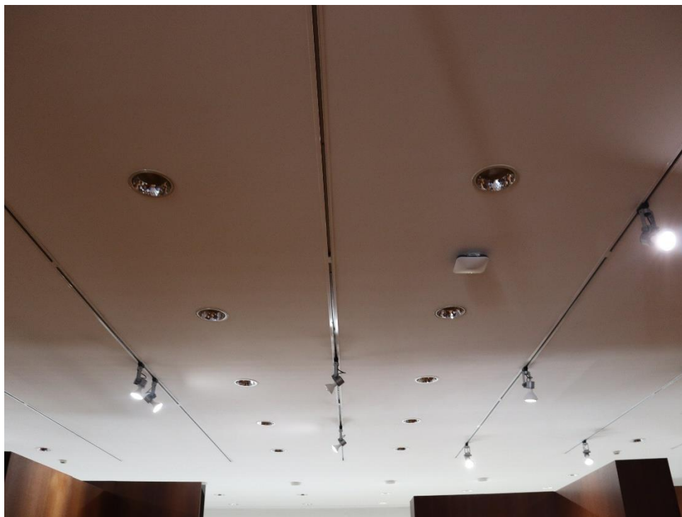
Fig. E7.1 – Fotografia de pormenor dos focos direccionáveis de luz LED que incidem superior e individualmente em cada vitrine, com o que aparenta ser uma distância mínima de três metros, com temperatura de cor branca.
