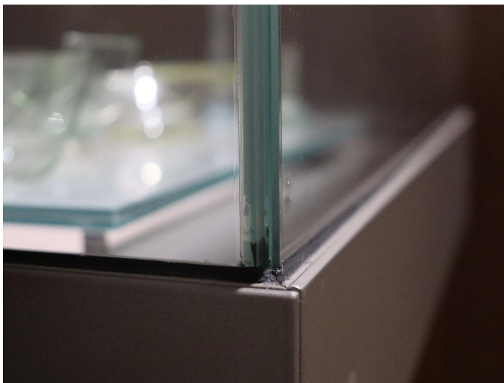
Fig. E7.4 – Fotografia de pormenor do material selante com indícios de degradação, entre os vidros da vitrine, e a caixilharia que a suporta. Esta degradação põe em causa a hermeticidade da vitrine e a libertação de potenciais poluentes e demais gases que podem comprometer o ambiente interior, afetando direta ou indiretamente as peças nela expostas.
