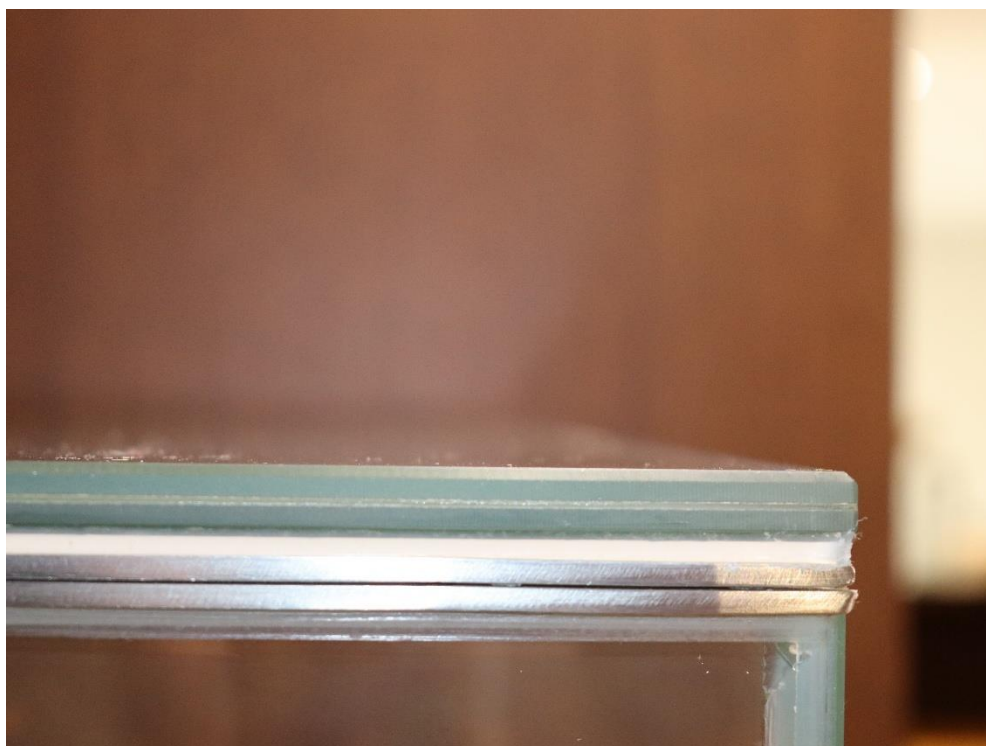
Fig. E7.3 – Fotografia de pormenor da composição e estrutura da campânula da vitrine 1.10: vidro duplo, painel de iluminação LED (com potência de 12W/12V, temperatura de cor de 4000K (branco natural), índice de reprodução cromática superior a 90 (CRI >90) e sistema de regulação (dimmer)), e aço laminado duplo.
