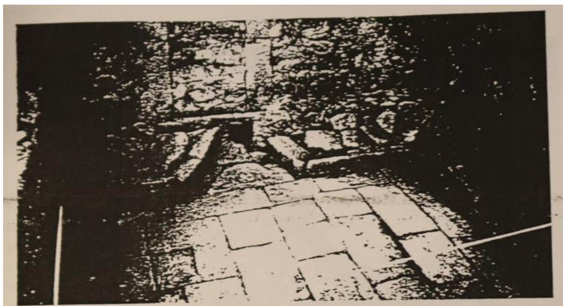
Sala tipo sub-cave, pavimentada com lajes, por onde originalmente se fazia a comunicação entre o Claustro do Refeitório e a Cerca
