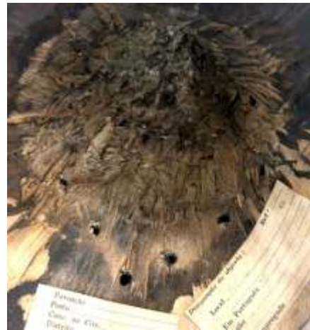
Fig. 3- Interior com desagregação, destacamento e lacunas circulares.
