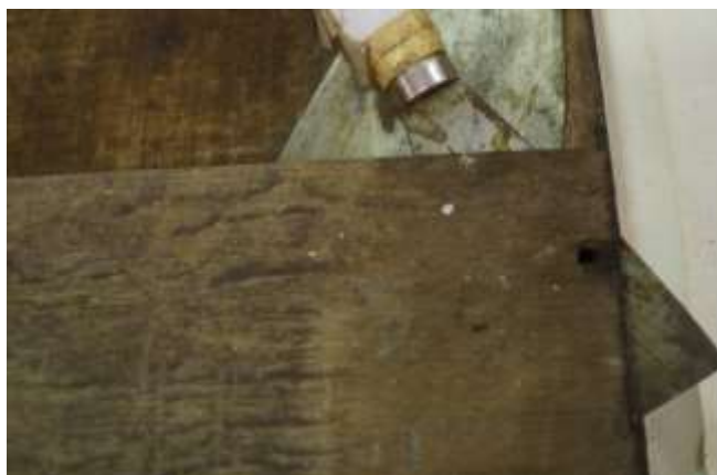
Figura 31 - Remoção da trave disposta na aresta superior da pintura unida à moldura.
