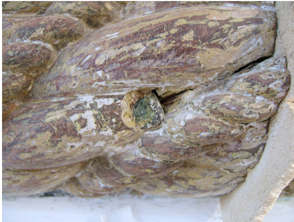
Estado de conservação: presença de elementos metálicos.
