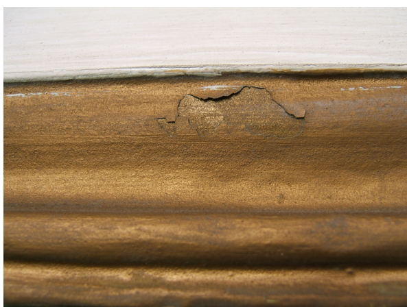
Estado de conservação: levantamento e destacamento das camadas sucessivas de purpurinas
