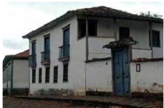
Figura 16 - Museu do Ouro – Sabará/MG. Instalado na antiga Casa de Intendência e Fundação do Ouro da Vila Real de Nossa Senhora da Conceição do Sabará, o Museu do Ouro foi criado em 1945 e oficialmente inaugurado no dia 16 de maio de 1946. A instituição ocupa uma área total de 1.456 m 2 , sendo 714 m 2 de área edificada. O acervo totaliza 749 objetos, constituídos: mobiliário, armaria, porcelanas, imaginária religiosa e objetos ligados a prática da mineração (séculos XVIII e XIX). O Museu do Ouro possui ainda um arquivo histórico e uma biblioteca, localizados na Casa de Borba Gato, edificação do século XVIII. A Biblioteca possui 4.972 títulos registrados, entre os quais se encontram obras referentes à formação do Estado de Minas Gerais e do Brasil, arquitetura, história da arte, incluindo valiosa coleção de obras raras com edições que datam do século XVIII. (Fonte: IBRAM)
