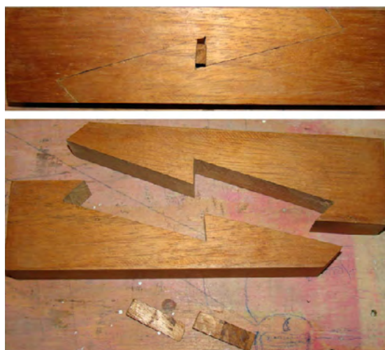
Figura 7 – Detalhe de sambladura tipo mão-de-amigo para prótese em peças estruturais de madeira, utilizada nas tesouras do telhado da Basílica da Penha. Dispensa o uso de metais para compleição de rigidez da peça. Fonte: CECI/nov2008
