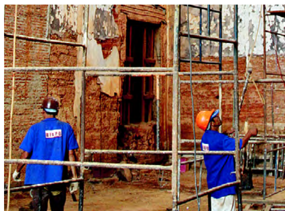
Figura 6 – Refazimento de taipa-de-pilão e de alvenarias de tijolos adobe no restauro da Matriz de Pirenópolis, Goiás. Fonte: Adriano Assunção/Biapo/2007.
