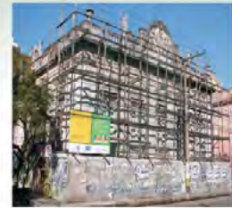
Figura 1 – Fachada casarão Barão de Cacequi. Fonte: Keli Scolari, 2011.
