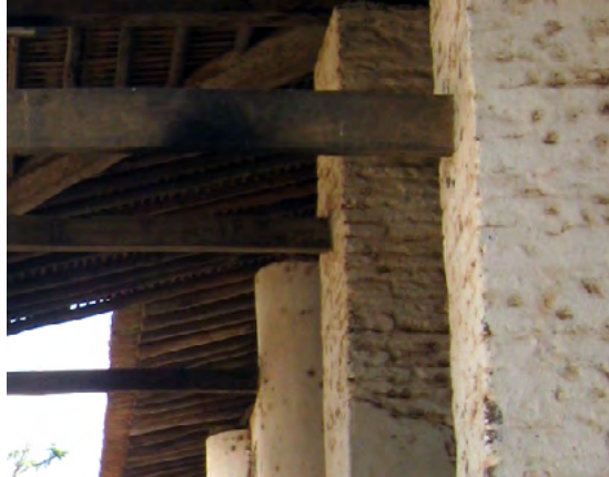
Figura 3 – Aspecto das colunas em alvenaria de tijolos da moita do Engenho Poço Comprido. Fonte: CECI/nov2008
