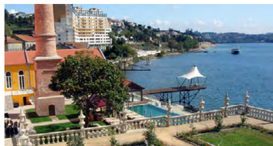
Figura 10 – Antigo cais fluvial do palácio transformado. (Fonte:Pousadas de Portugal)
