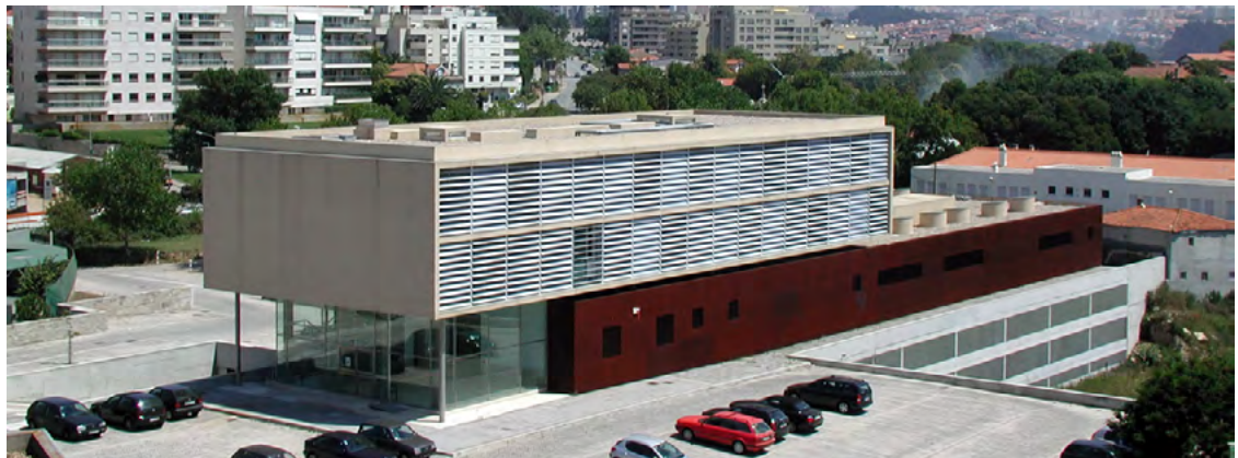
Figura 4 - Edificio de Restauo en la Escola das Artes, UCP, Oporto.
