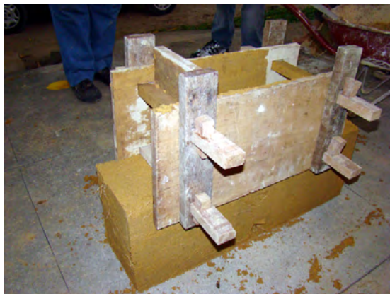
Figura 5 – Processo de confecção de taipa-de-pilão para procedimentos de enxertos e pró-teses. Fonte: Curso Gestão de Restau-ro/CECI/nov2009
