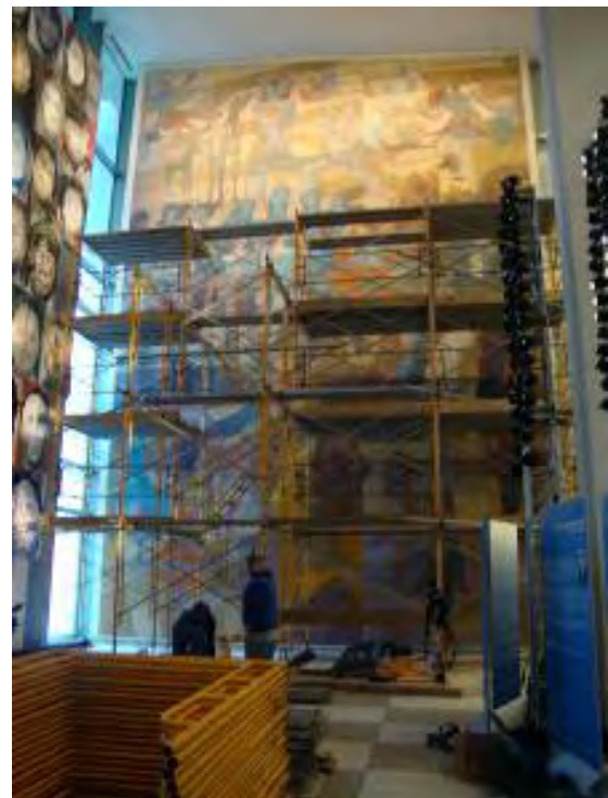
Figura 2 – Desmontagem dos painéis na ONU em novembro de 2010.
