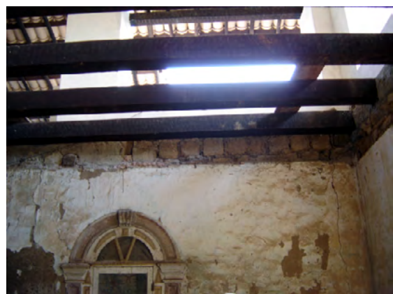
Figura 8 – Consolidação das alvenarias de adobe da capela mor da Igreja de N. Sra. De Be-lém (Cachoeira/Bahia) feita em concreto armado, substituindo-se os esteios de madeira que poderiam ter sido encachorrados com samblagens mão-de-amigo. Fonte: CECI / nov2006
