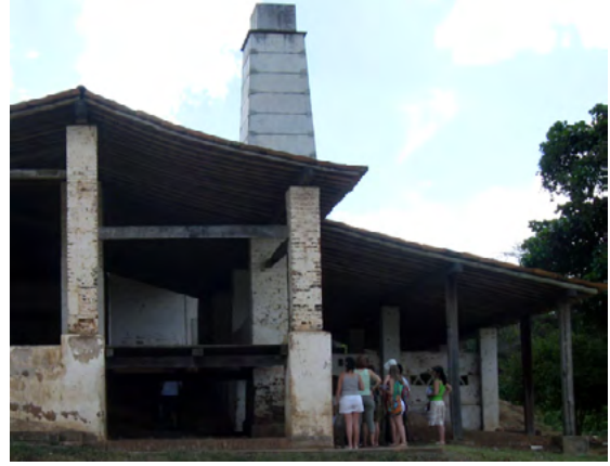
Figura 4 – Detalhe da alvenaria de tijolos da moita do Engenho Poço Comprido. Fonte: CE-CI/nov2008
