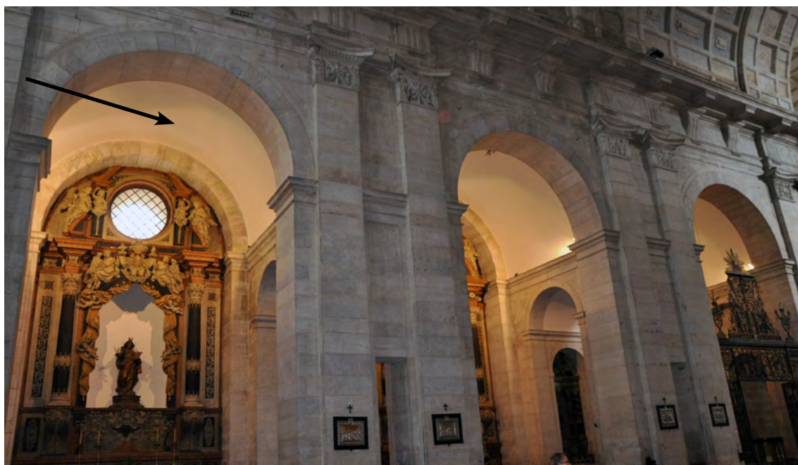
Figura 16 - Abóbadas rebocadas a branco após a destruição dos estuques marmoreados do séc. XIX.
