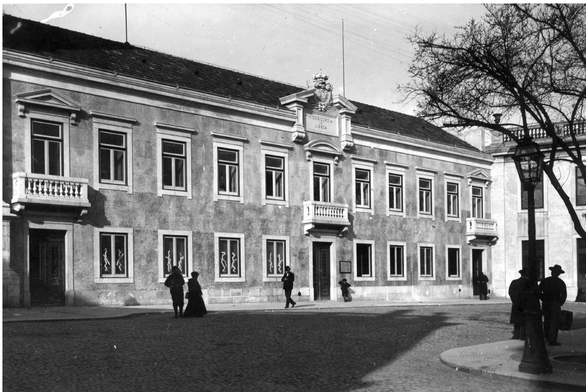
Figura 3 – Fachada principal do edifício da Santa Casa da Misericórdia de Lisboa após a remodelação projectada pelo arquitecto Adães Bermudes, cerca de 1905.
