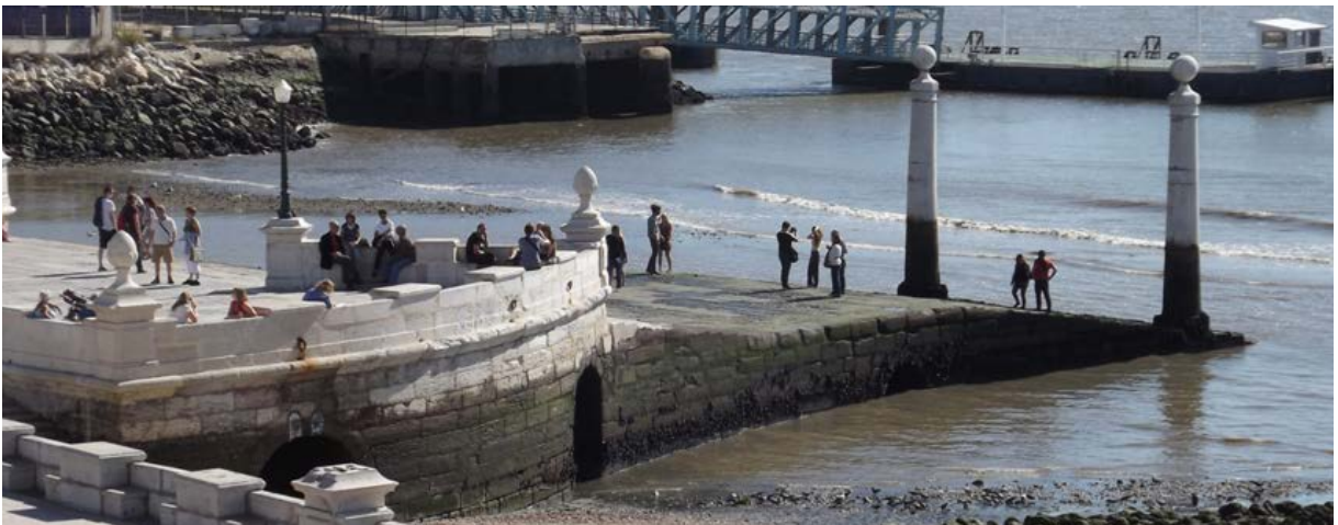
Figura 10 – O Cais das Colunas em baixa-mar, evidenciando total cobertura da área intertidal por colonização biológica, Outubro 2013. [Foto ACA]
