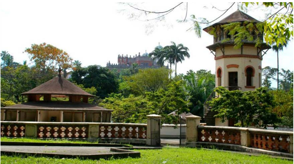
Figura 5 – Vista do Pombal. Fonte: Acervo DPH/COC.
