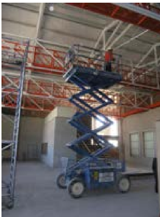
Figura 17 - Museu de Arte Popular. Passadiços para monitorização da cobertura
