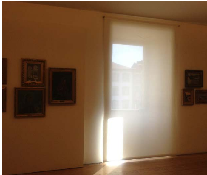
Figura 30 - Exemplo do deficiente isolamento proporcionado pelo material usado na tela de protecção dos vãos da janela.
