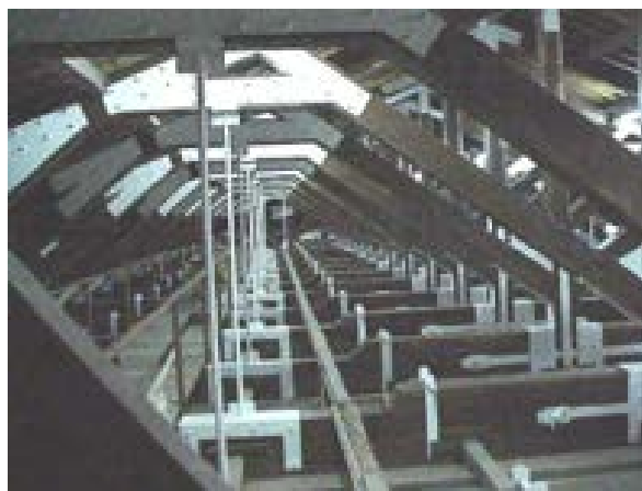
Figura 8 - Museu Nacional dos Coches. Passadiço técnico na cobertura.
