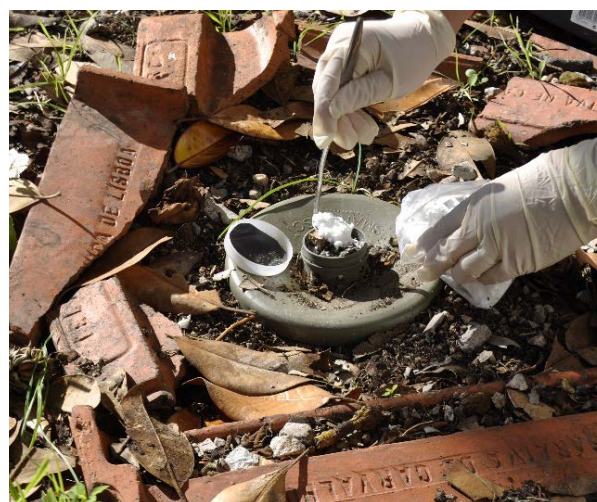
Figura 15 – Colocação de termiticida inibidor de síntese de quitina, Diflubenzuron (0.08%) em excipiente sólido de celulósico, em estação onde foi detetada presença de térmitas vivas.
