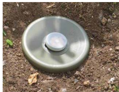
Figura 12 – Estação de localização inserida no solo em torno do AHU.
