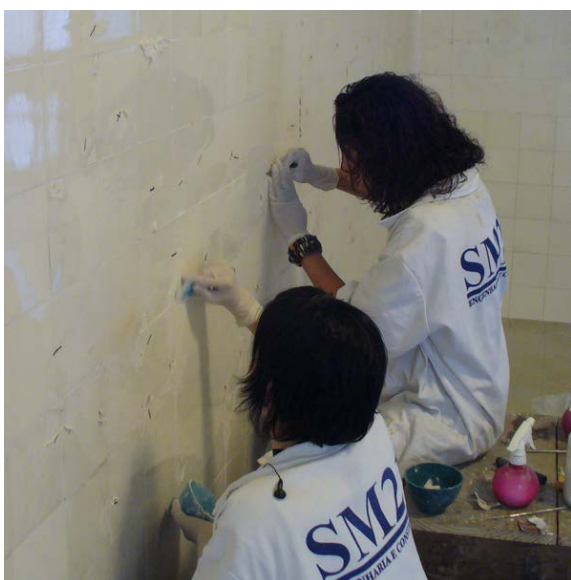
Figura 09 (a,b) – Serviço de recuperação de azulejos imagens durante e após a intervenção. Fonte: Acervo DPH/COC.
