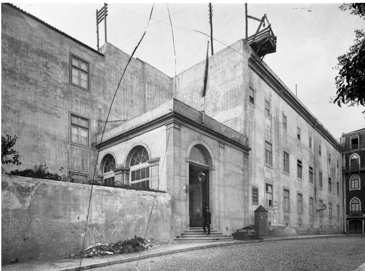
Figura 2 – Edifício do convento de São Francisco onde se instalaram o DLEC, a Academia de Belas-Artes e a Biblioteca Nacional. Foto autor desconhecido. ©AFL, A10638.
