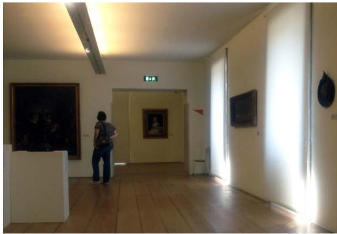
Figura 28 - Plano de sala de exposição onde se nota o excesso de penetração de radiação ultravioleta por deficiente dimensionamento das telas protectoras dos vãos das janelas.
