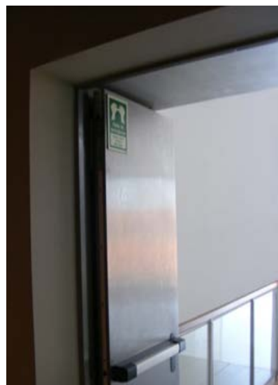
Figura 19 - Perspectiva da antiga Casa do Cabido sobre o passadi o suspenso no segundo piso. A altimetria usada nas protec  es laterais deixa antever risco de seguran a na circula  o.
