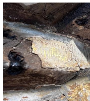
Figura 77- Aspeto final dos elementos metálicos tratados
