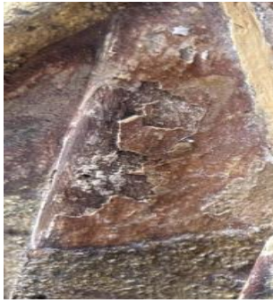
Figura 46- Destacamento de policromia
