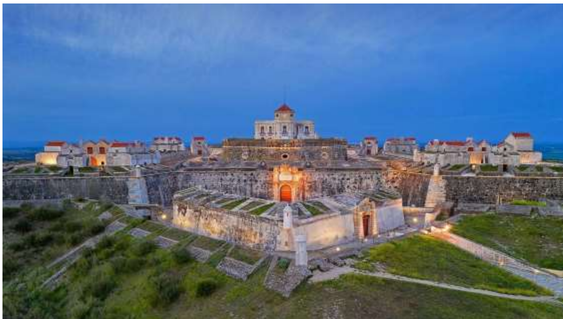
Foto nº 1 – Vista geral da cidade de Elvas 1
