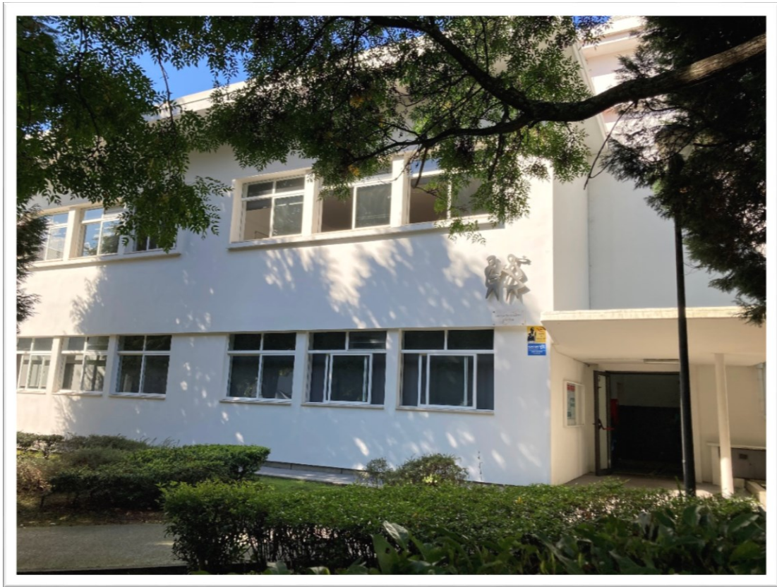
Figura 1: Edifício da Escola Básica do 1.º Ciclo de São Victor
