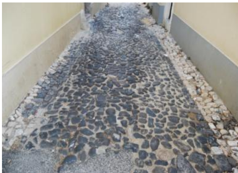
FIGURA 118-TRAVESSA DO NORTE A REPAVIMENTAR
