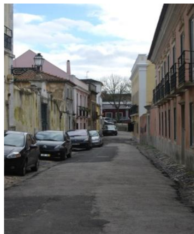
FIGURA 126-RUA DO NORTE (SUL)
