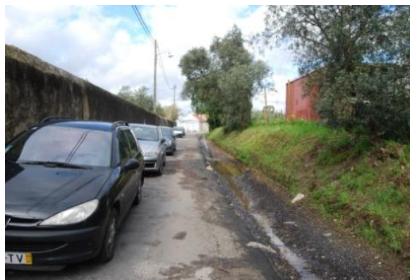
FIGURA 133-DIFÍCIL CIRCULAÇÃO VIÁRIA E DE PEÕES
