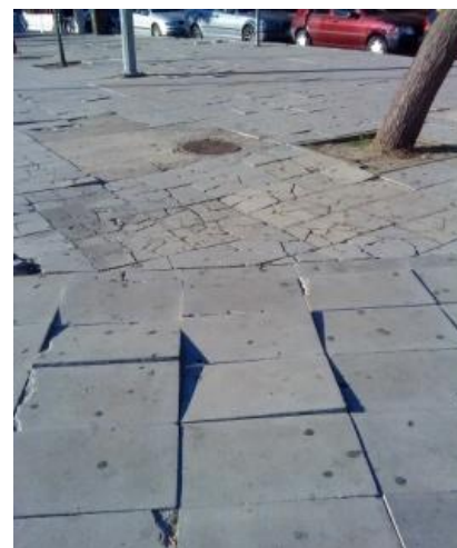
FIGURA 20-PAVIMENTO EM LAGETAS DE BETÃO FOTO DA AUTORA
