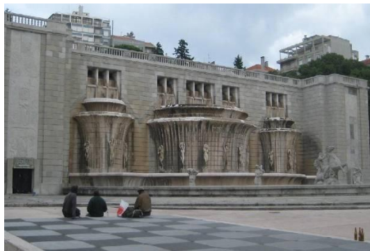
FIGURA 41- FONTE LUMINOSA "SECA" E SEM ILUMINAÇÃO
